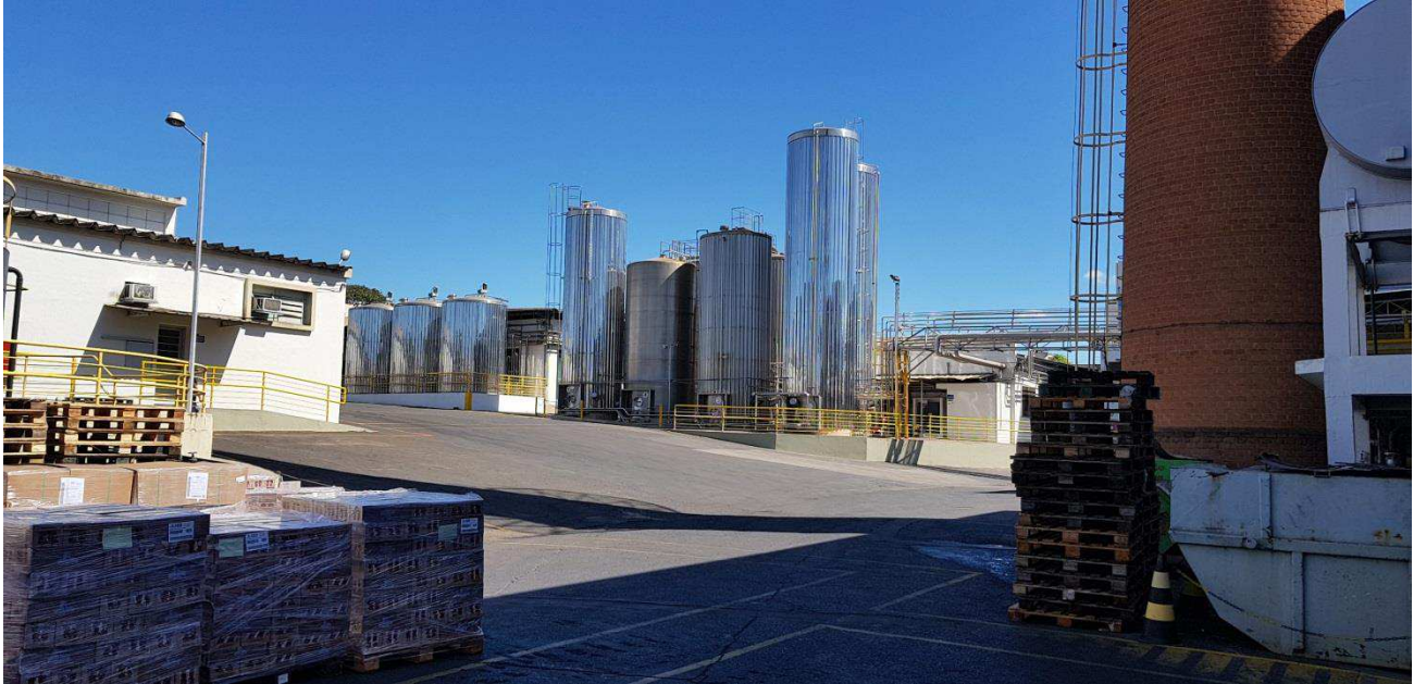
Tanques de produto
