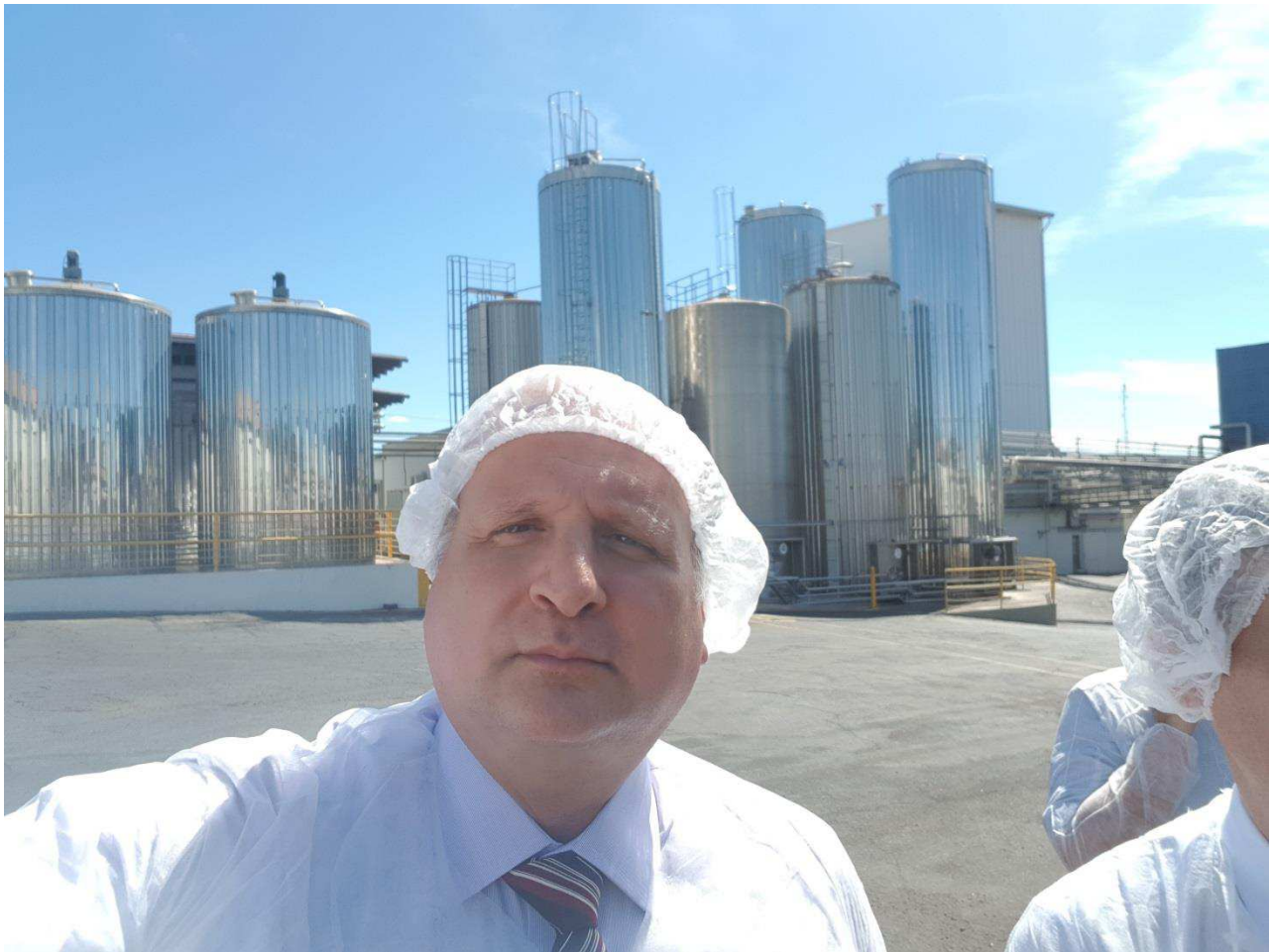
Tanques de produto
