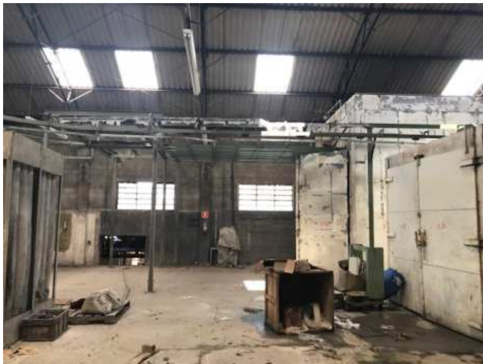
Foto 13 - Vista interna do superior do galpão principal, de outro ângulo.
