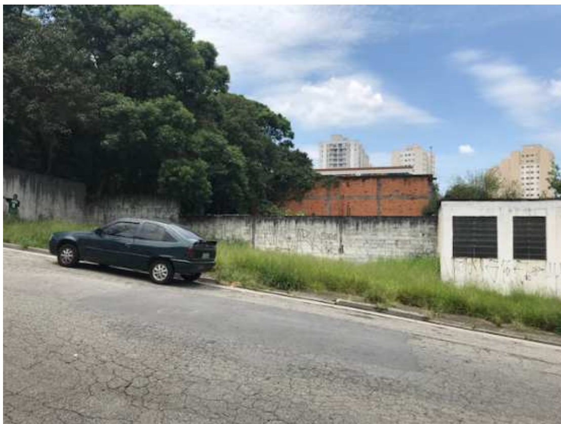
Alinhamento predial parcial do imóvel na Rua Oneda.
