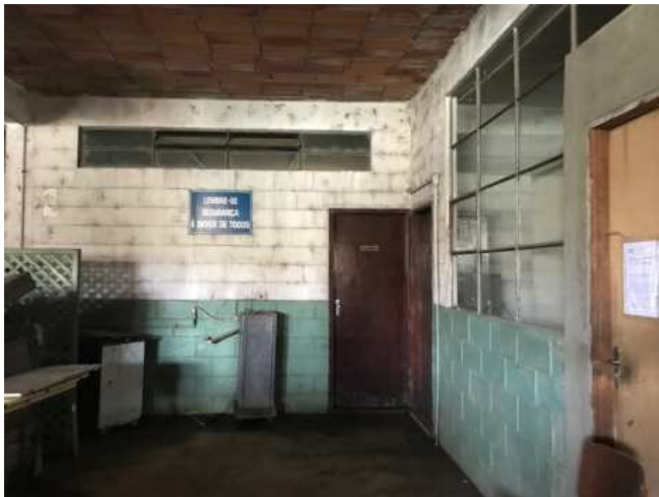
Foto 07 - Acesso ao laboratório, no térreo do galpão principal.
