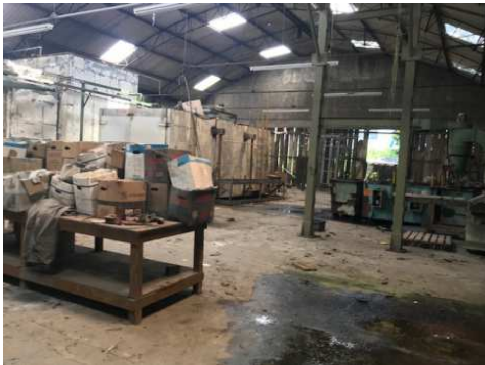
Foto 11 - Vista geral interna do superior do galpão principal.
