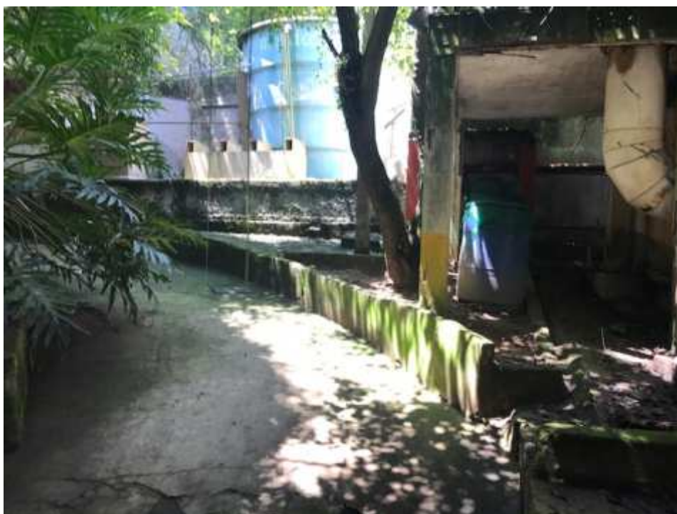
Foto 16 - Calçamento junto aos fundos do galpão principal - acesso aos reservatórios de água, zeladoria e área reservada.
