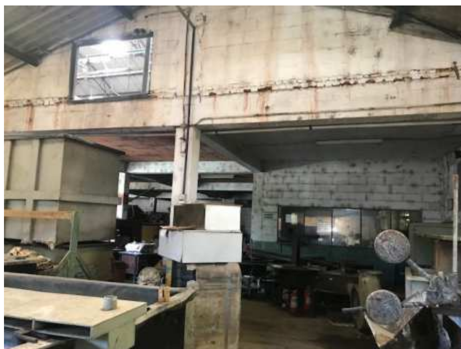
Foto 04 - Ligação interna entre o galpão anexo e o principal.
