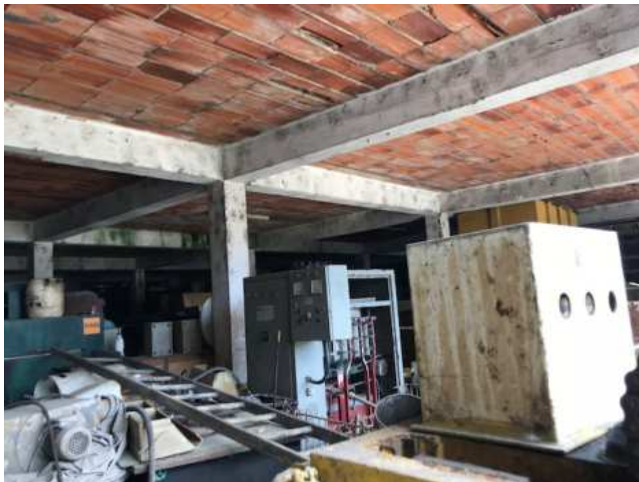
Foto 09 - outra vista do térreo do galpão principal.
