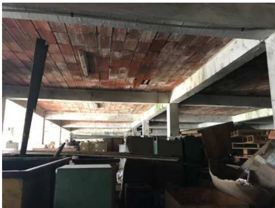
Foto 08 - Vista geral interna do térreo do galpão principal.
