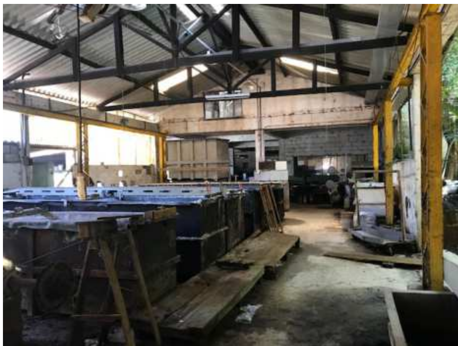
Foto 03 - Vista interna do galpão anexo.
