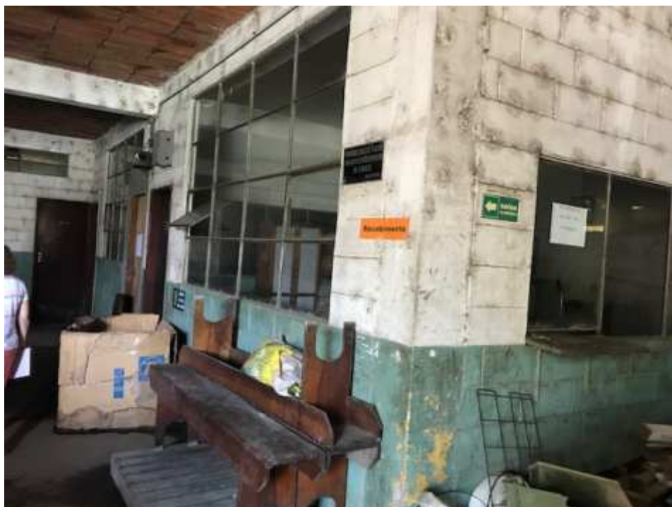
Foto 05 - Salas administrativas no térreo do galpão principal.
