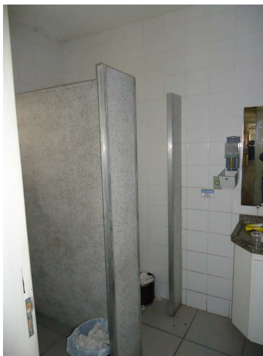
VISTA DO BANHEIRO PARA FUNCIONÁRIOS.
