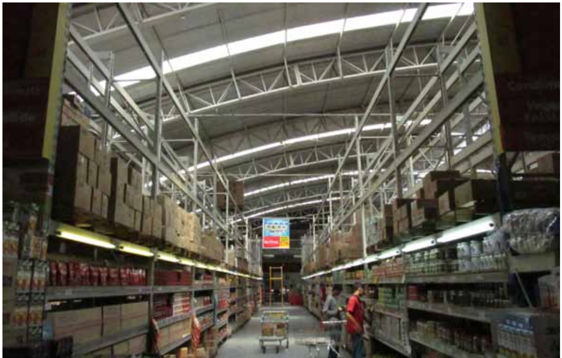
Estrutura da cobertura
