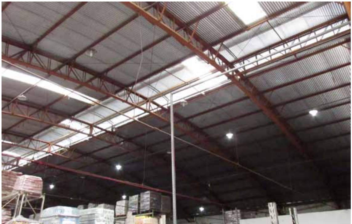
Estrutura e cobertura do depósito
