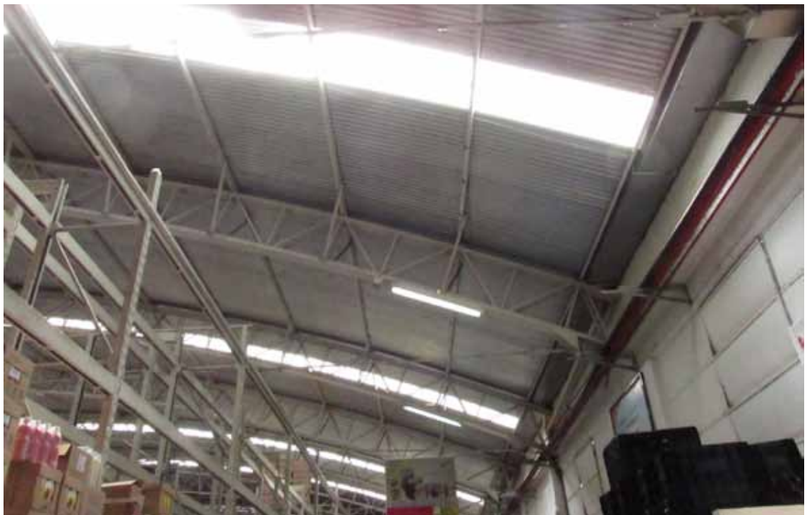
Estrutura da cobertura
