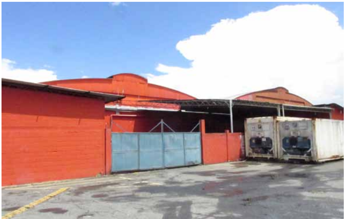
Fundos - recebimento de mercadorias e sistemas de refrigeração
