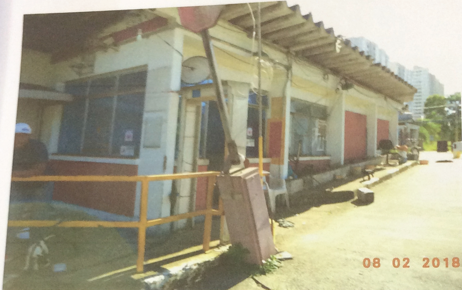
Foto 49 - Prédio 10 - Portaria Principal
