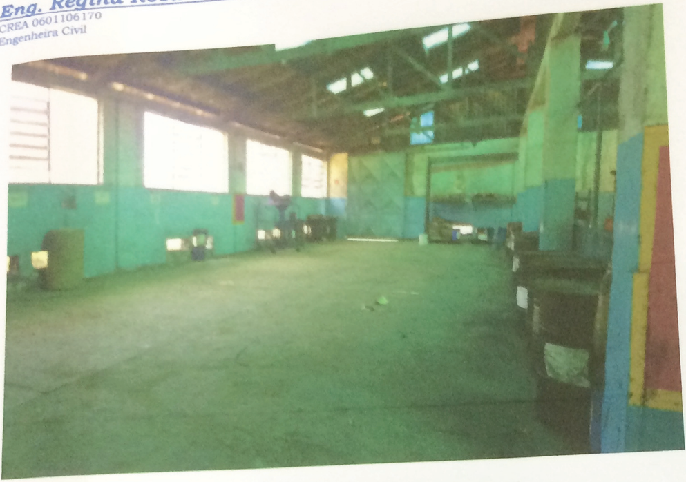
Foto 55 - Prédio 12 - Interior do Galpão 12
