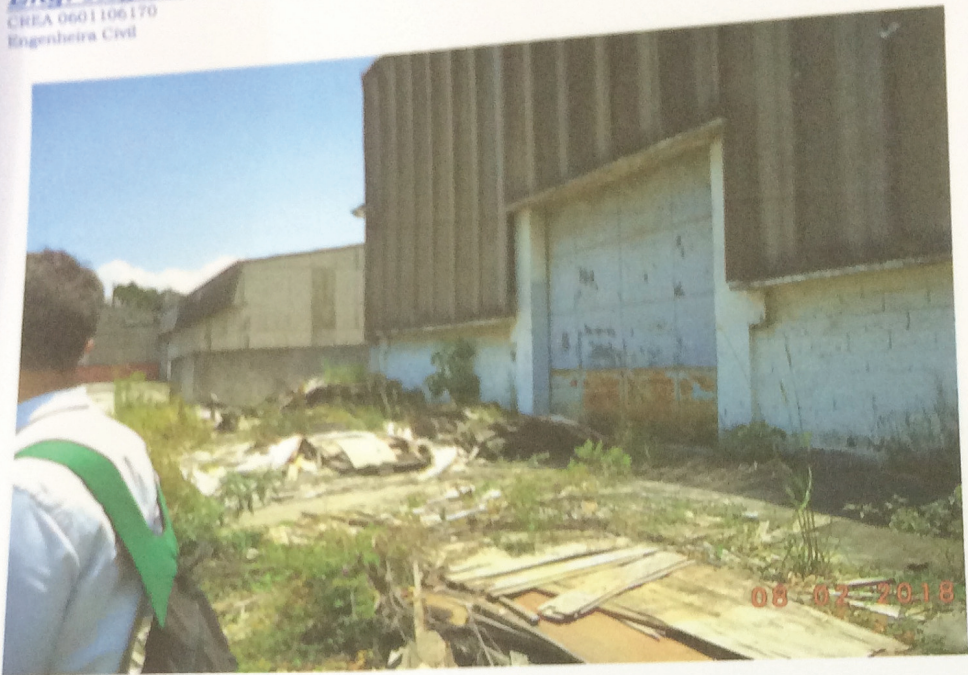
Foto 45 - Prédio 9 - Galpão 9 - Almojarifado
