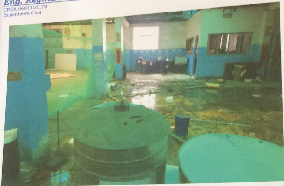
Foto 57 - Prédio 12 - Interior Galpão 12
