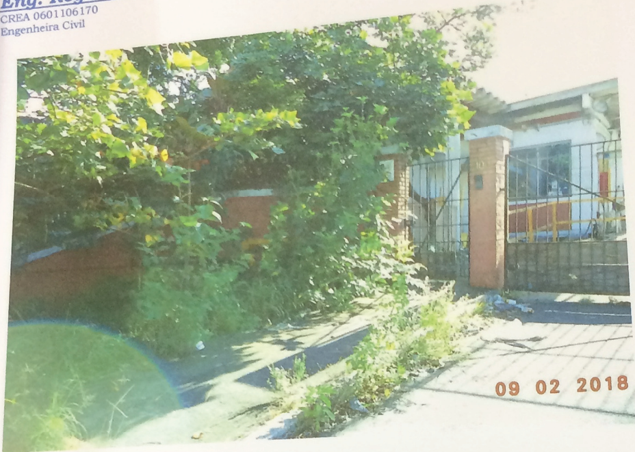
Foto 51 - Entrada Principal - Portaria
