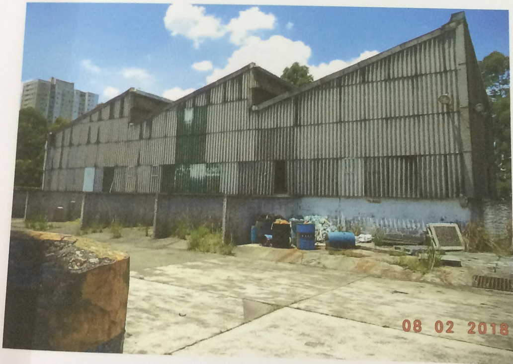
Foto 48 - Prédio 9 - Galpão 9 - Lateral do Galpão
