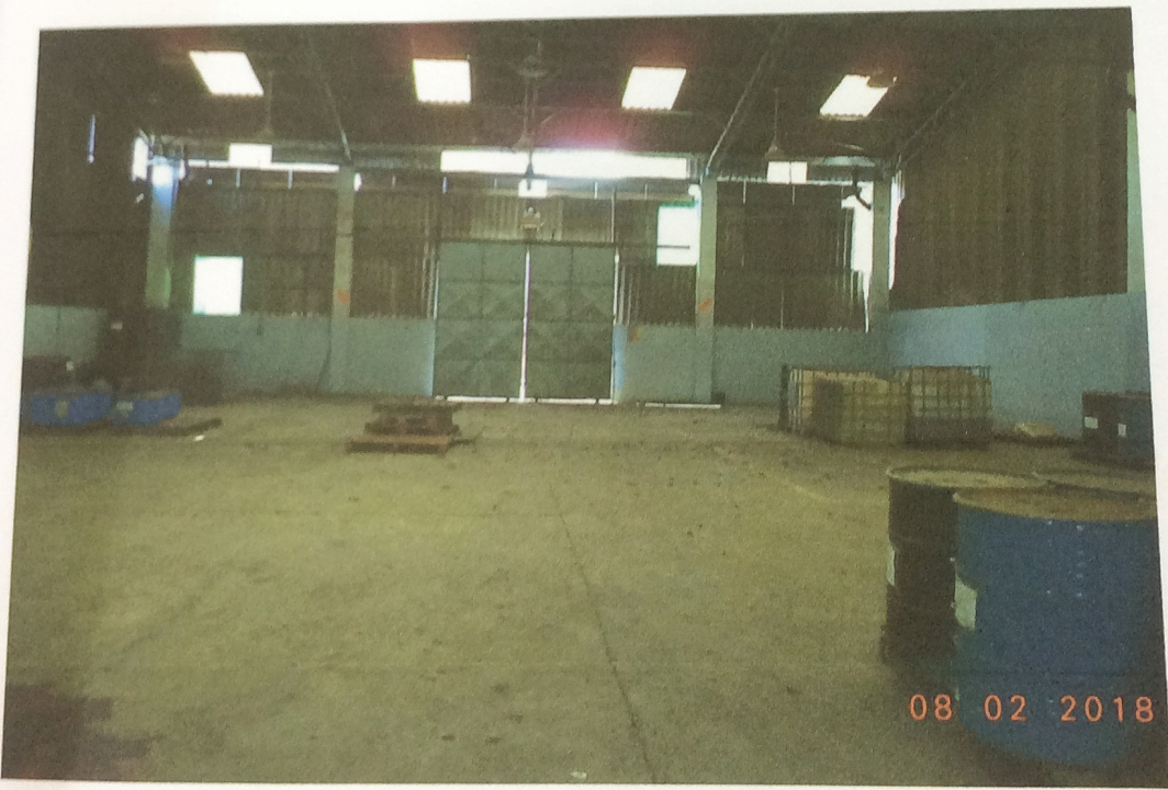
Foto 46- Prédio 9 - Galpão 9 - Almojarifado - Vista Interna
