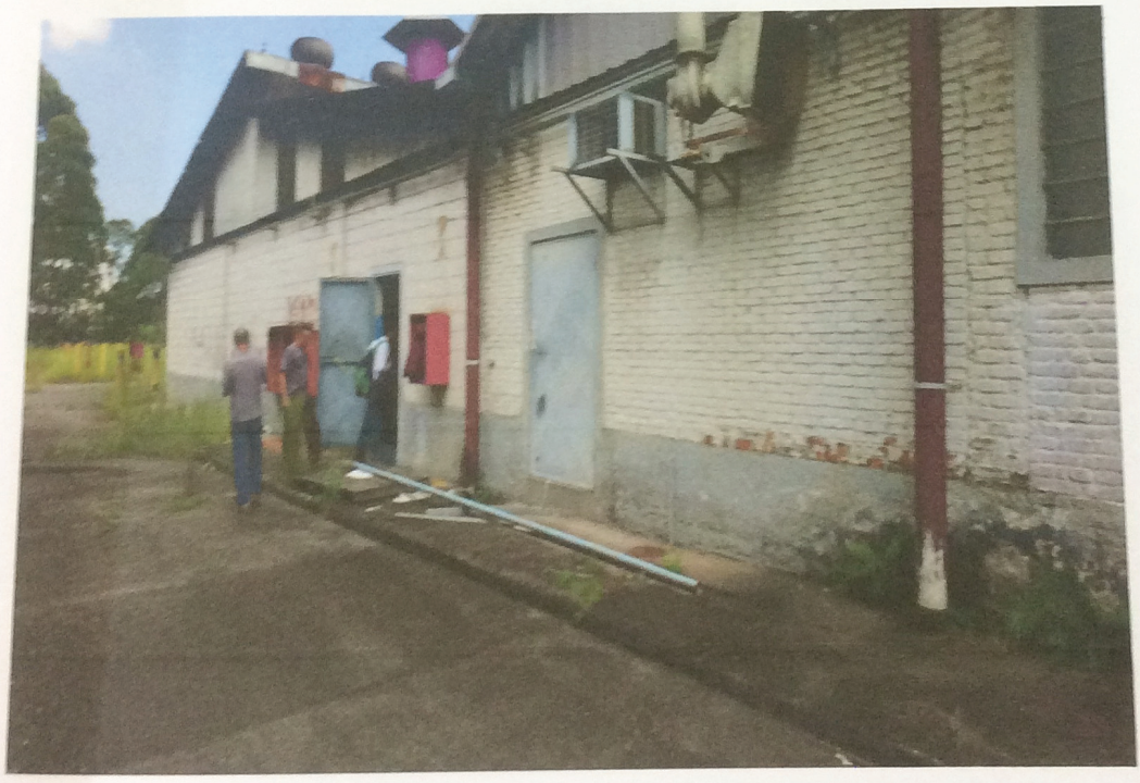
Foto 54 - Prédio 12 - Galpão 12 - Fábrica de Tintas
