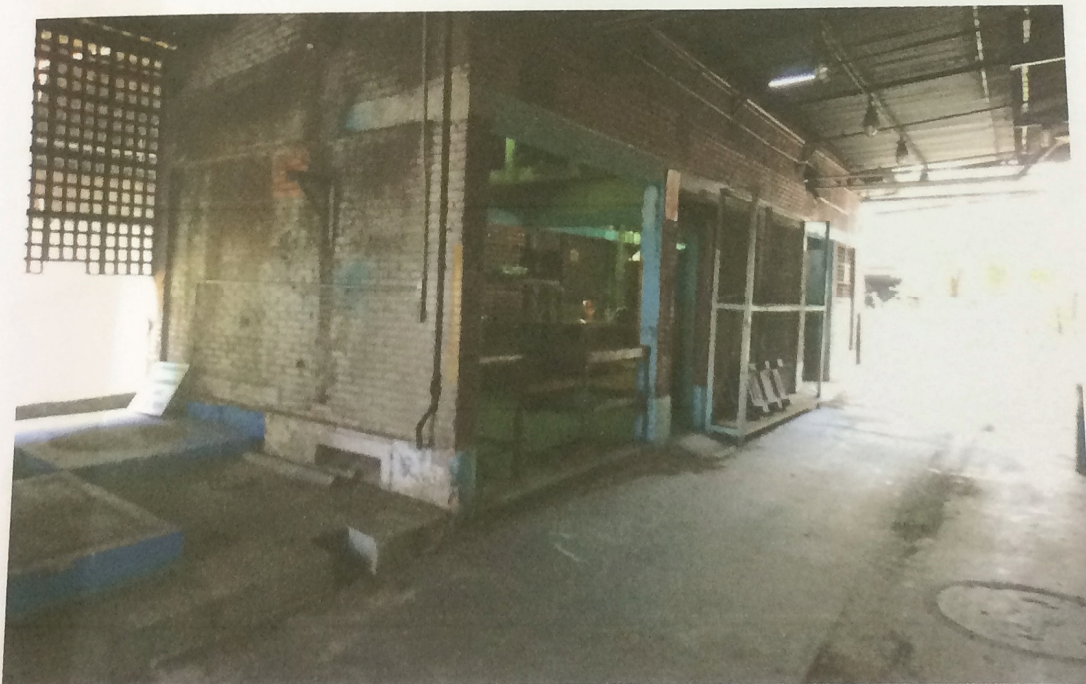
Foto 41 - Prédio 7 - Compressores e Lavagem de Tinteiros
