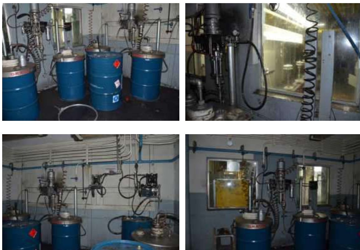
FIGURA 62 - SISTEMA DE PREPARAÇÃO DE TINTAS
