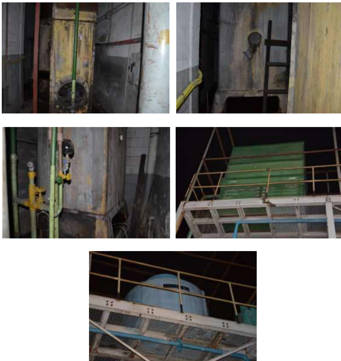
FIGURA 37 - TORRES DE RESFRIAMENTO
