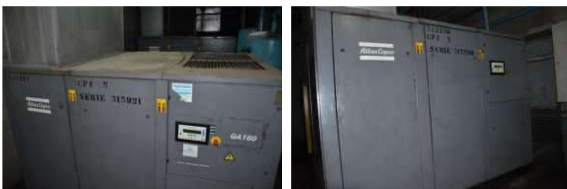
FIGURA 33 - COMPRESSORES ESTACIONÁRIOS ROTATIVOS DE PARAFUSOS
