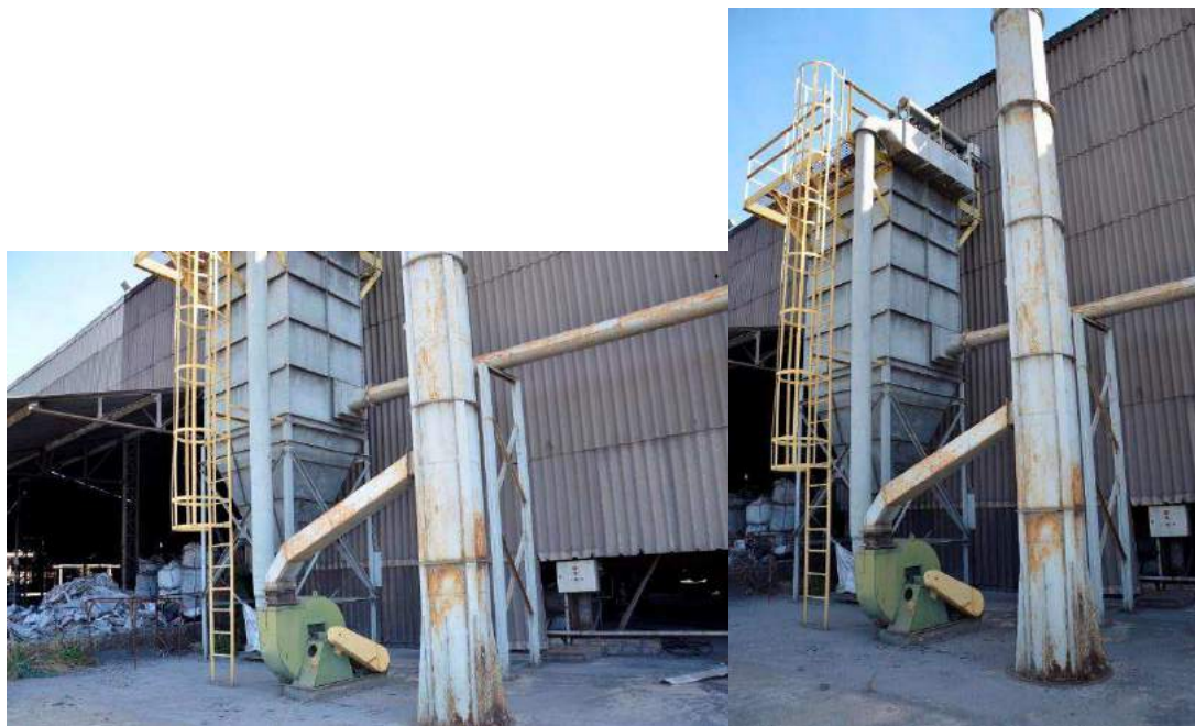
FIGURA 10 - SISTEMA DE DESPOEIRAMENTO
