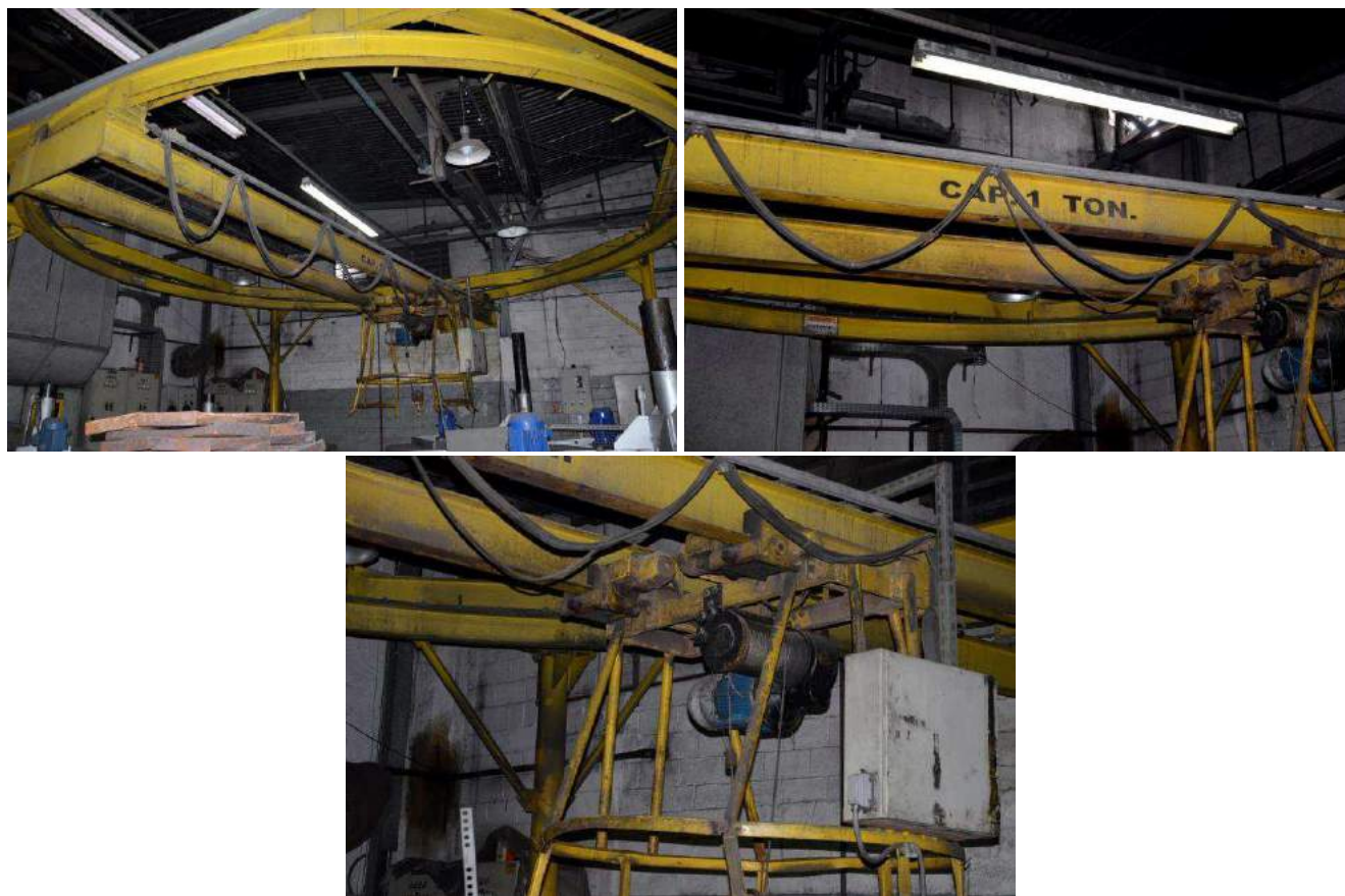
FIGURA 49 - PONTE ROLANTE CIRCULAR SOBRE OS FORNOS SAUDER E BRASIMET
