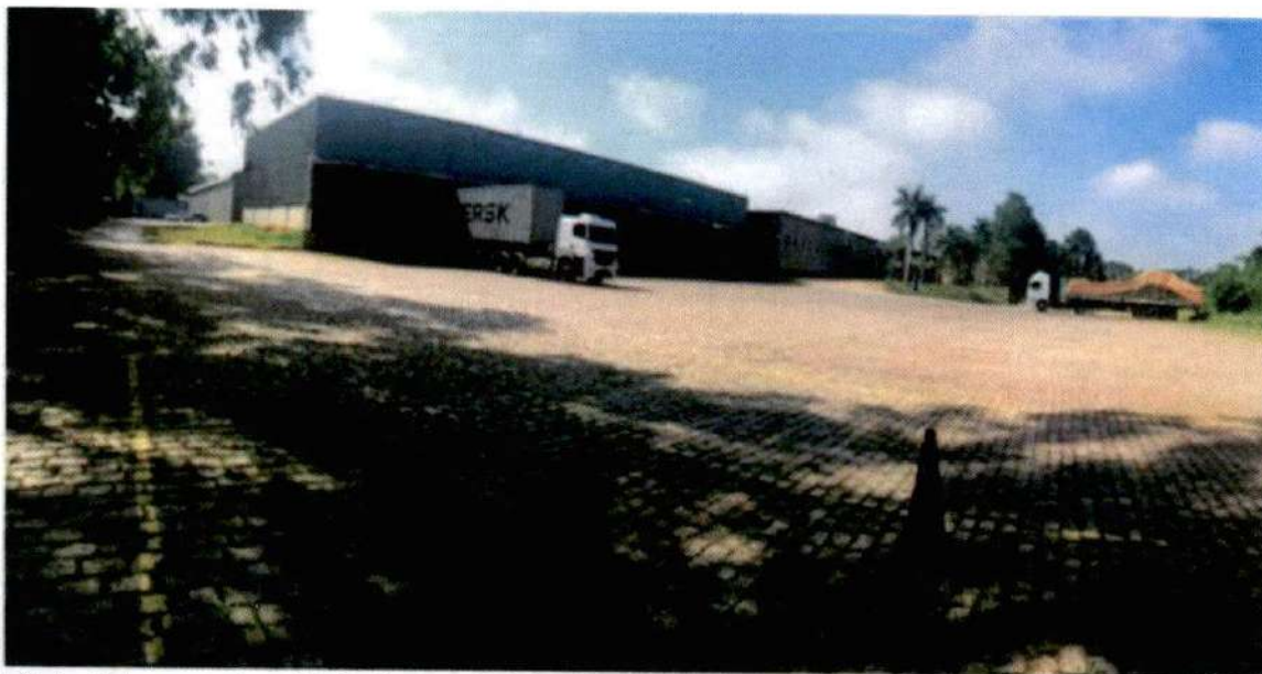
Vista Interna dos Galpões – Pátio de Manobra
