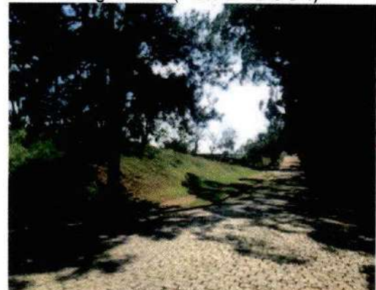
Imagem 18 - Acesso viário (Platô A sentido Platô B)
