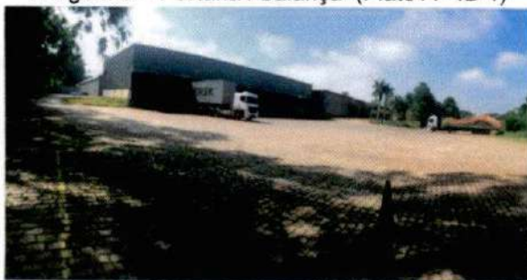
Imagem 11 – Pátio de Estacionamento Caminhões/Galpão (Platô B-ID 3)
