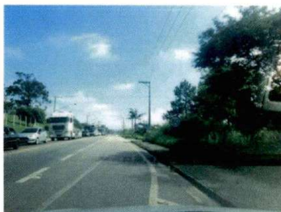
Imagem 8 – Vista de Acesso- sentido Suzano
