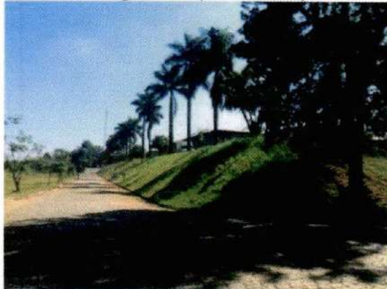
Imagem 17 - Acesso viário (Platô A)
