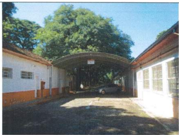
08 – Cobertura Metálica entre 33 e 35
