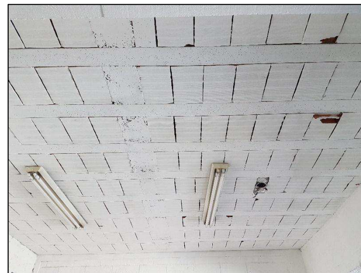
Mezanino - Detalhe da laje
