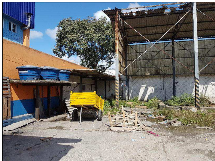
Cobertura de apoio
