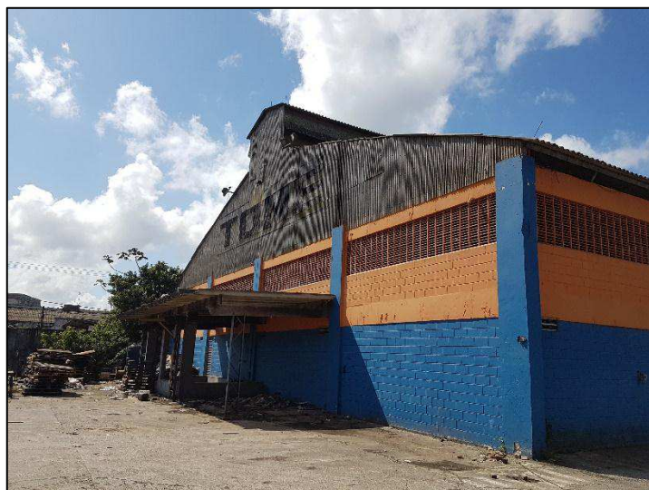
Galpão visto de dentro da propriedade
