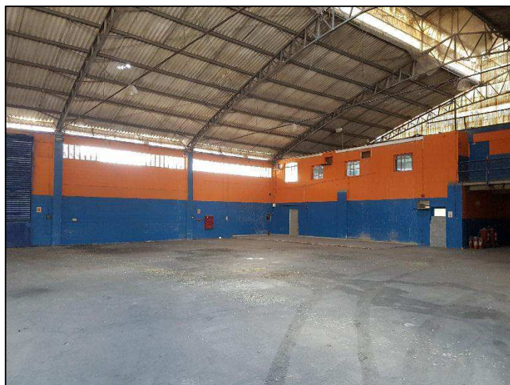
Interior do galpão
