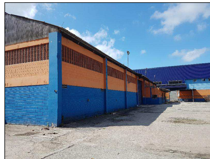
Galpão visto de dentro da propriedade
