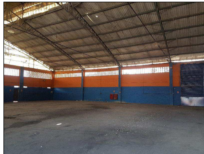
Interior do galpão
