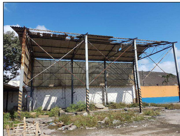
Cobertura de apoio
