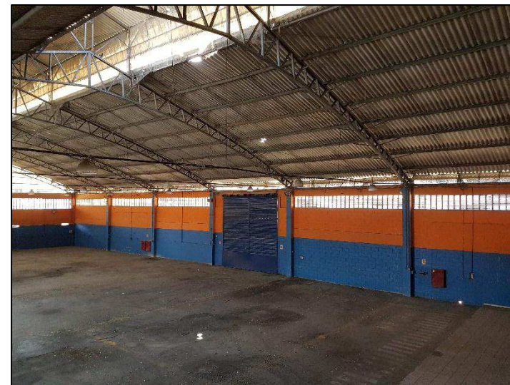
Galpão visto do mezanino
