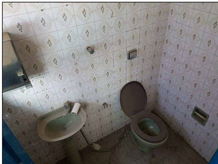
Banheiro - Setor administrativo
