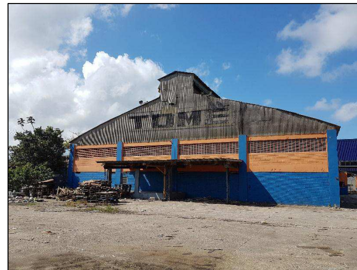
Galpão visto de dentro da propriedade
