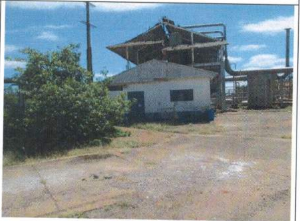
30 – Cabine de Força (Fab. 5)
