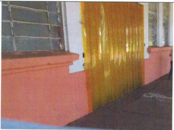
24 – Depósito de Farelo (29, 30)
