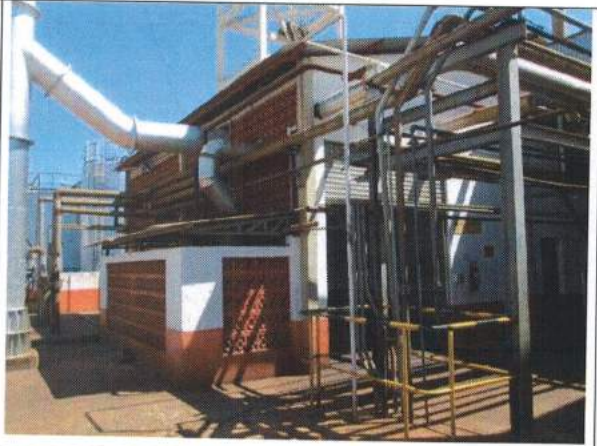
18 – Caldeira e Anexo (Fab. 4)
