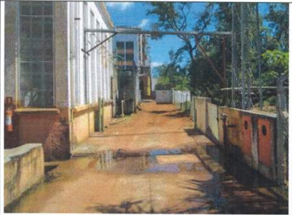
40 – Tratamento de água (44) local que consta na planta
