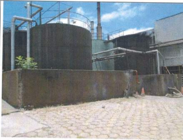
35 – Diques de Contenção/Área de Tancagem (Fab. 9)
