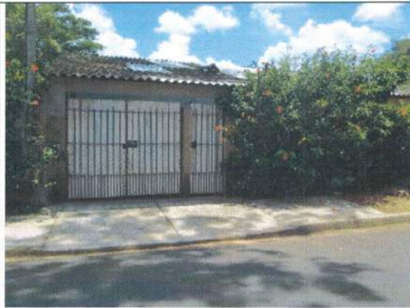
71 – Construção no terreno da mat. 46.882
