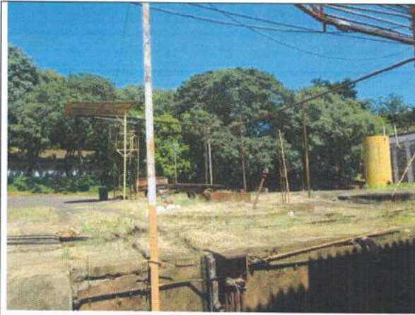
31 – Depósito para sucatas (42)
