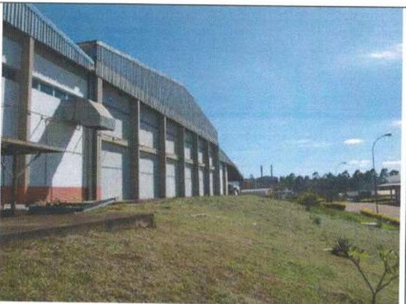
05 - Prédio de Gordura/Margarina (ampliação) (Fab. 6)
