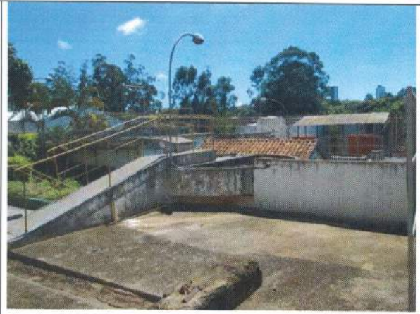
38 – Tratamento de água Residual (118)
