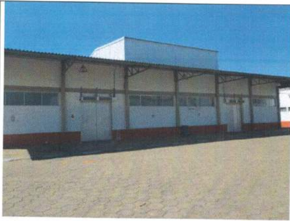
13 – Fábrica de Cobertura (Fab. 6)
