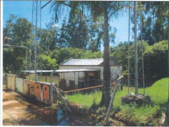
39 – Sala de Bombas e Lagoa (43)
