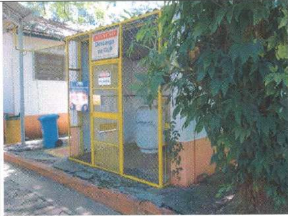
51 – Centra de Cilindros de GLP (15)
