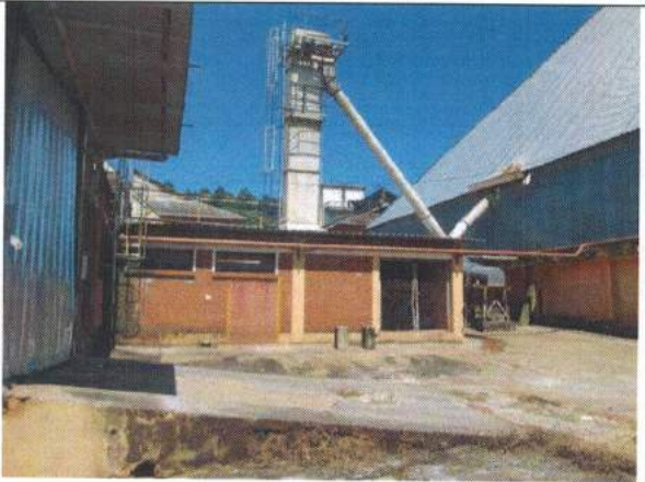
36 – Sala de Ventiladores (80)
