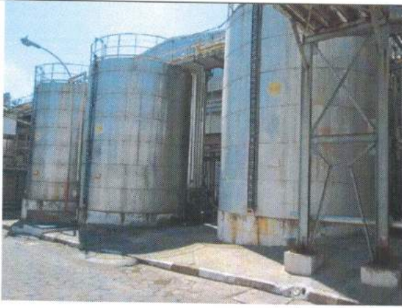
15 – Bases de Tanques (Fab. 4)
