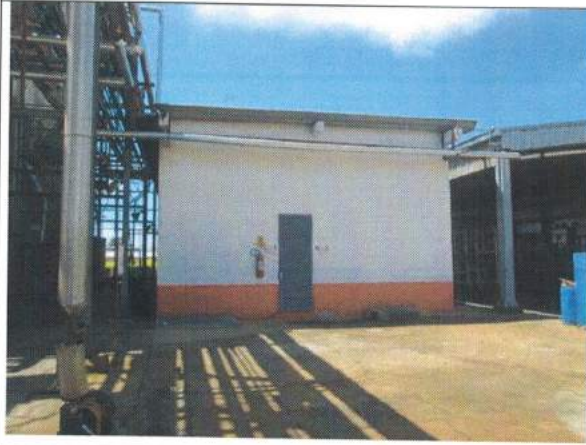
27 – Cabine Elétrica (Fab. 10)
