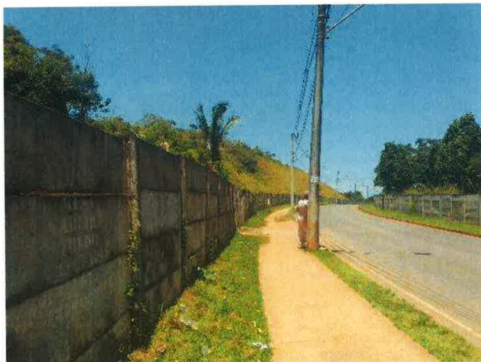
VISTA PARCIAL DA AV 29 DE MARÇO ALT. 1272 SENTIDO AV LUÍS VIANA – BAIRRO NOVA BRASÍLIA
