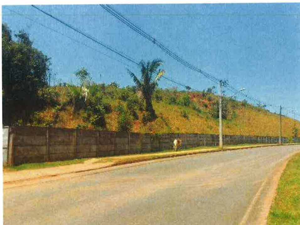
VISTA PARCIAL DA AV 29 DE MARÇO ALT. 1272 SENTIDO CONDOMÍNIO APHAVILLE II – BAIRRO NOVA BRASÍLIA.
