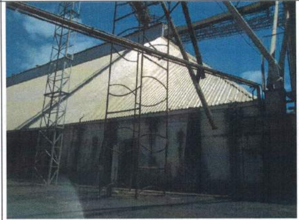
34 – Silo de Alvenaria
