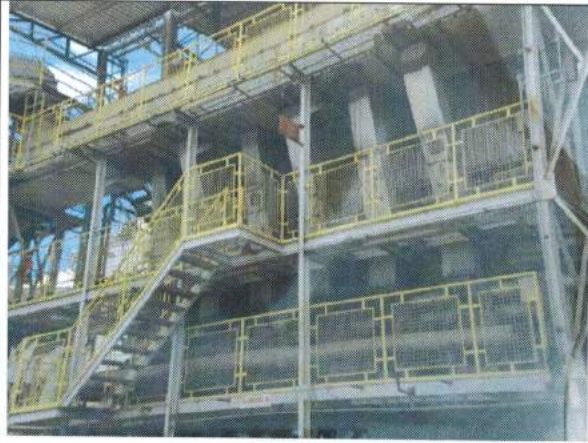
51 – Cobertura Caldeira nova
