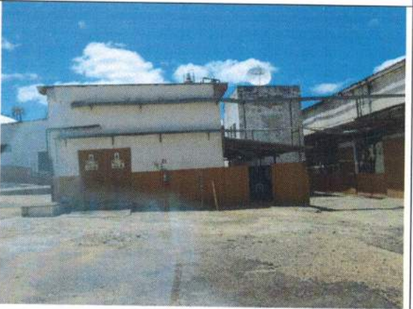
30 – Sub Estação de Alta Tensão
