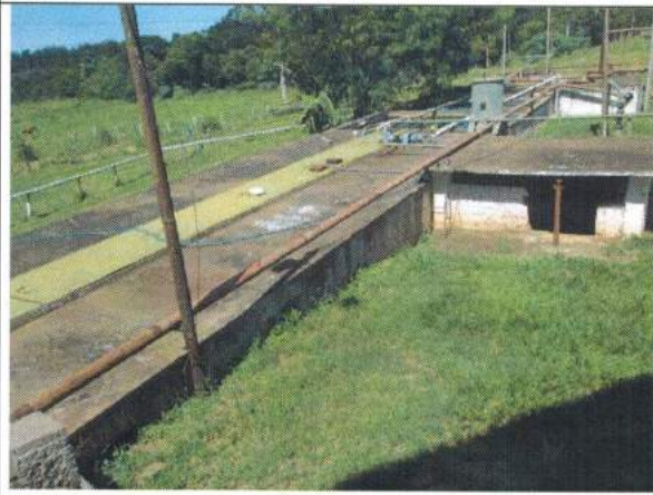
15 – Caixa d' água para fábrica
