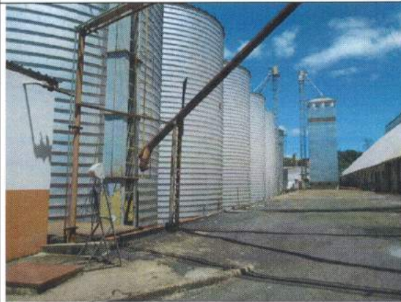
35 – Plataformas de Silos Metálicos
