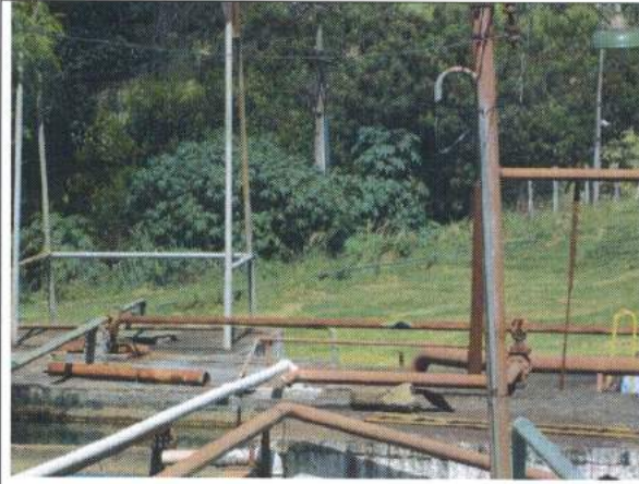
13 – Caixa d'água e poço
