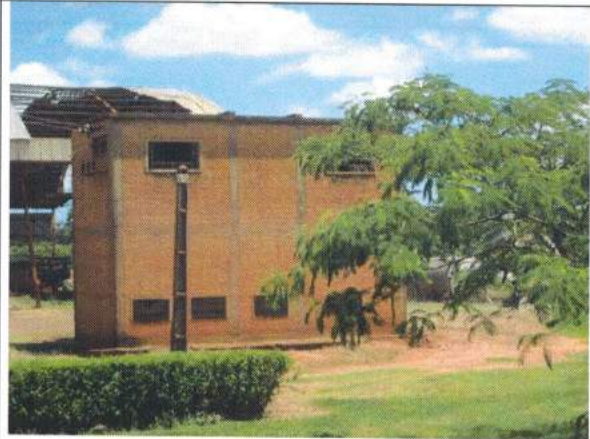
63 – Casa de Força
