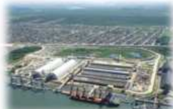
Terminais e Portos
