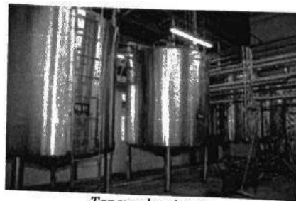
Tanque de mistura
