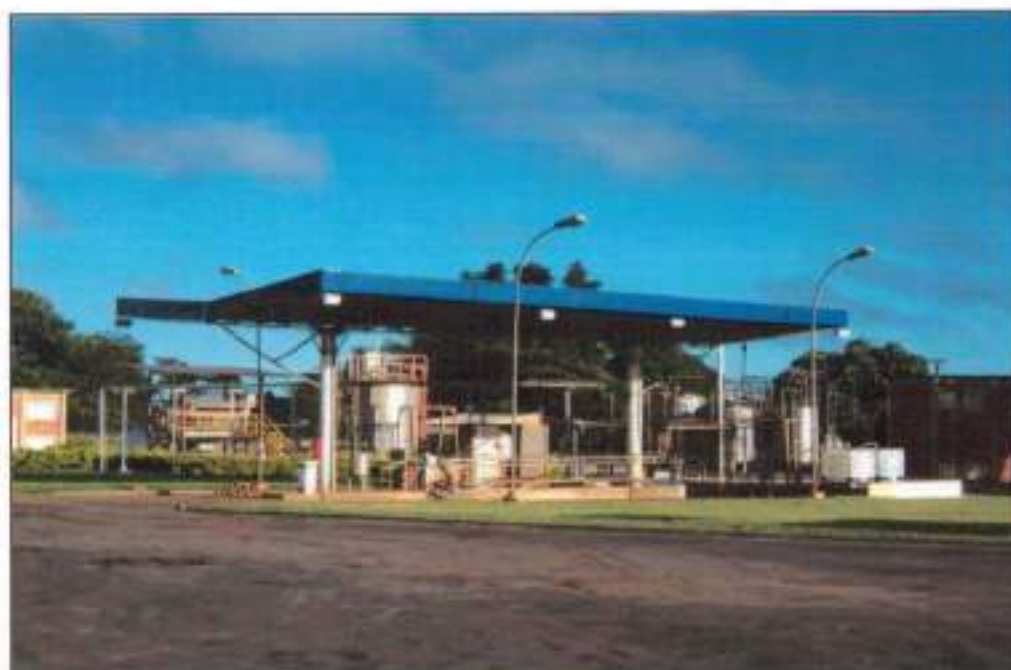
Vista externa - Posto de limpeza e desinfecção de Caminhões Tanques – Cerqueira Cesar/SP
