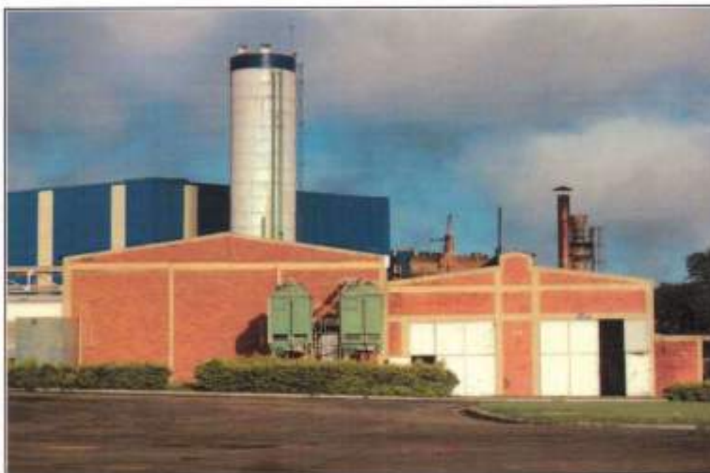
Vista externa – Casa dos geradores – Cerqueira Cesar/SP
