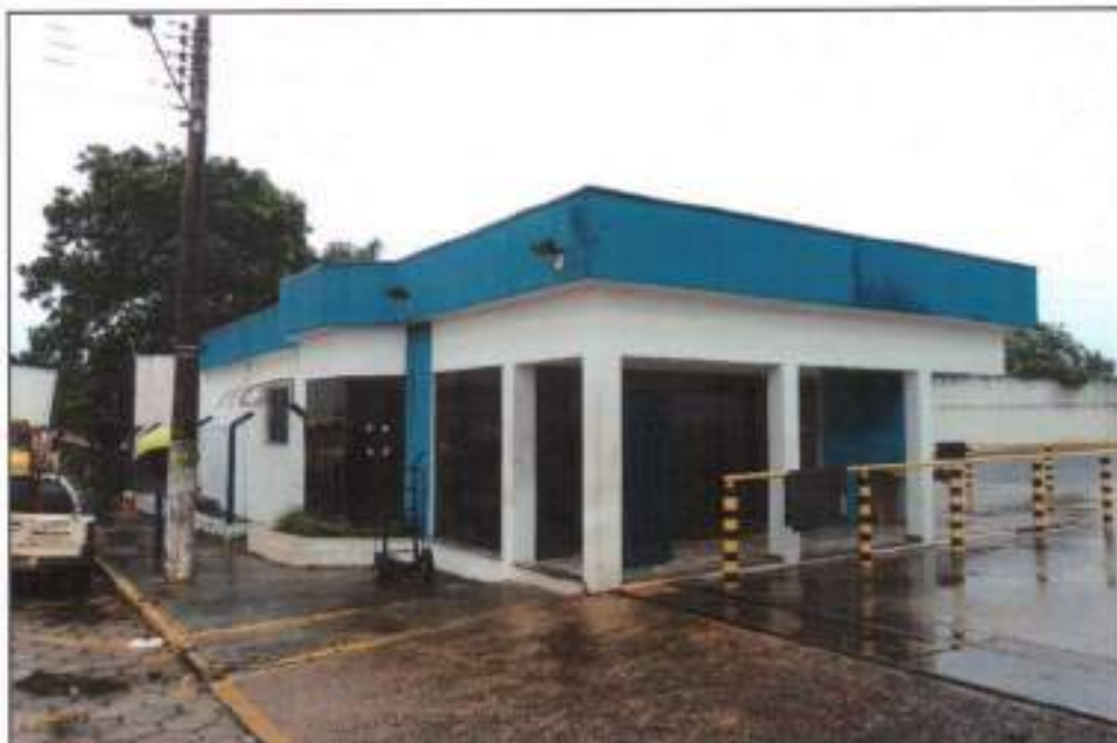
Vista externa – Guarita entrada da logística – Cerqueira Cesar/SP
