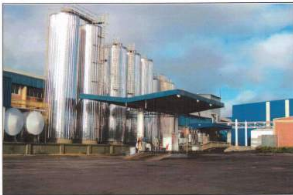
Vista externa – Posto de recepção de leite – Cerqueira Cesar/SP
