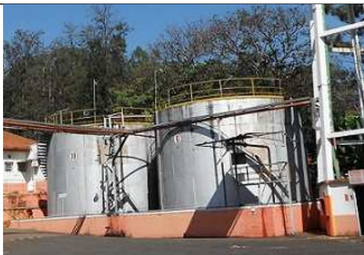
Tanques e embarque a granel
