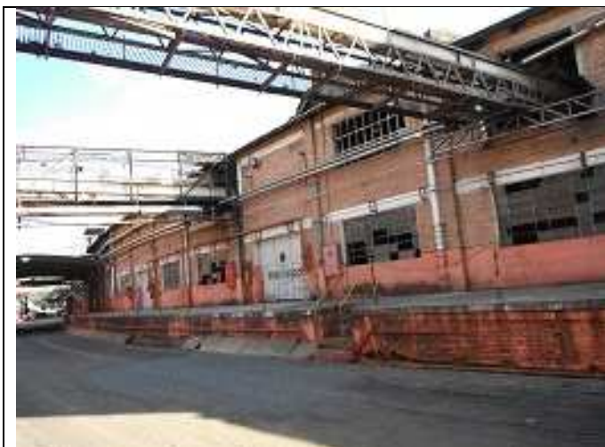
Vista geral barracões processamento algodão
