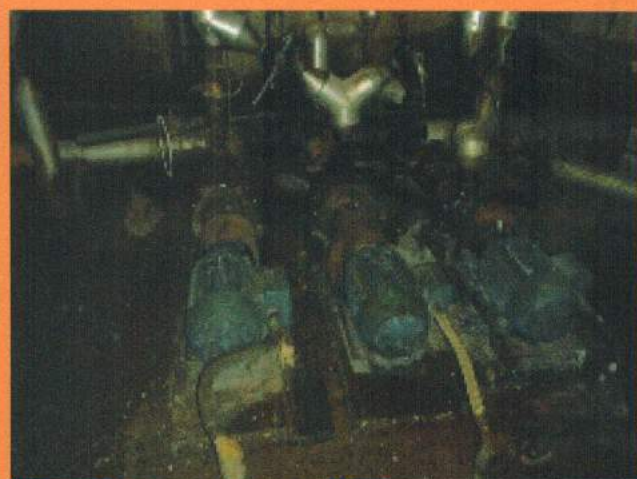
89. Motores elétricos WEG
