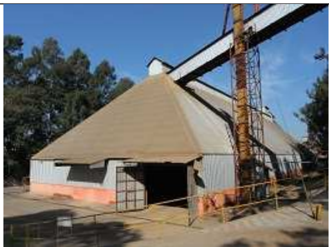
Armazém de farelo
