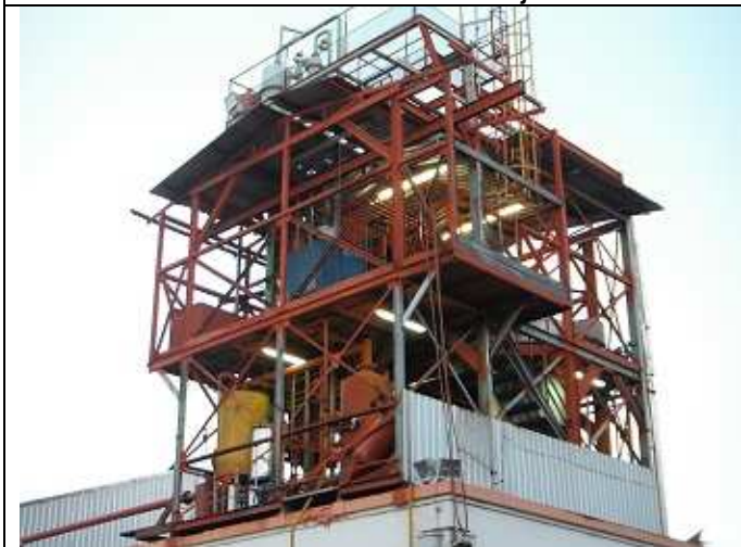
Prédio do Pré-Refino
