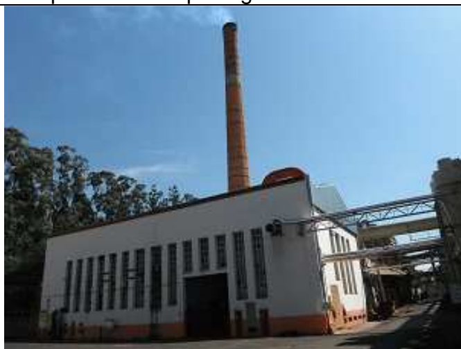
Prédio das caldeiras
