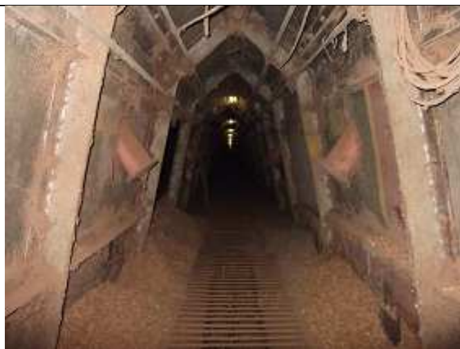
Túnel do silo item 13B
