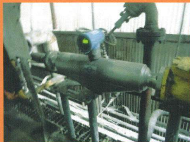
83. Medidor vazão mássico Micro Motion
