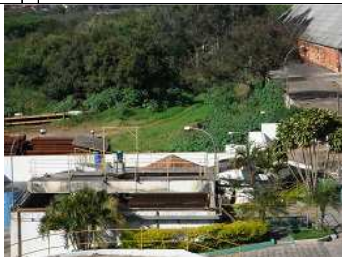
ETE- Estação de Tratamento de Efluentes
