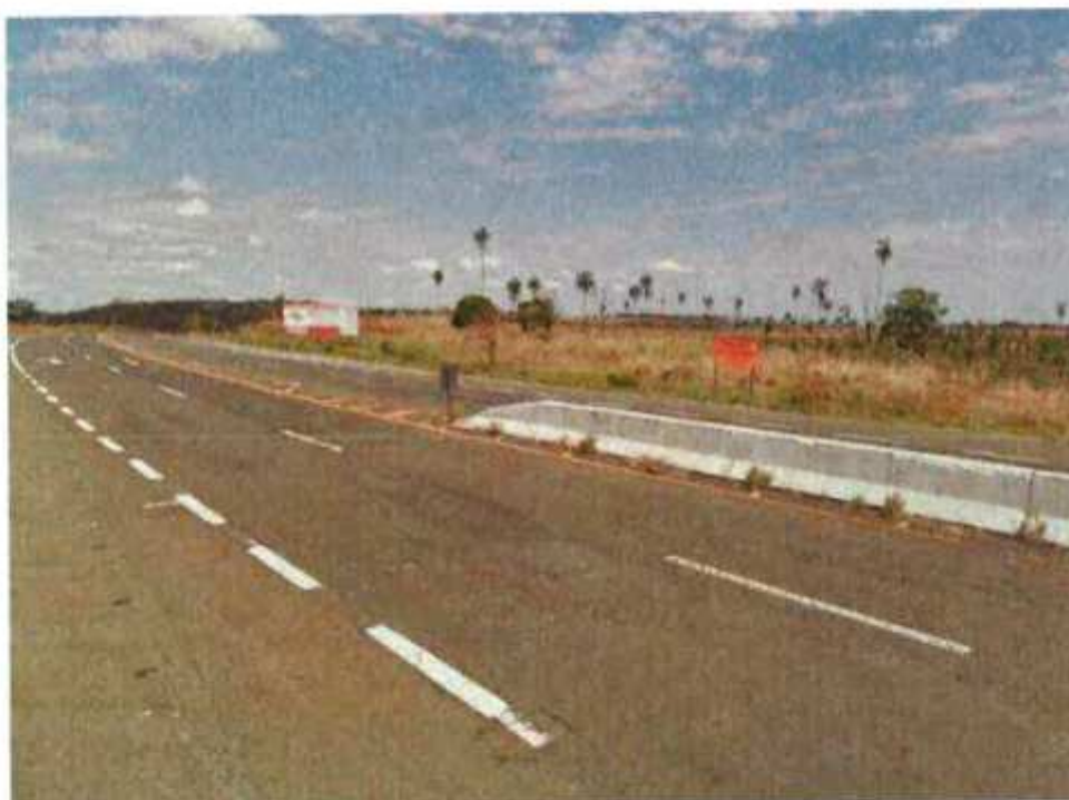
VISTA PARCIAL RODOVIA SP-320 SENTIDO TRÊS FRONTEIRAS/SP – DETALHE ACESSO AO TERRENO AVALIANDO
