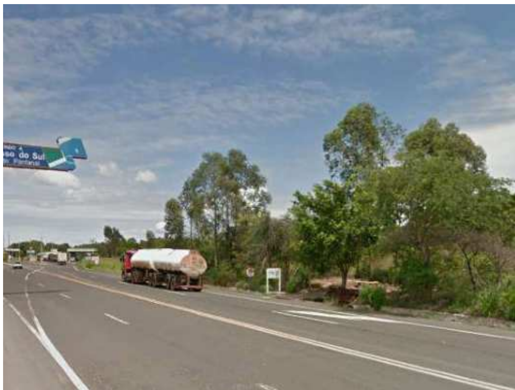
VISTA PARCIAL RODOVIA AV PRESIDENTE VARGAS SENTIDO CENTRO APARECIDA DO TABOADO– DETALHE ACESSO AO IMOVEL CÓRREGO DO CAMPO
