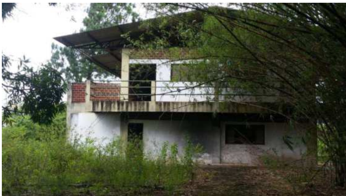
VISTA PARCIAL DO TERRENO – DETALHE PARA ESCRITÓRIO
