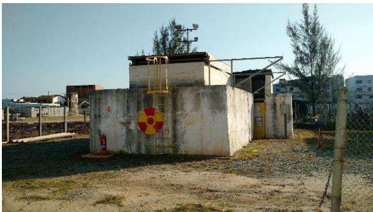
VISTA PARCIAL INTERNA DO IMÓVEL – DEPOSITO DE MATERIAL RADIATIVO
