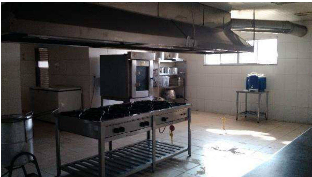
VISTA PARCIAL INTERNA DO IMÓVEL
