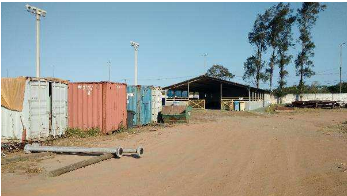
VISTA PARCIAL INTERNA DA BASE – ESTOCAGEM DE MATERIAL
