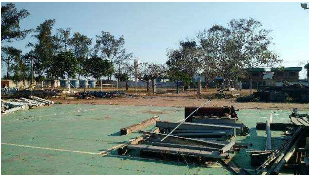
VISTA PARCIAL INTERNA DA BASE DE MACAÉ – ÁREA DE ESTOCAGEM E ESTACIONAMENTO
