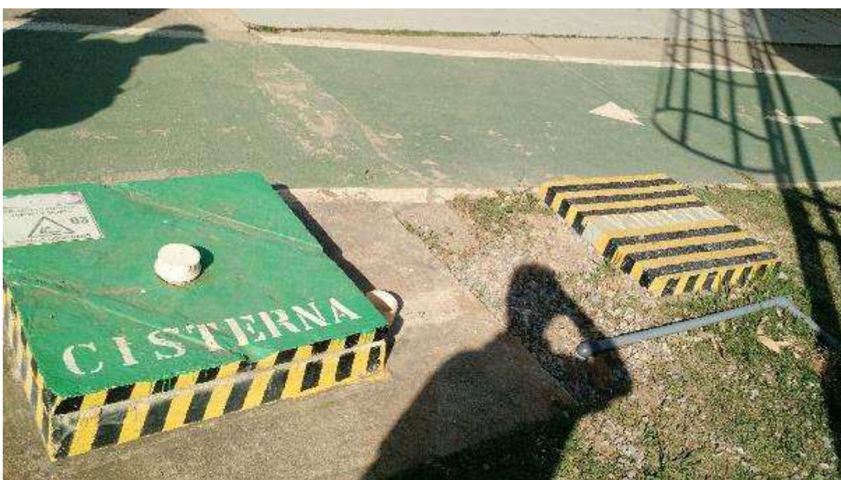
VISTA PARCIAL INTERNA DO IMÓVEL – DETALHE CISTERNA
