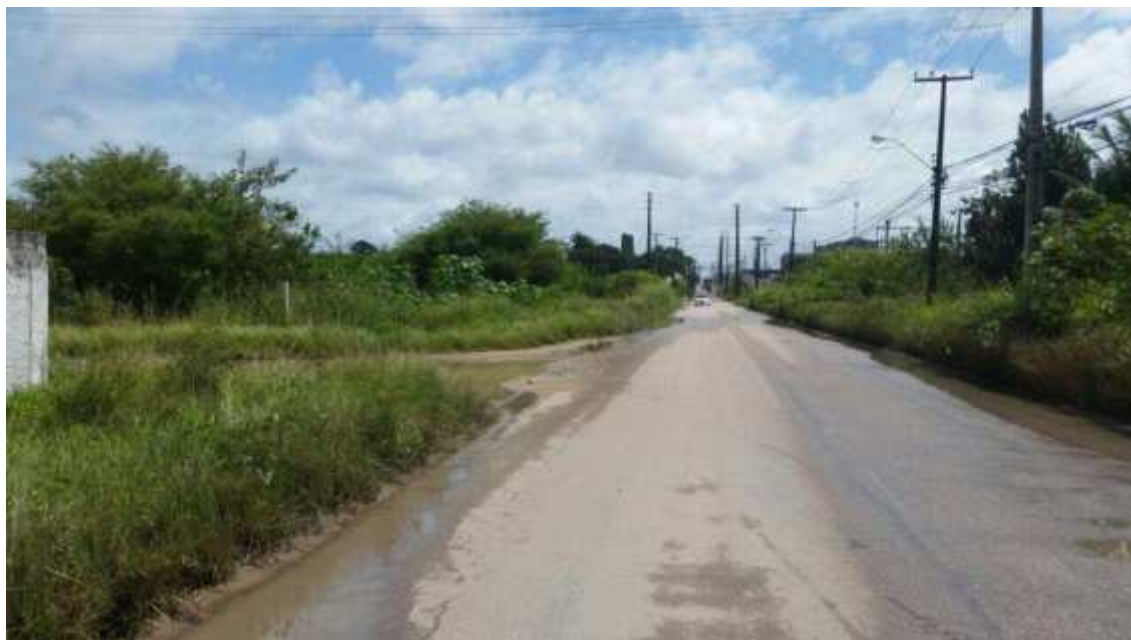
VISTA PARCIAL DA RUA B11 SENTIDO BR-101
