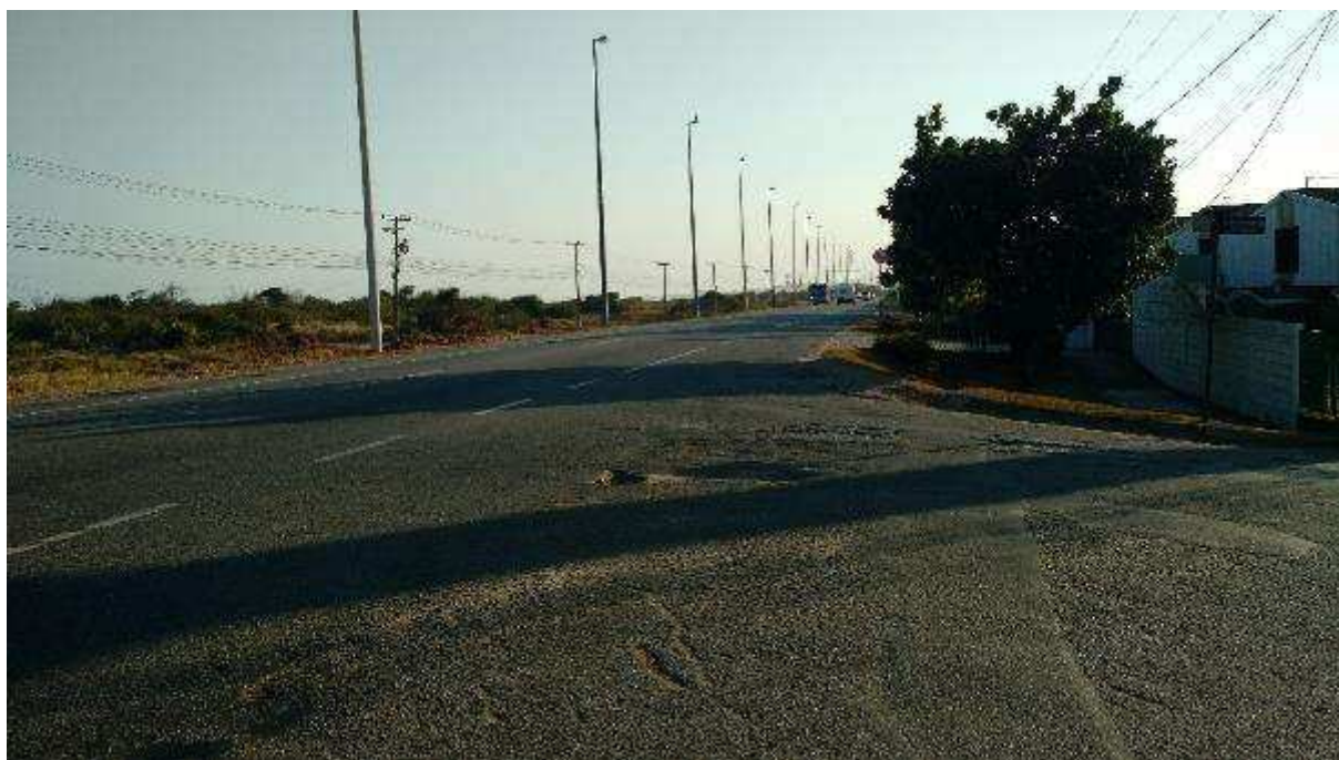
VISTA PARCIAL RODOVIA AMARAL PEIXOTO SENTIDO CARAPEBUS – ACESSO À RUA JOSÉ RECORDER
