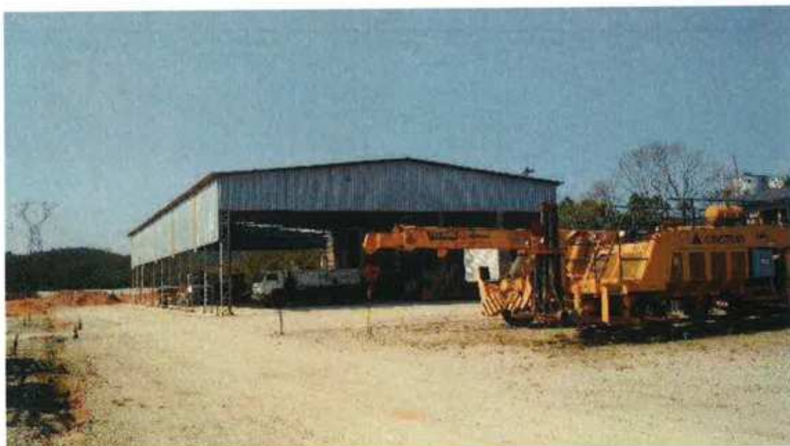
VISTA PARCIAL INTERNA DO IMÓVEL – DETALHE PARA COBERTURA METÁLICA EREGIDA NO IMÓVEL ESTOCAGEM E ARMAZENAMENTO 02
