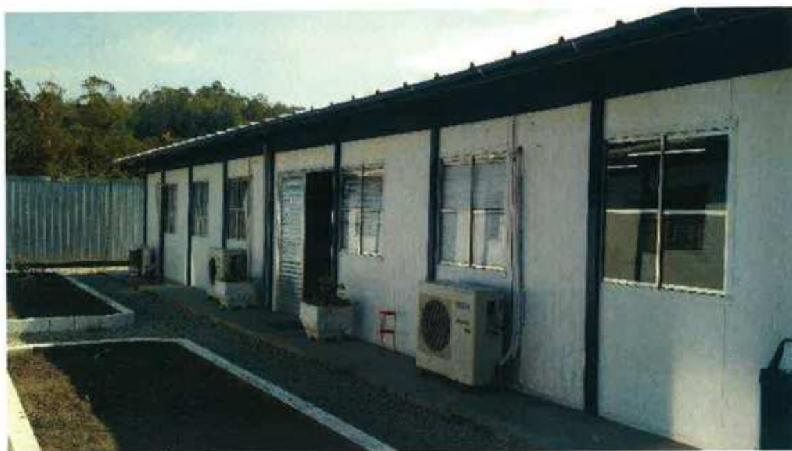
VISTA PARCIAL DA ÁREA ADMINISTRATIVA – DETALHE PARA ACABAMENTO CONSTRUTIVO E ESTADO DE CONSERVAÇÃO DA EDIFICAÇÃO
