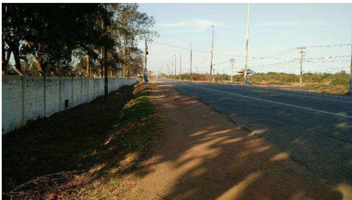
VISTA PARCIAL RODOVIA AMARAL PEIXOTO SENTIDO RIO DAS OSTRAS– ACESSO À RUA JOSÉ RECORDER
