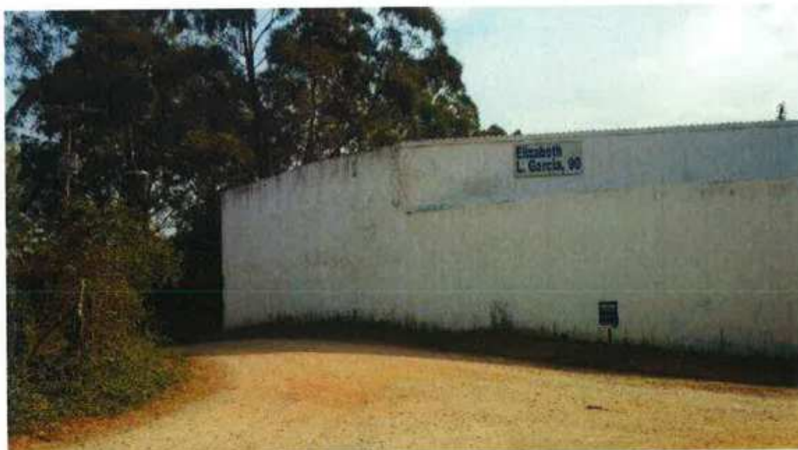
VISTA PARCIAL DO ACESSO AO TERRENO AVALIANDO
