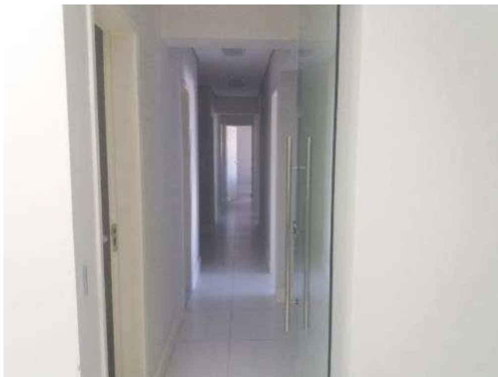
VISTA PARCIAL INTERNA DO 5º ANDAR
