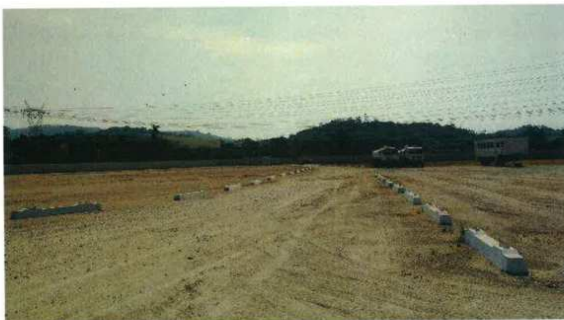
VISTA PARCIAL INTERNA DO IMÓVEL – DETALHE PARA O TERRENO ÁREA UTILIZADA COMO ESTACIONAMENTO PARA CAMINHÕES
