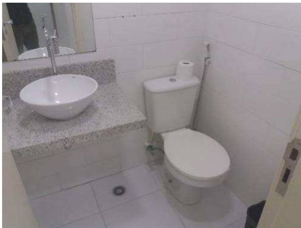
VISTA PARCIAL INTERNA DO 5º ANDAR – DETALHE BANHEIRO
