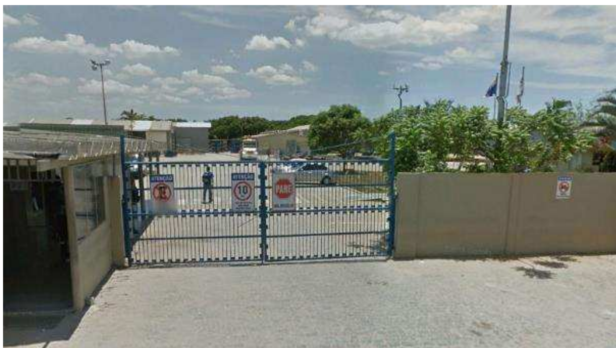
VISTA PARCIAL EXTERNA IMÓVEL DO IMÓVEL – DETALHE FRENTE PARA RUA JOSE RECORDER
