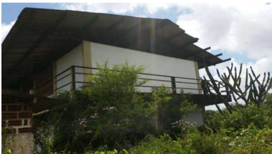
VISTA PARCIAL DO TERRENO – DETALHE PARA ESCRITÓRIO
