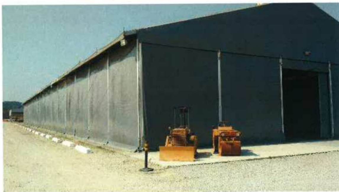
VISTA PARCIAL INTERNA DO IMÓVEL – DETALHE PARA O GALPÃO ESTOCAGEM E ARMAZENAMENTO 01
