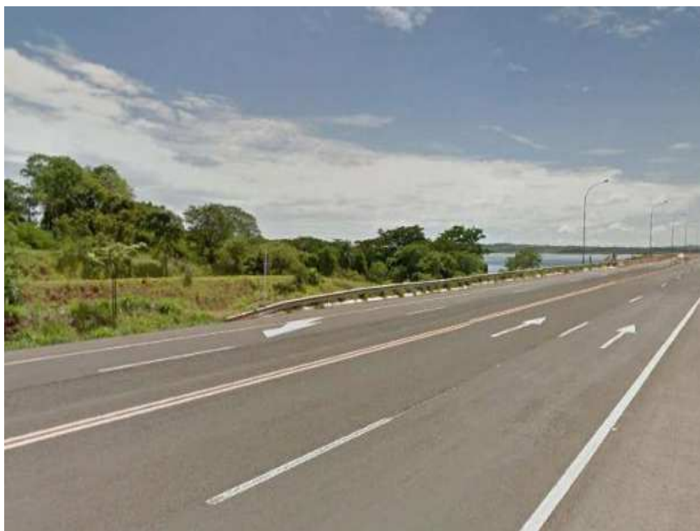
VISTA PARCIAL RODOVIA AV PRESIDENTE VARGAS SENTIDO RUBINEIA/SP – DETALHE ACESSO AO IMOVEL CÓRREGO DO CAMPO
