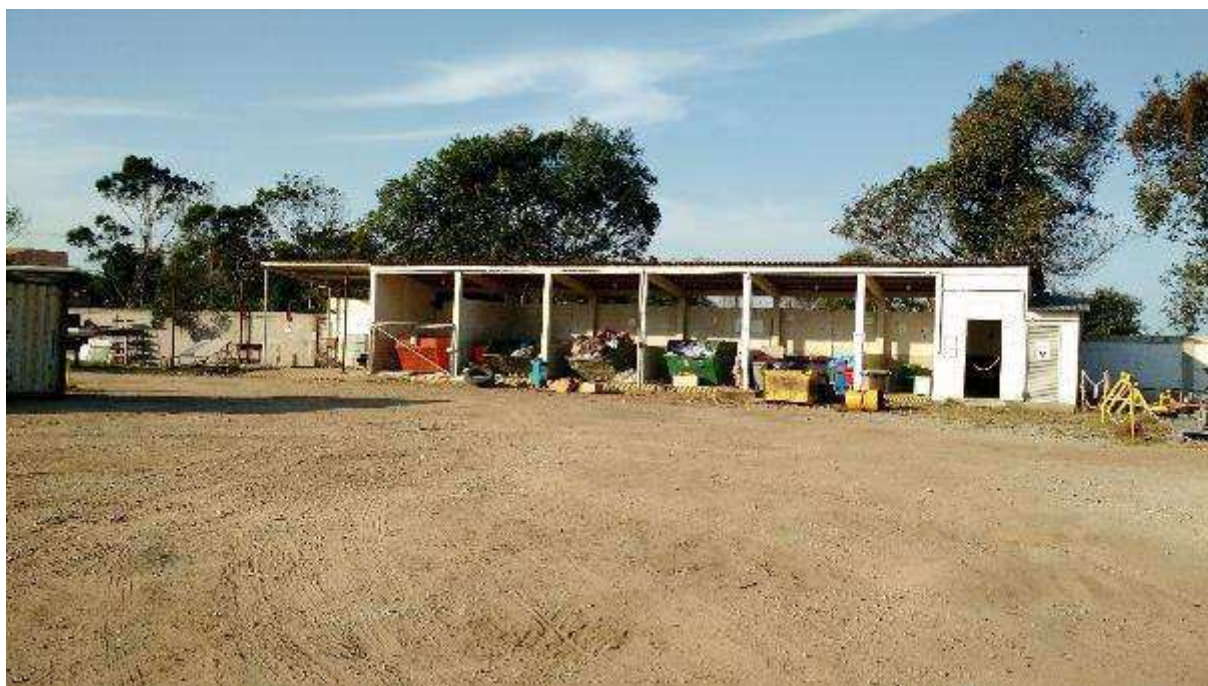
VISTA PARCIAL INTERNA DO IMÓVEL – DETALHE DEPÓSITO DE RESÍDUOS
