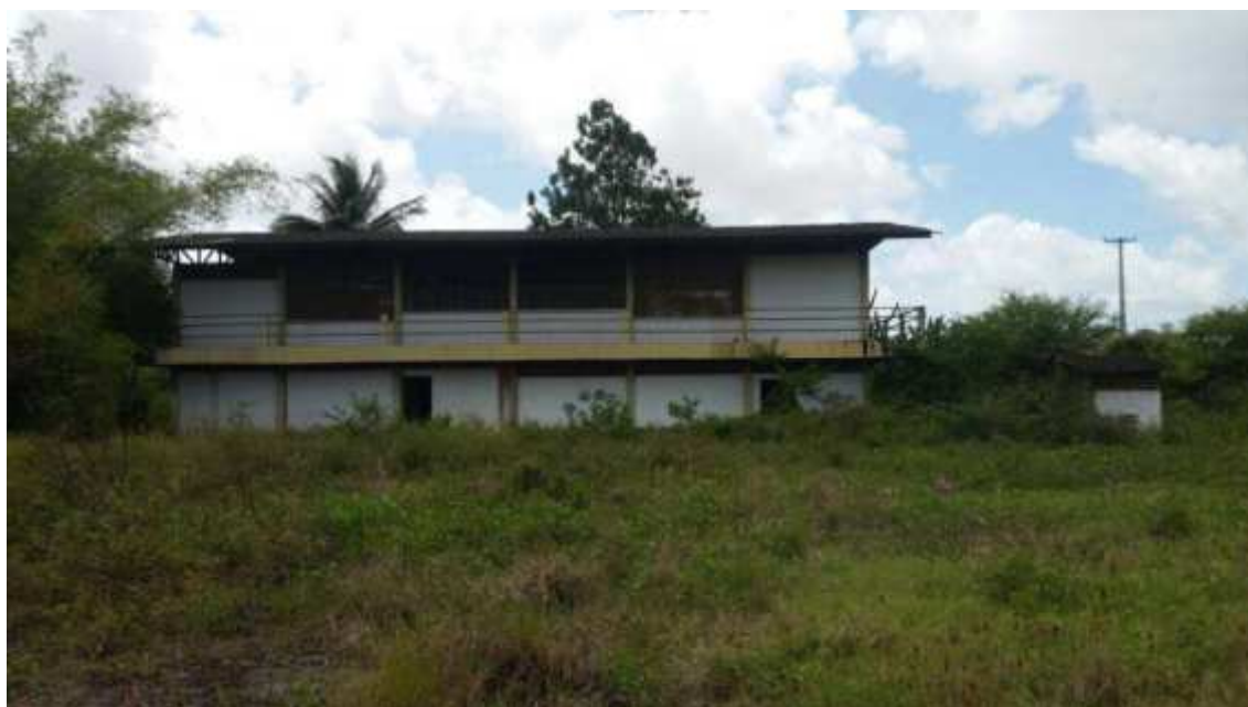
VISTA PARCIAL DO TERRENO – DETALHE PARA ESCRITÓRIO
