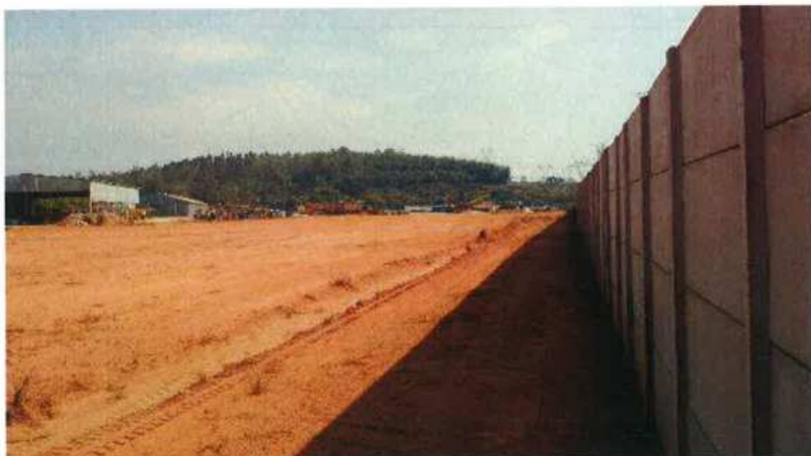
VISTA PARCIAL INTERNA DO IMÓVEL – DETALHE PARA O TERRENO
