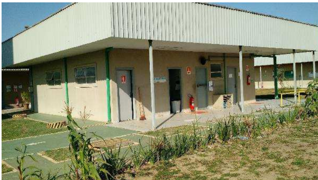
VISTA PARCIAL INTERNA DO IMÓVEL – DETALHE BANHEIROS
