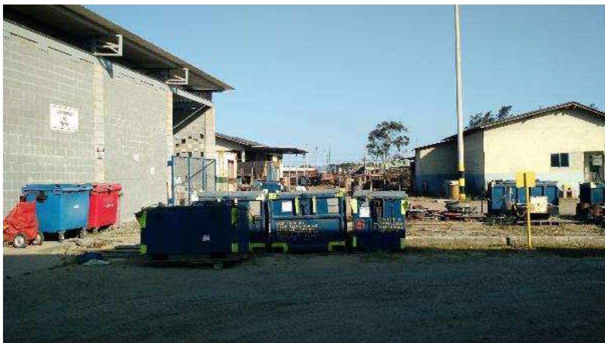
VISTA PARCIAL INTERNA DA BASE
