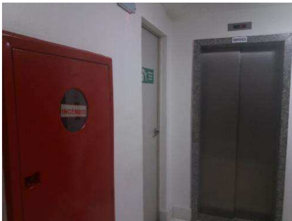
VISTA PARCIAL EXTERNA CONJUNTOS 5º ANDAR – DETALHE SAIDA DE EMERGÊNCIA
