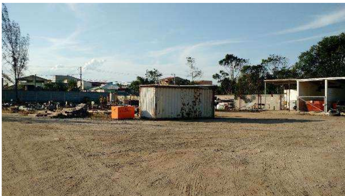
VISTA PARCIAL INTERNA DO IMÓVEL
