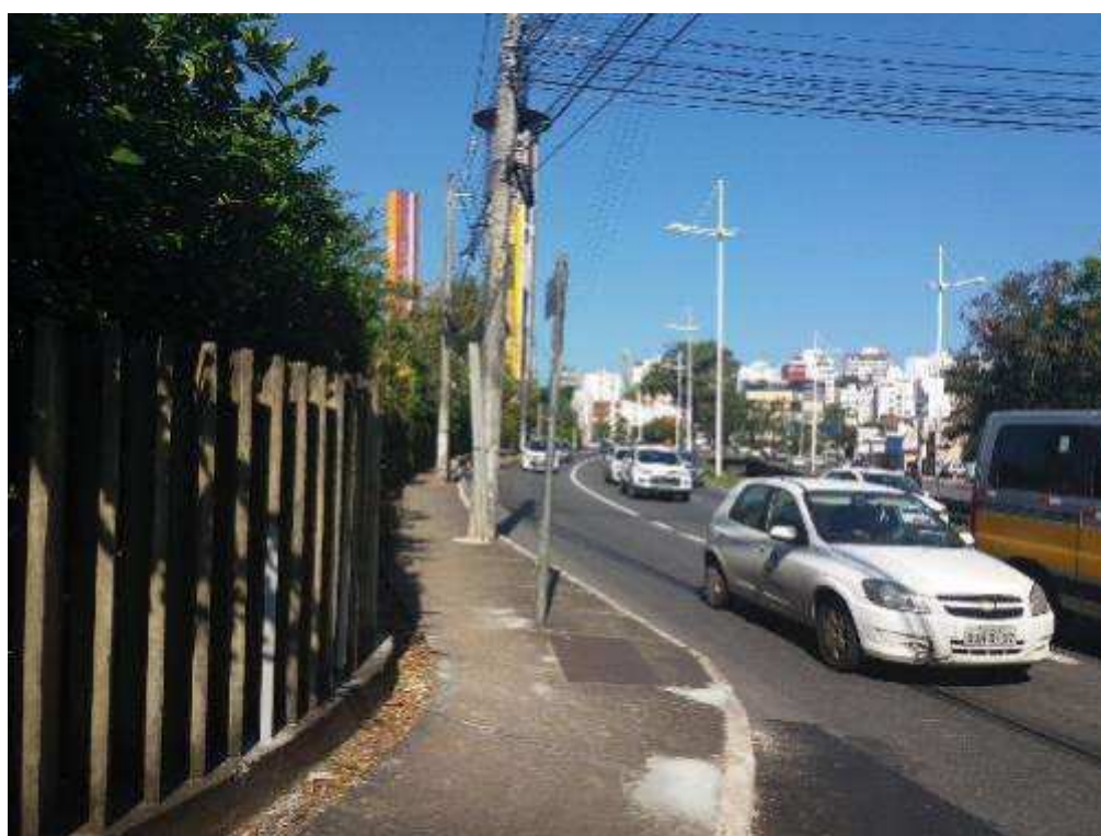
VISTA PARCIAL RUA LUCAIA, 337 – SENTIDO SANTA CRUZ – RIO VERMELHO
