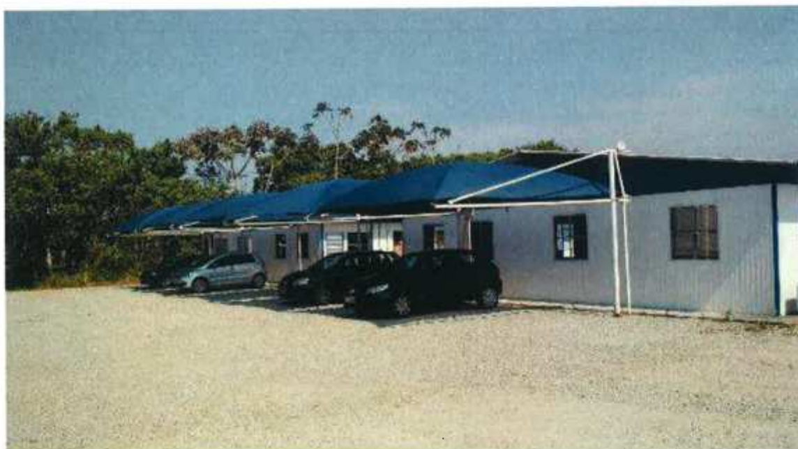
VISTA PARCIAL INTERNA DO IMÓVEL – DETALHE PARA ÁREA ADMINISTRATIVA
