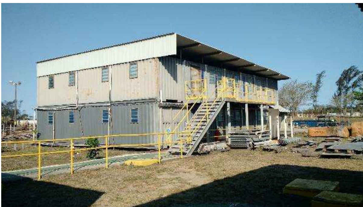
VISTA PARCIAL INTERNA DO IMÓVEL – DETALHE ESCRITÓRIO
