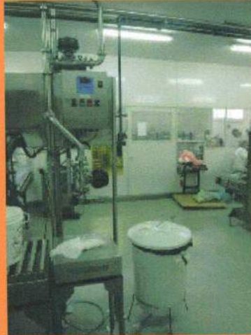
122. Sistema de pesagem automática Toledo
