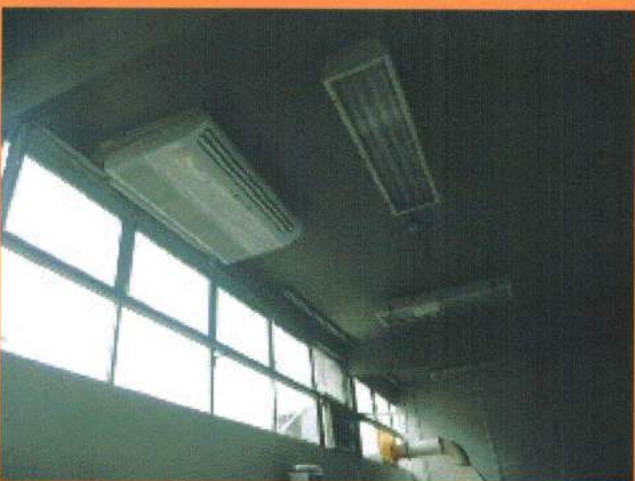
136. Ar condicionado Split Midea
