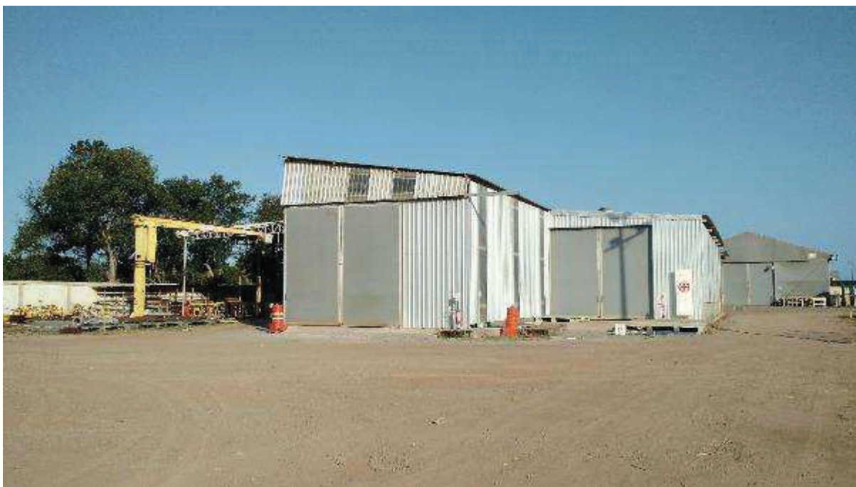
VISTA PARCIAL INTERNA DO IMÓVEL – DETALHE GALPÃO
