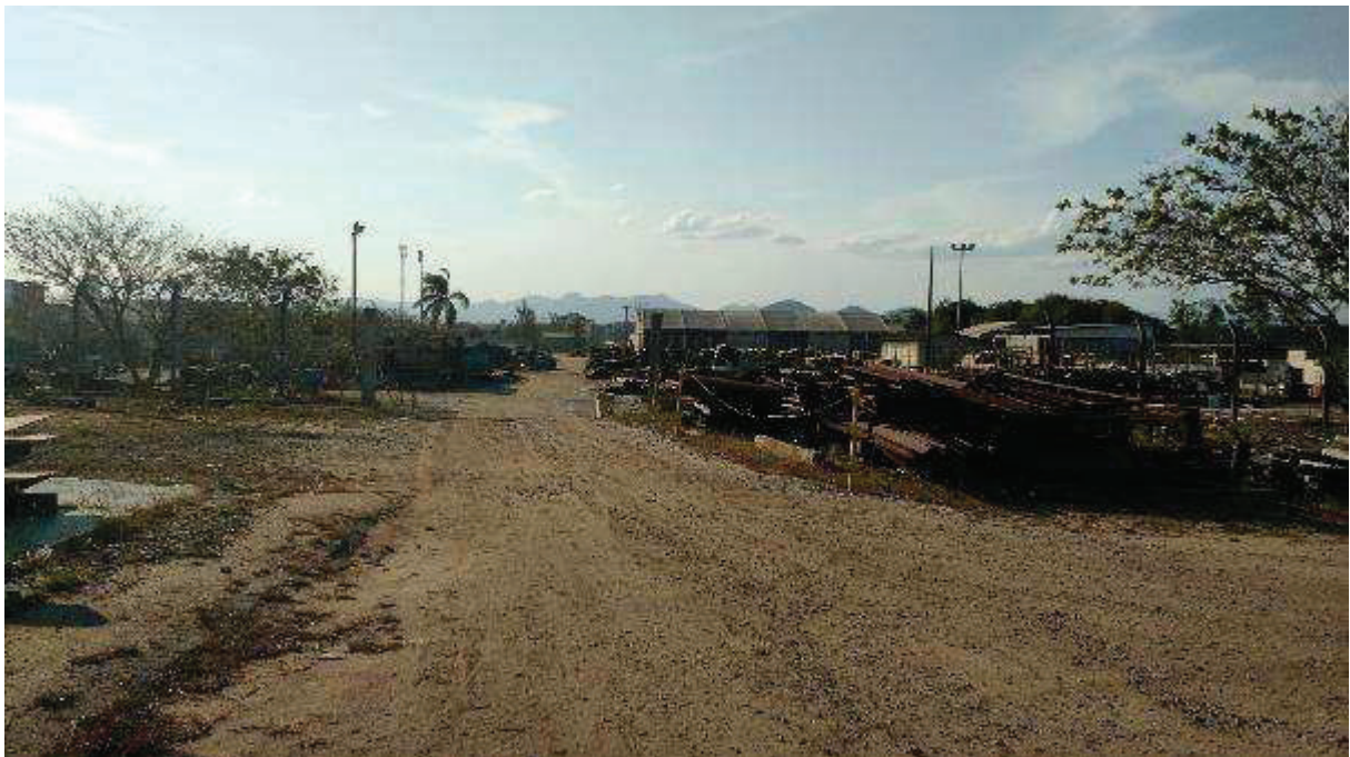
VISTA PARCIAL INTERNA DO IMÓVEL - AREA DE DEPOSITO DE MATERIAL
