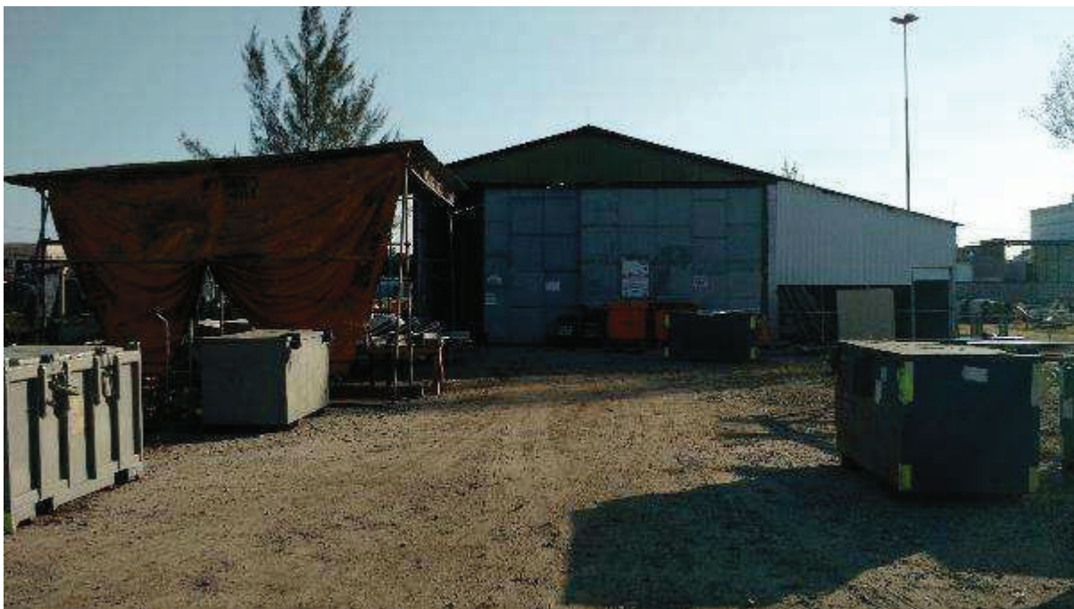
VISTA PARCIAL INTERNA DO IMÓVEL – DETALHE GALPÃO
