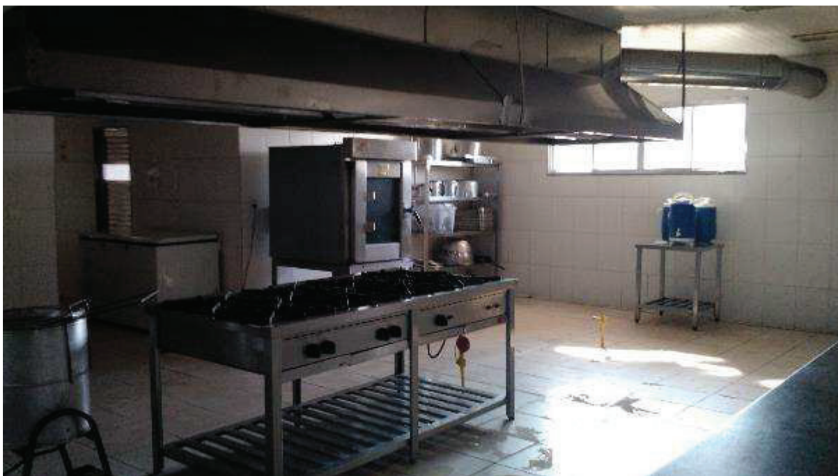
VISTA PARCIAL INTERNA DO IMÓVEL
