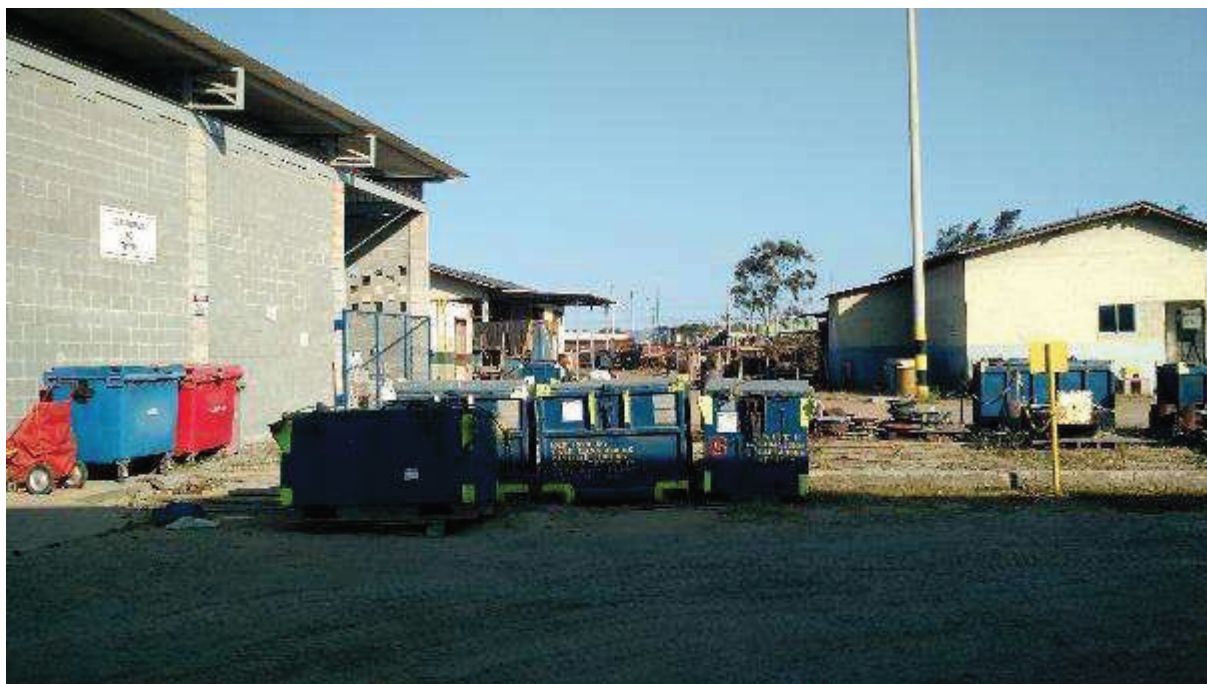
VISTA PARCIAL INTERNA DA BASE
