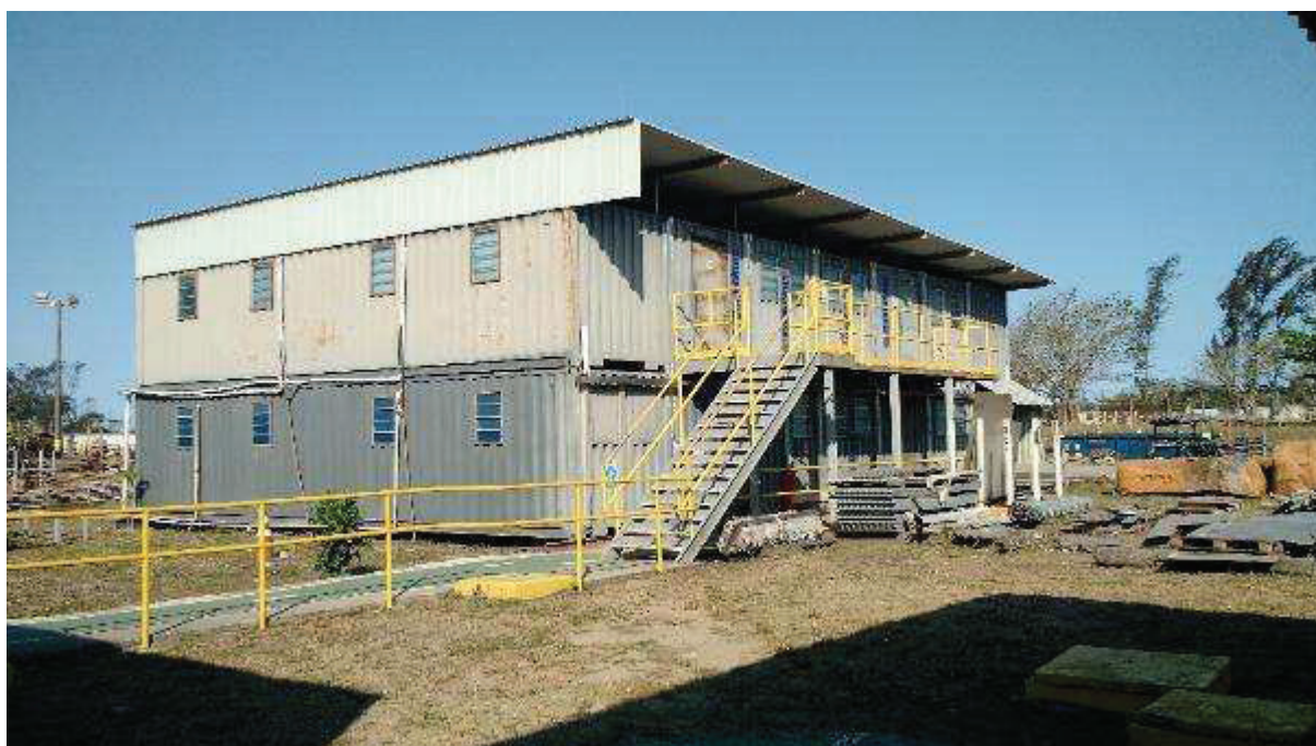
VISTA PARCIAL INTERNA DO IMÓVEL – DETALHE ESCRITÓRIO
