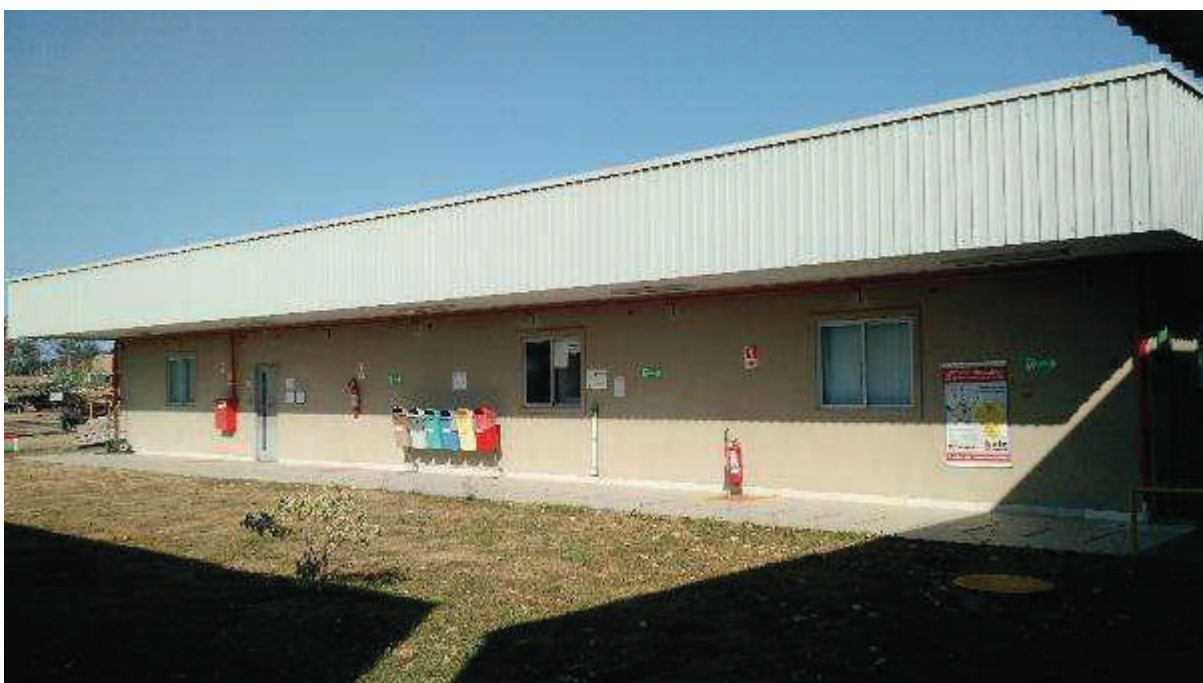
VISTA PARCIAL INTERNA DA BASE – DETALHE DO PREDIO DE ESCRITÓRIOS
