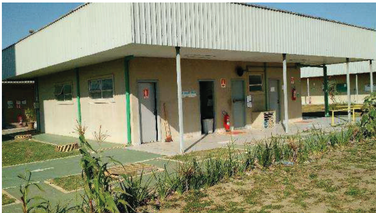
VISTA PARCIAL INTERNA DO IMÓVEL – DETALHE BANHEIROS
