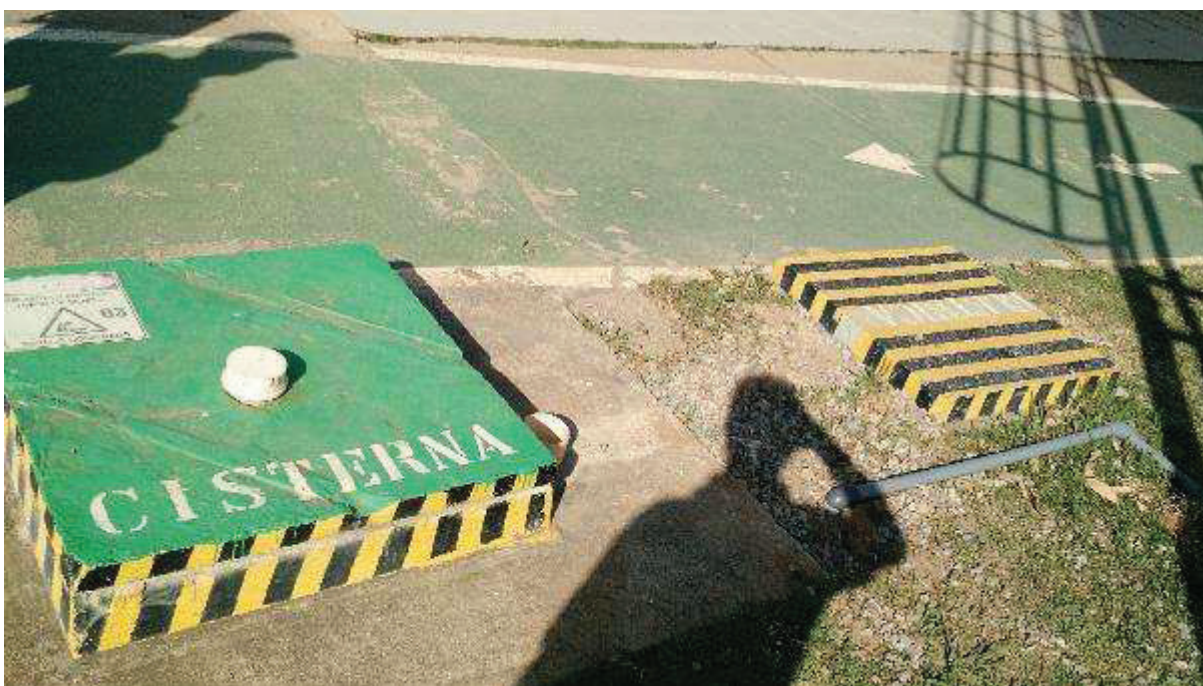
VISTA PARCIAL INTERNA DO IMÓVEL – DETALHE CISTERNA
