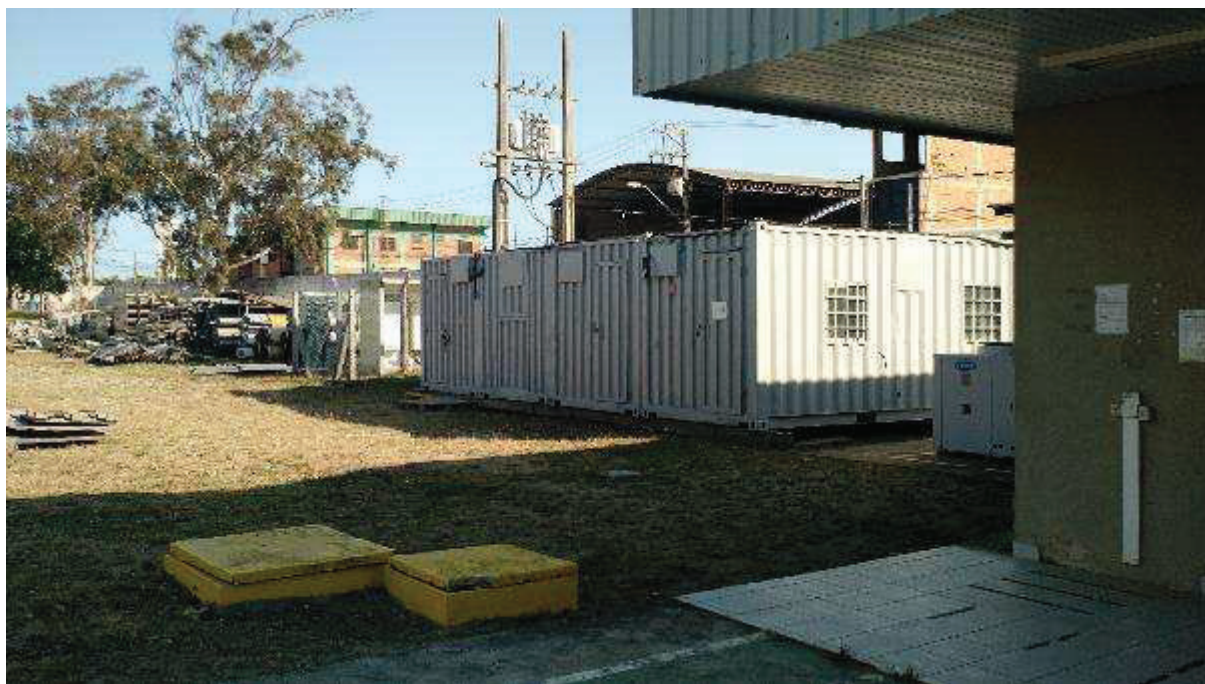
VISTA PARCIAL INTERNA DO IMÓVEL
