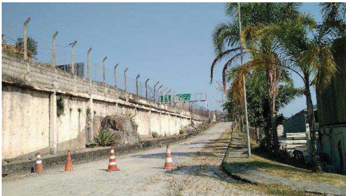
VISTA PARCIAL DO IMÓVEL – DETALHE PARA O ACESSO A AVENIDA DO CONTORNO PORTAO 3
