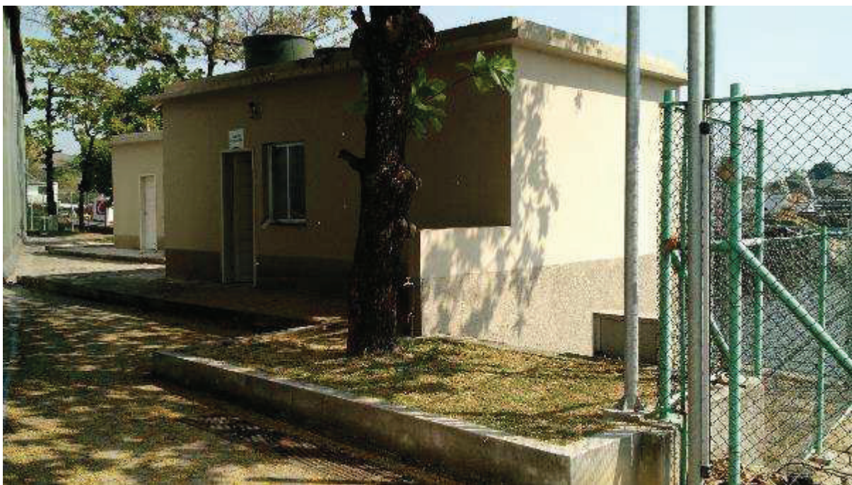
ÁREA 01 - VISTA PARCIAL DO IMÓVEL AVALIANDO – DETALHE PARA ESCRITÓRIO RECEITA FEDERAL
