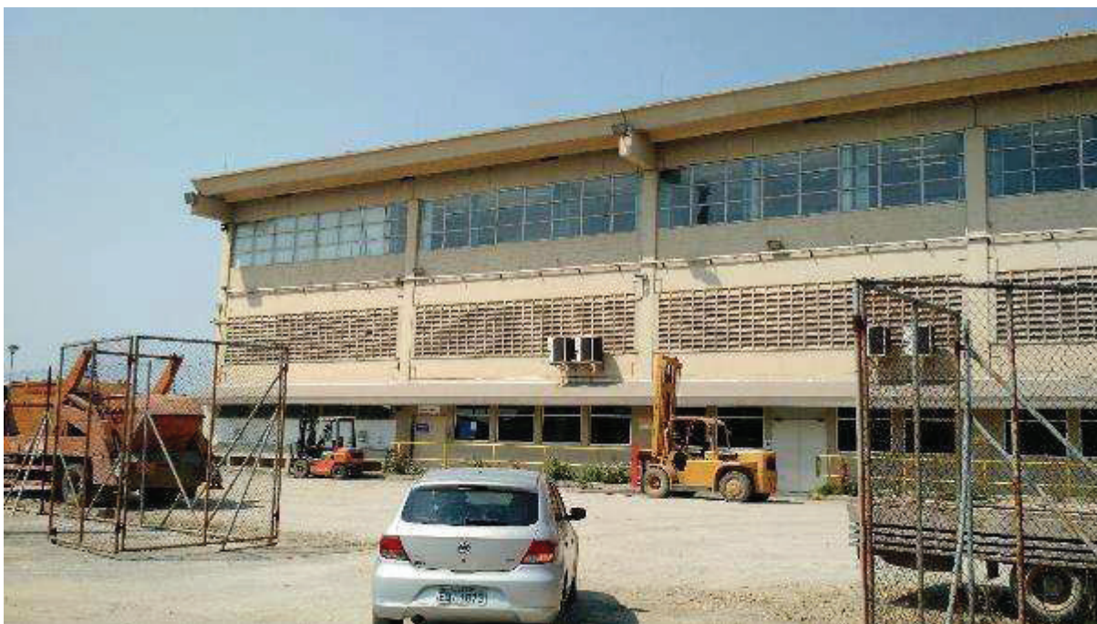
ÁREA 03 - VISTA PARCIAL DO IMÓVEL AVALIANDO – DETALHE PARA PRÉDIO ADMINISTRAÇÃO
