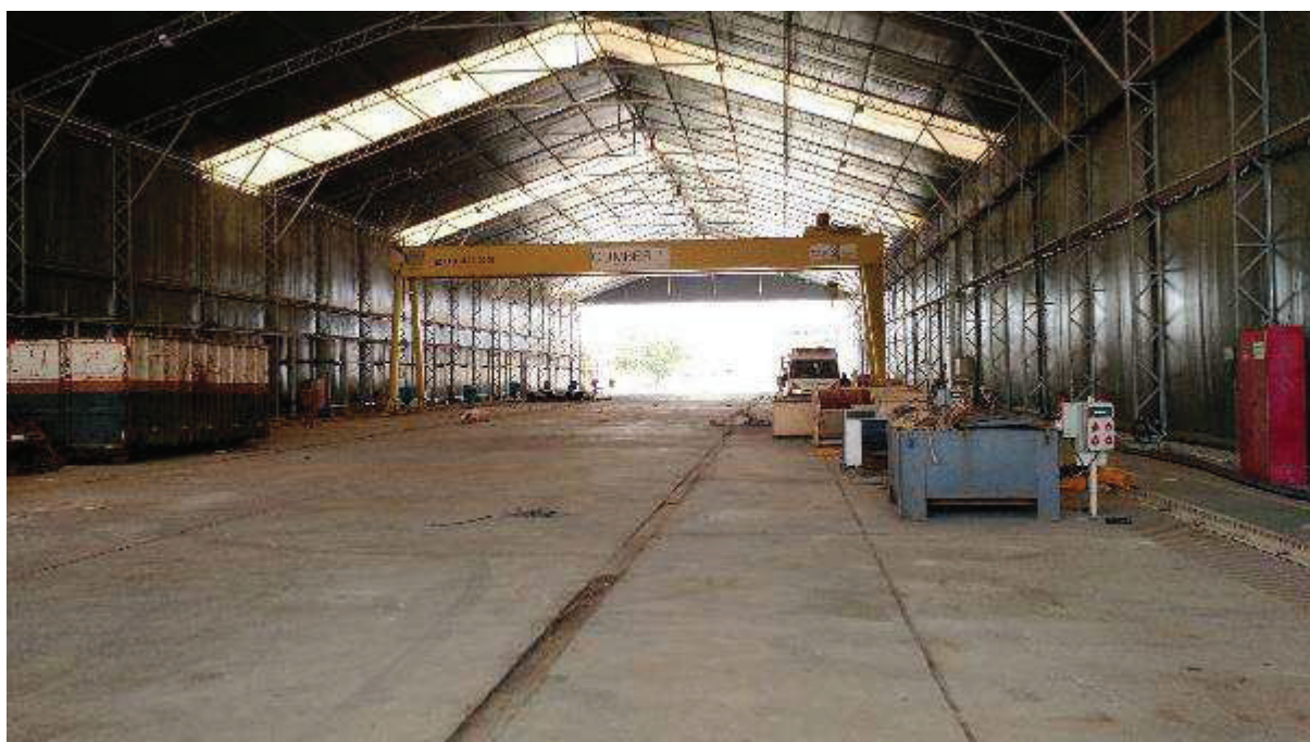
ÁREA 02 - VISTA PARCIAL DO IMÓVEL AVALIANDO – DETALHE PARA FÁBRICA
