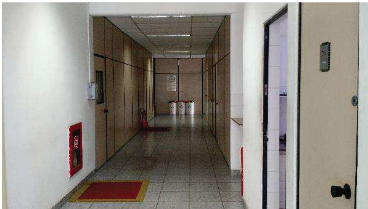
ÁREA 03 - VISTA PARCIAL INTERNA DO PRÉDIO DA ADMINISTRAÇÃO - DETALHE PARA PADRÃO CONSTRUTIVO
