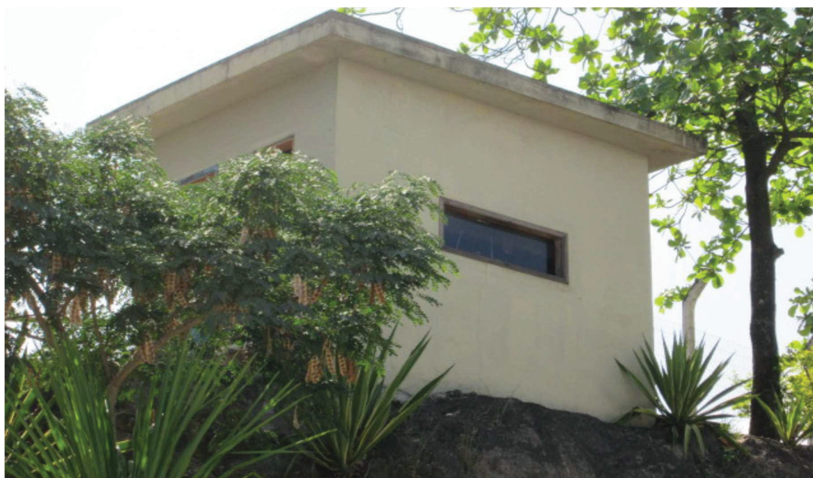
ÁREA 02 - VISTA PARCIAL DO IMÓVEL AVALIANDO – DETALHE PARA GUARITA
