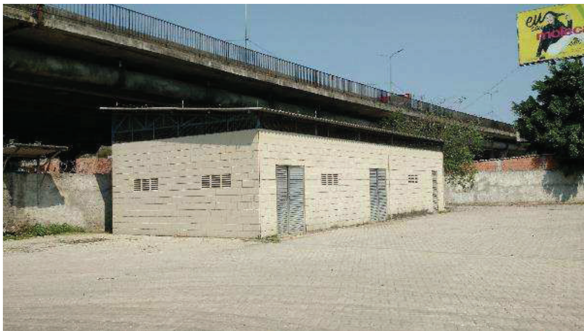
ÁREA 01 - VISTA PARCIAL DO IMÓVEL AVALIANDO – DETALHE PARA CENTRAL DE RESÍDUOS
