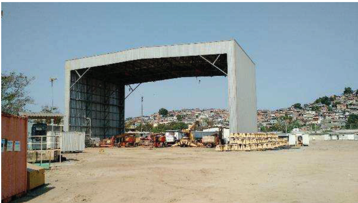
ÁREA 05 – VISTA PARCIAL DO IMÓVEL AVALIANDO - DETALHE PARA GALPÃO MÓVEL 01
