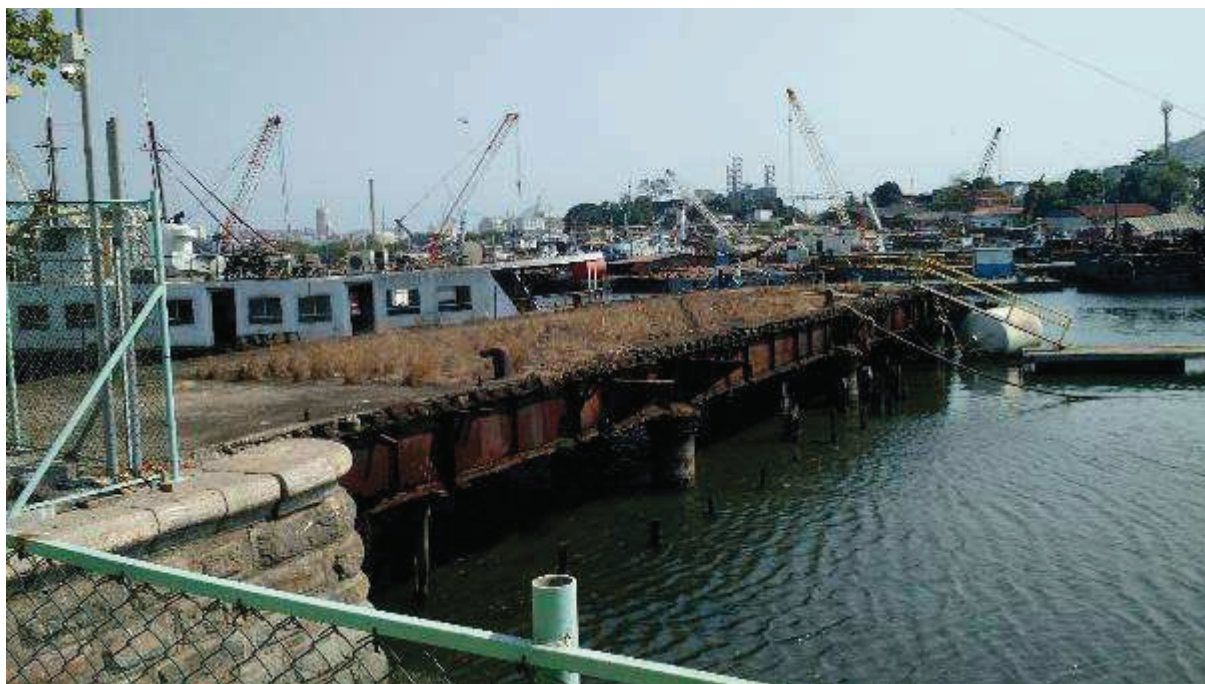
ÁREA 01 - VISTA PARCIAL DO IMÓVEL AVALIANDO – PIER DESATIVADO NA BAI DA GUANABARA
