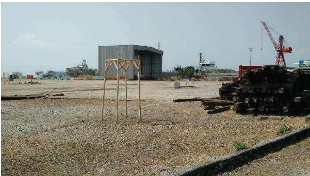
ÁREA 05 – VISTA PARCIAL DO IMÓVEL AVALIANDO – DETALHE PARA GALPÃO MÓVEL 02
