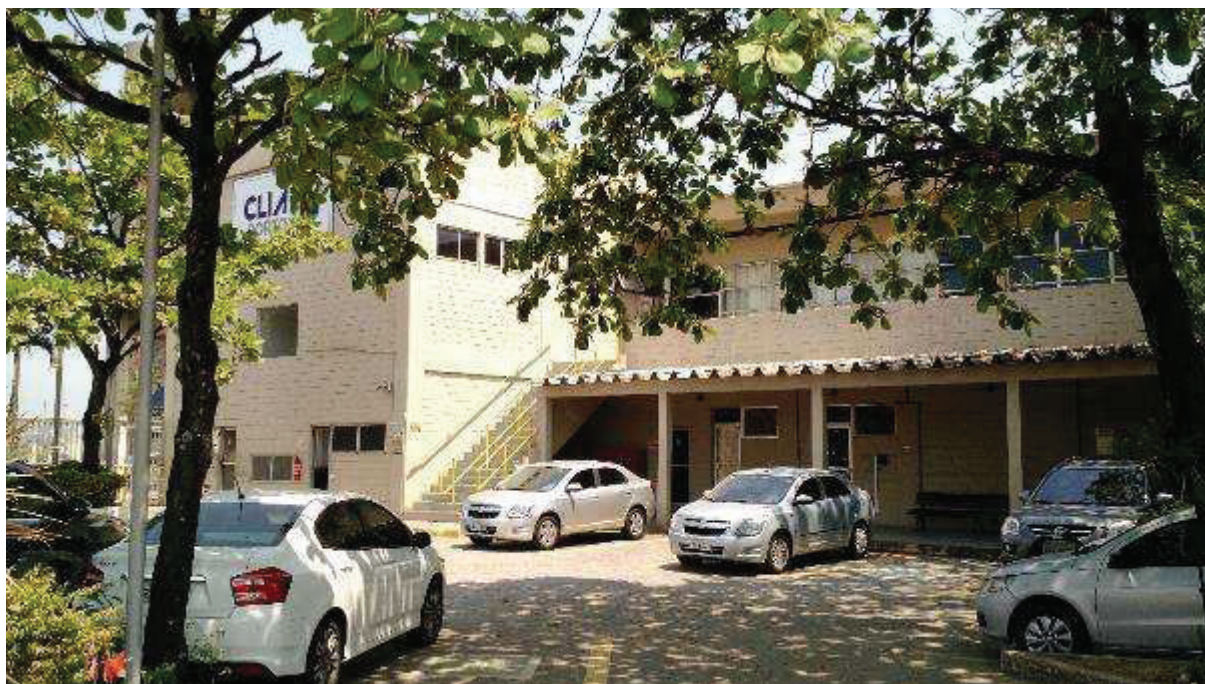
ÁREA 03 - VISTA PARCIAL IMÓVEL AVALIANDO – DETALHE PARA PRÉDIO ADMINISTRATIVO
