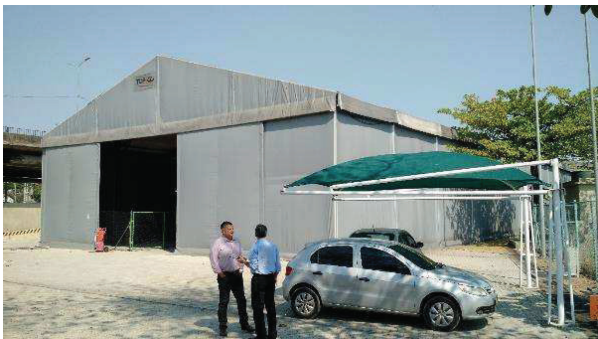
ÁREA 01 - VISTA PARCIAL DO IMÓVEL AVALIANDO – DETALHE PARA GALPÃO ALFANDEGADO
