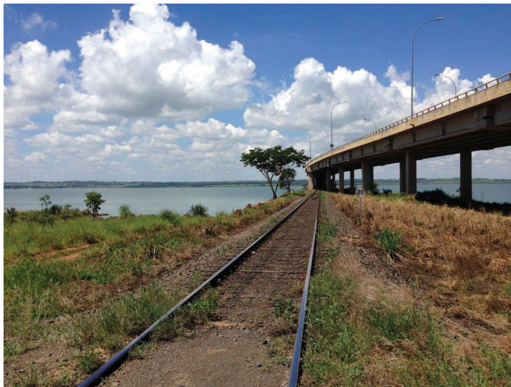
VISTA PARCIAL DO IMÓVEL – FAIXA DE DOMÍNIO DA FERROVIA
