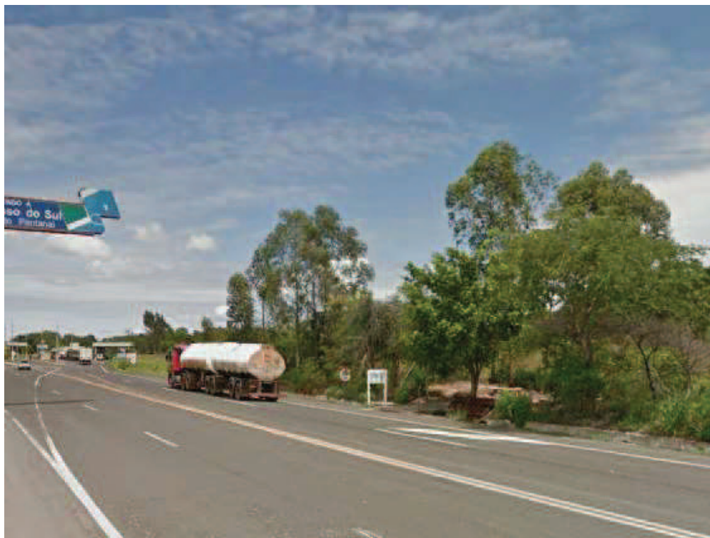
VISTA PARCIAL RODOVIA AV PRESIDENTE VARGAS SENTIDO CENTRO APARECIDA DO TABOADO– DETALHE ACESSO AO IMOVEL CÓRREGO DO CAMPO
