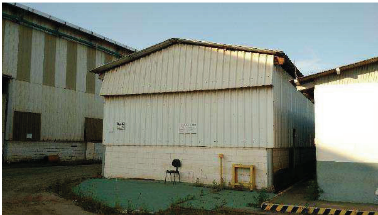
VISTA PARCIAL INTERNA DO IMÓVEL – DETALHE GALPÃO
