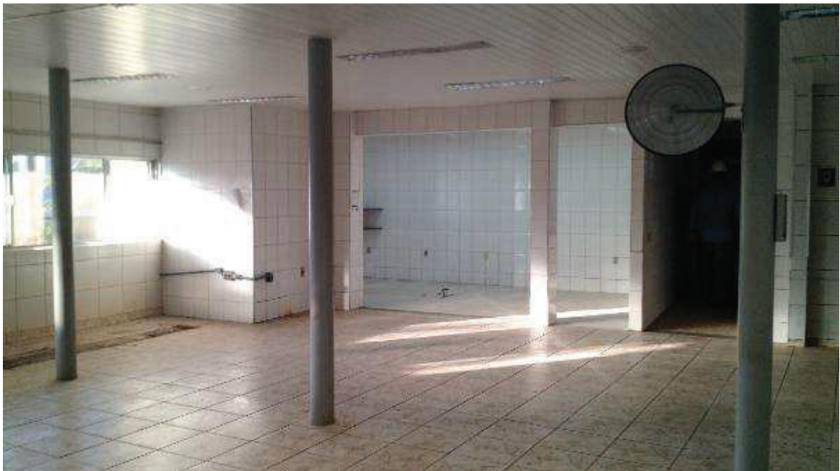
VISTA PARCIAL INTERNA DO REFEITORIO
