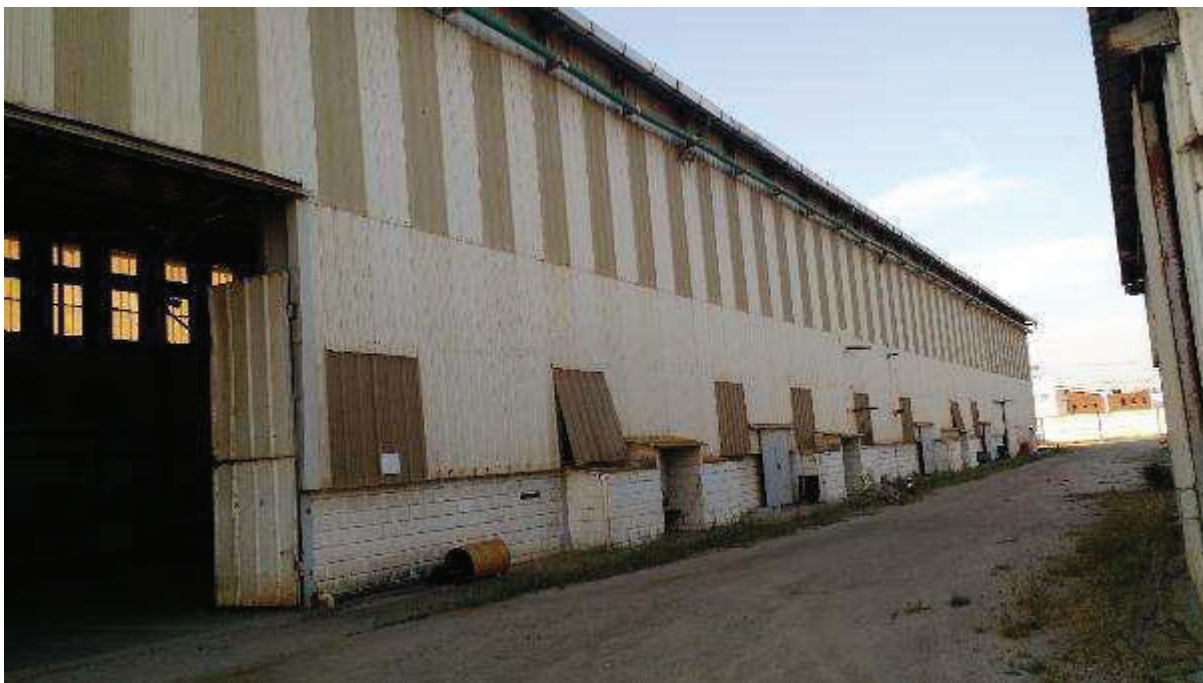
VISTA PARCIAL INTERNA DO IMÓVEL – DETALHE GALPÃO
