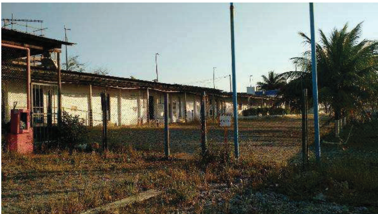
VISTA PARCIAL INTERNA DO IMÓVEL
