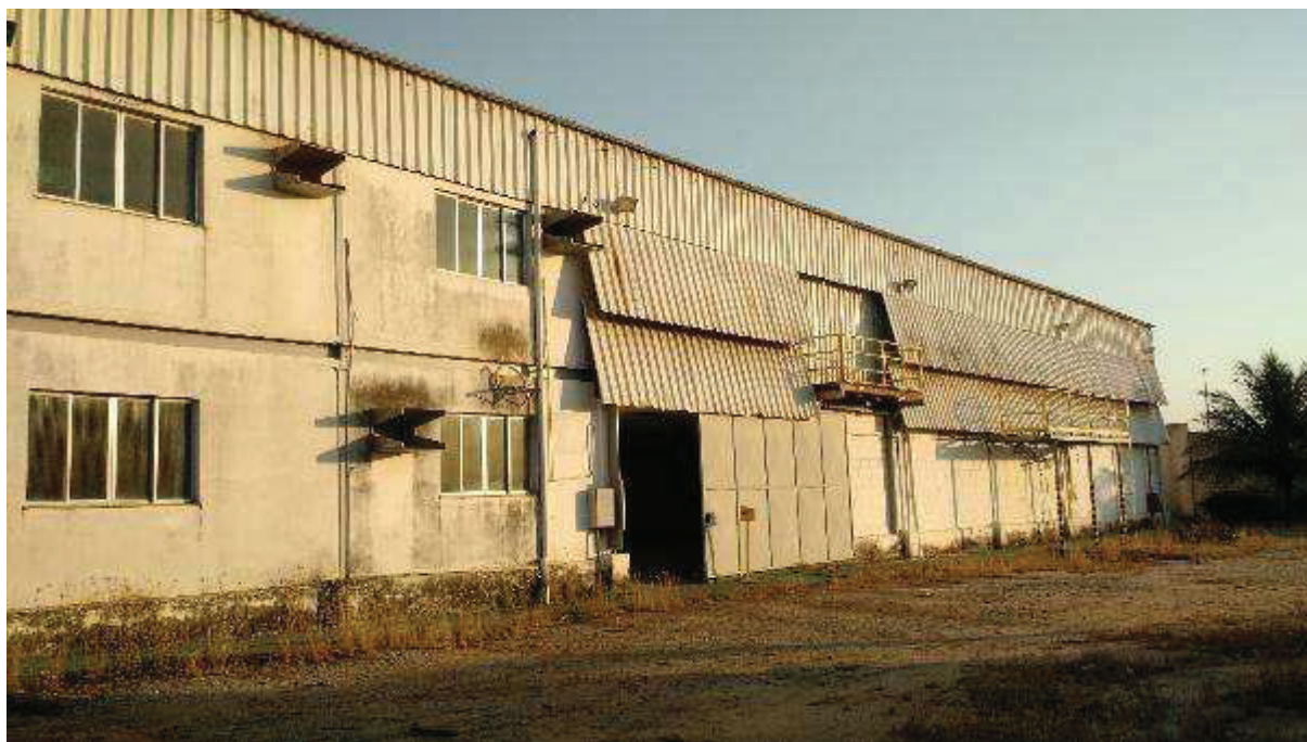
VISTA PARCIAL INTERNA DO IMÓVEL – DETALHE GALPÃO
