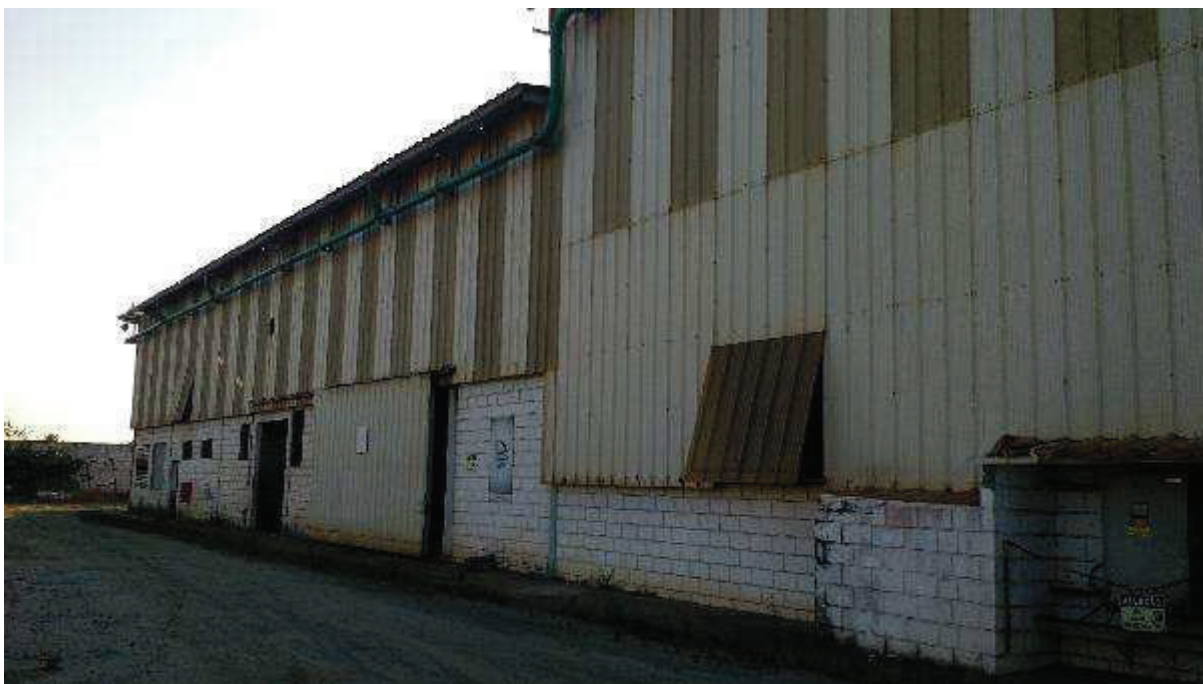
VISTA PARCIAL INTERNA DO IMÓVEL – DETALHE GALPÃO
