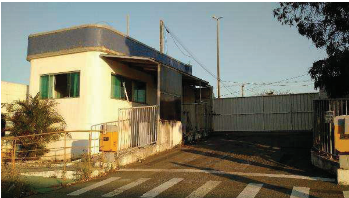
VIA PARCIAL INTERNA DO IMÓVEL – DETALHE GUARITA
