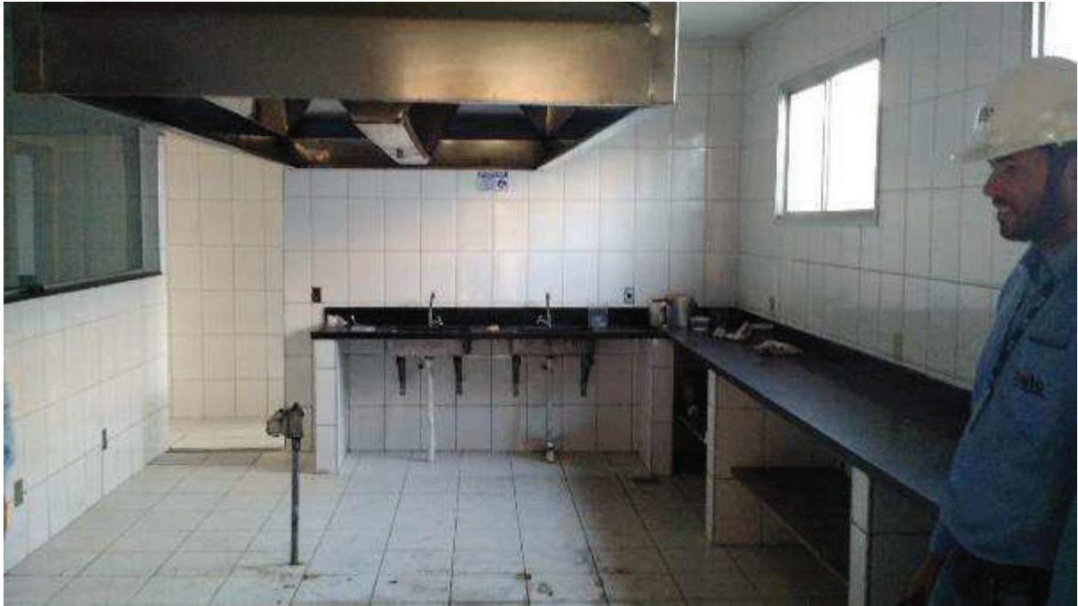
VISTA PARCIAL INTERNA DO REFEITORIO
