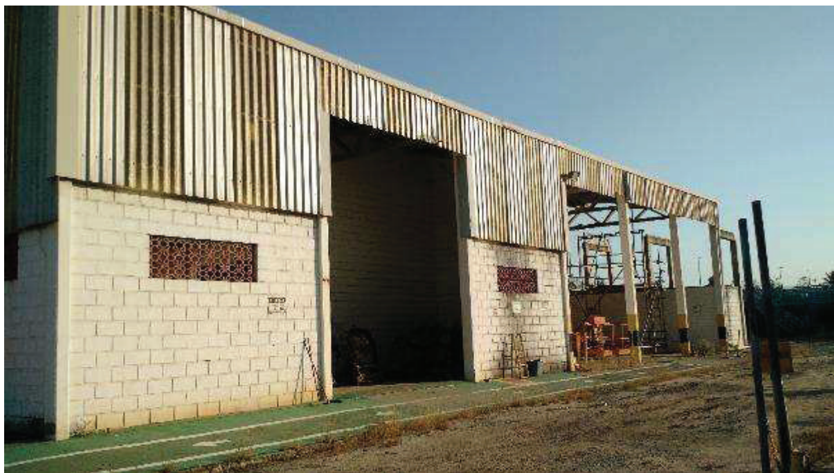
VISTA PARCIAL INTERNA DO IMÓVEL – DETALHE GALPÃO
