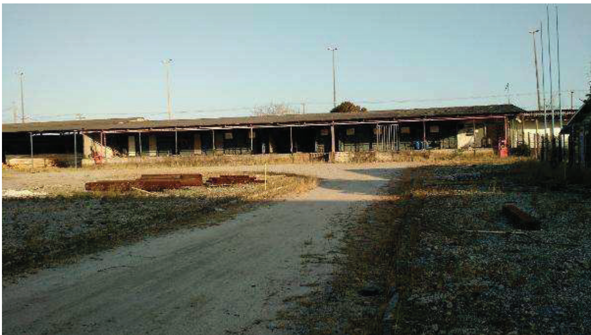
VISTA PARCIAL INTERNA DO IMÓVEL
