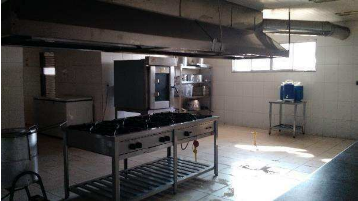
VISTA PARCIAL INTERNA DO IMÓVEL
