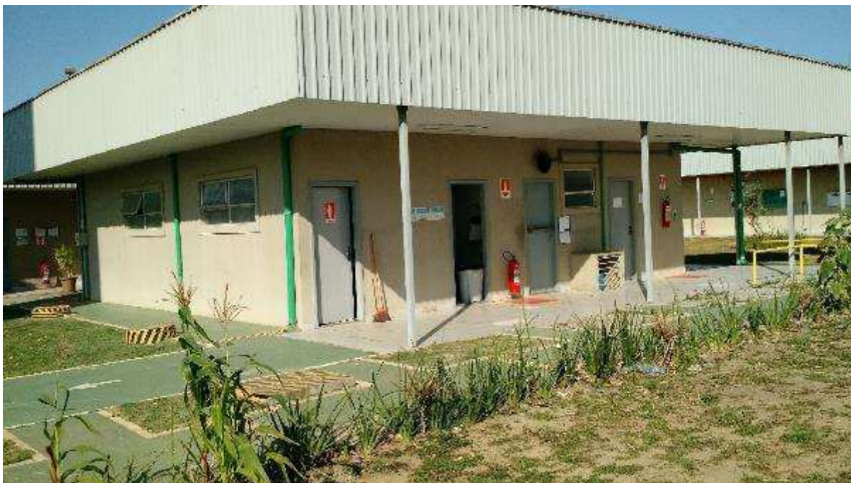
VISTA PARCIAL INTERNA DO IMÓVEL – DETALHE BANHEIROS
