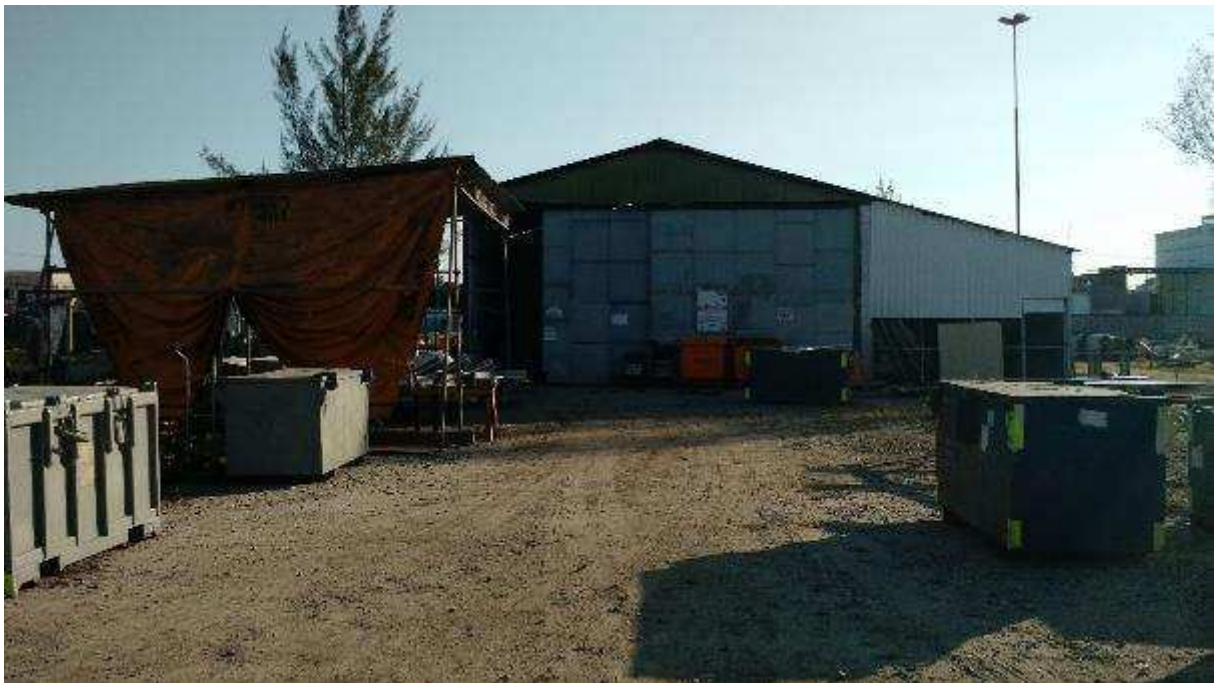
VISTA PARCIAL INTERNA DO IMÓVEL – DETALHE GALPÃO
