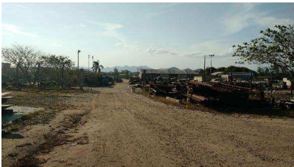
VISTA PARCIAL INTERNA DO IMÓVEL - AREA DE DEPOSITO DE MATERIAL
