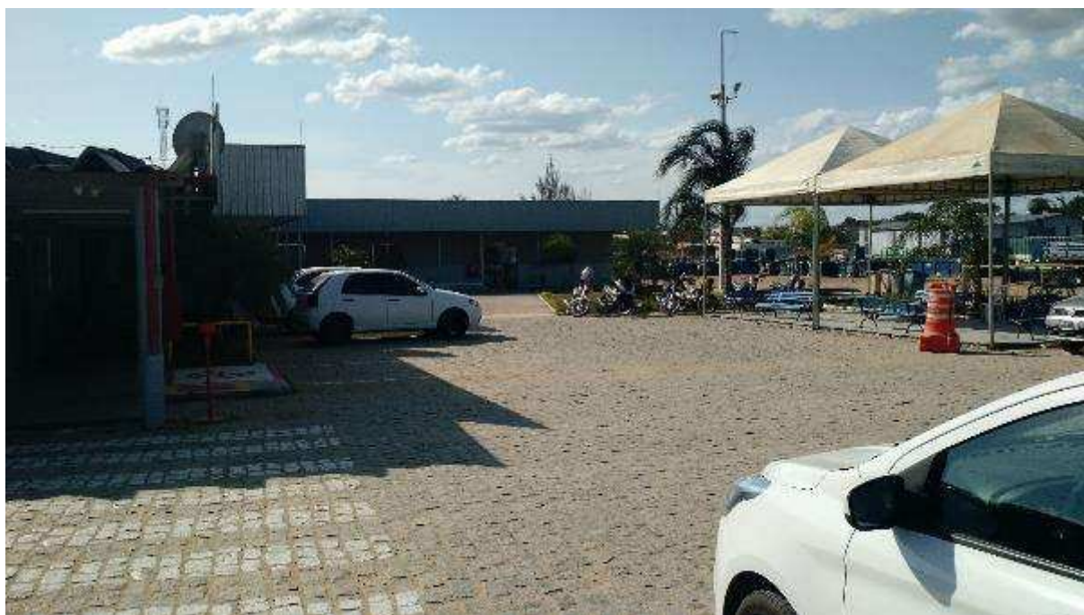
VISTA PARCIAL INTERNA DO IMÓVEL
