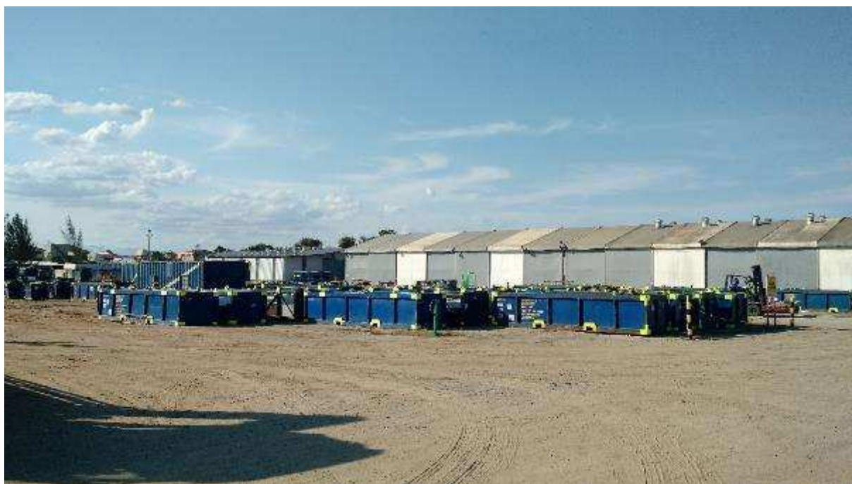
VISTA PARCIAL INTERNA DA BASE
