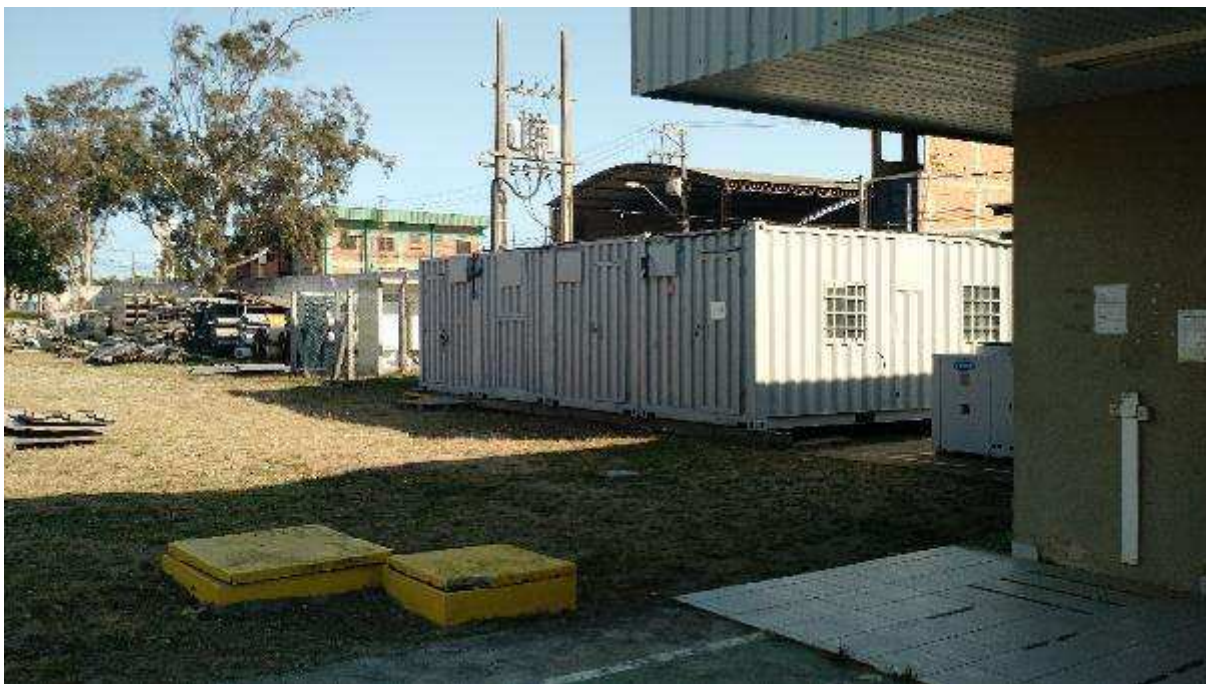
VISTA PARCIAL INTERNA DO IMÓVEL
