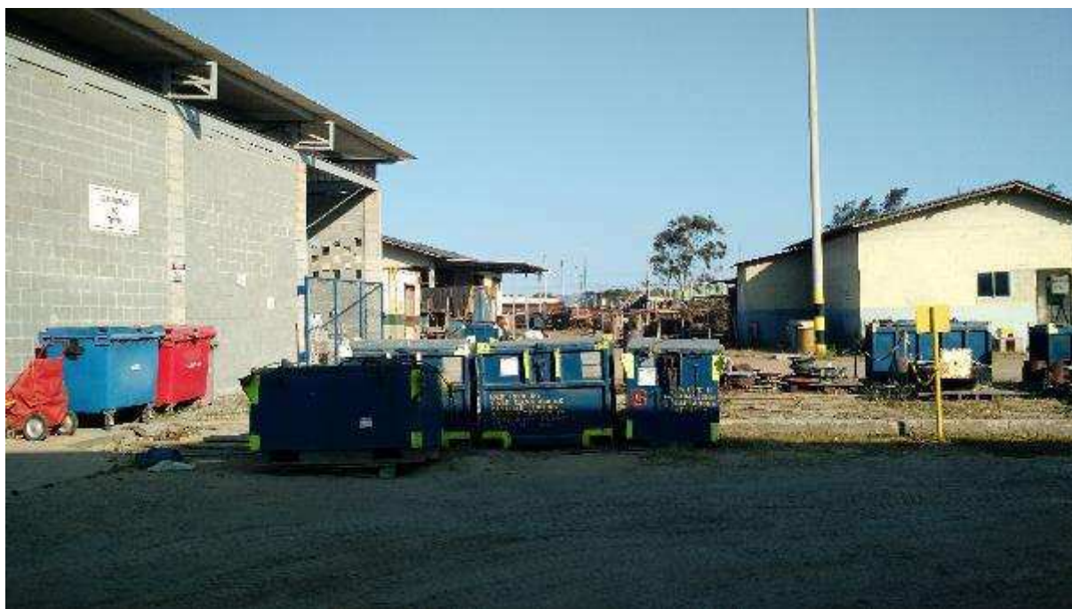
VISTA PARCIAL INTERNA DA BASE
