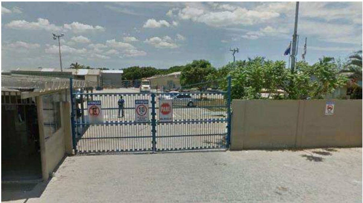
VISTA PARCIAL EXTERNA IMÓVEL DO IMÓVEL – DETALHE FRENTE PARA RUA JOSE RECORDER
