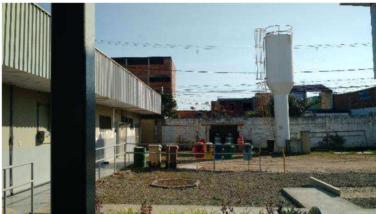
VISTA PARCIAL INTERNA DA BASE – DETALHE DA CAIXA D'ÁGUA
