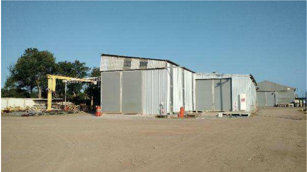
VISTA PARCIAL INTERNA DO IMÓVEL – DETALHE GALPÃO
