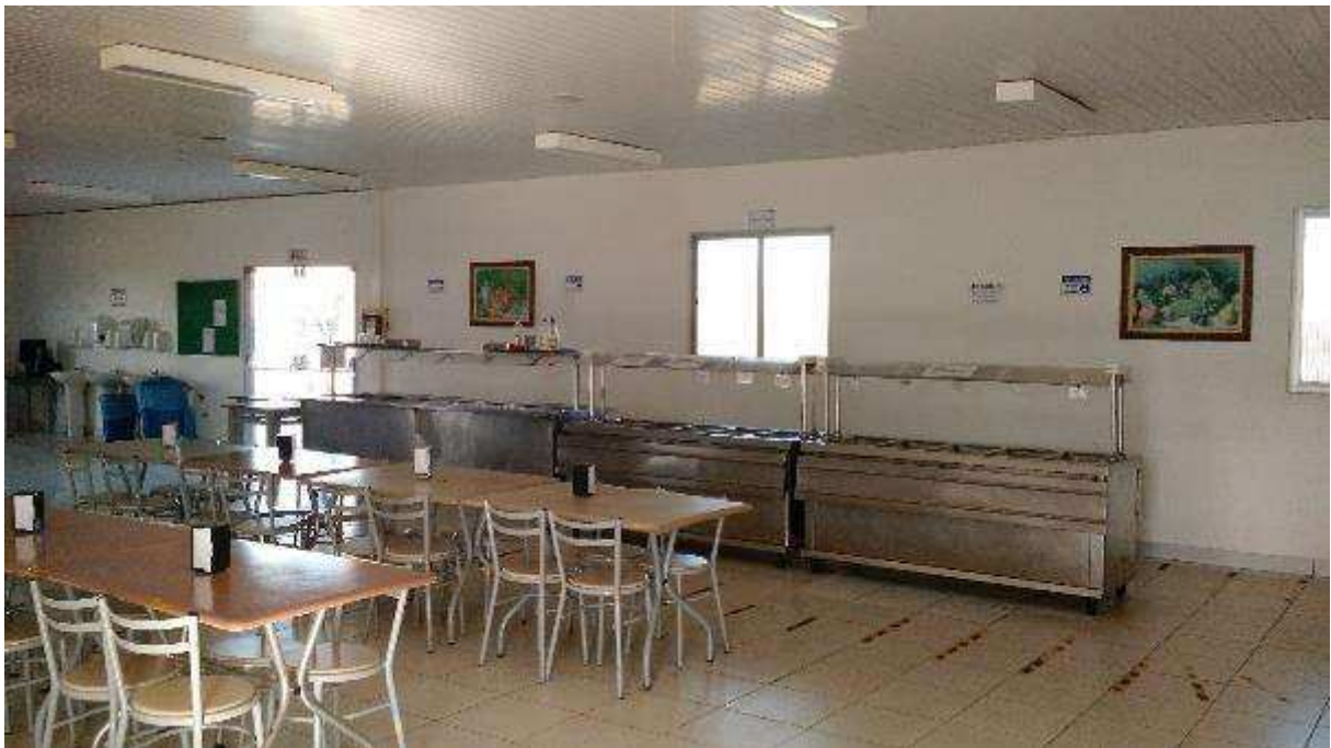
VISTA PARCIAL INTERNA DO IMÓVEL – DETALHE PARA REFEOTÓRIO
