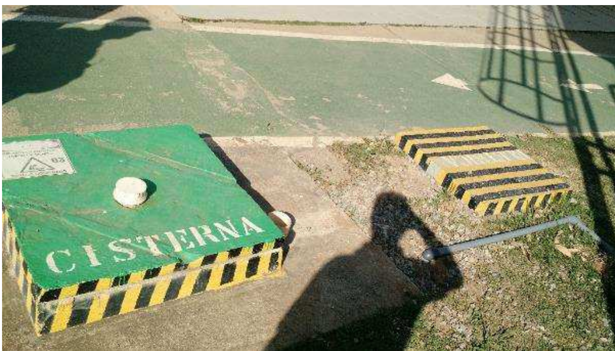
VISTA PARCIAL INTERNA DO IMÓVEL – DETALHE CISTERNA
