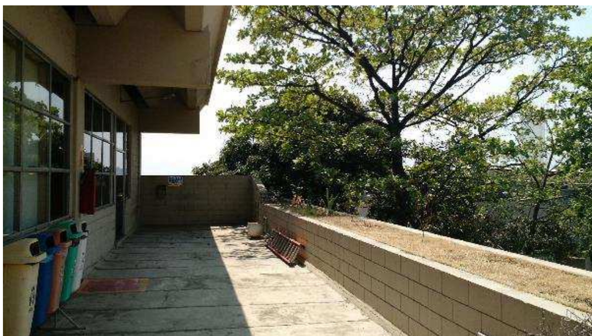
ÁREA 03 - VISTA PARCIAL DO IMÓVEL AVALIANDO – PRÉDIO ADINISTRATIVO
