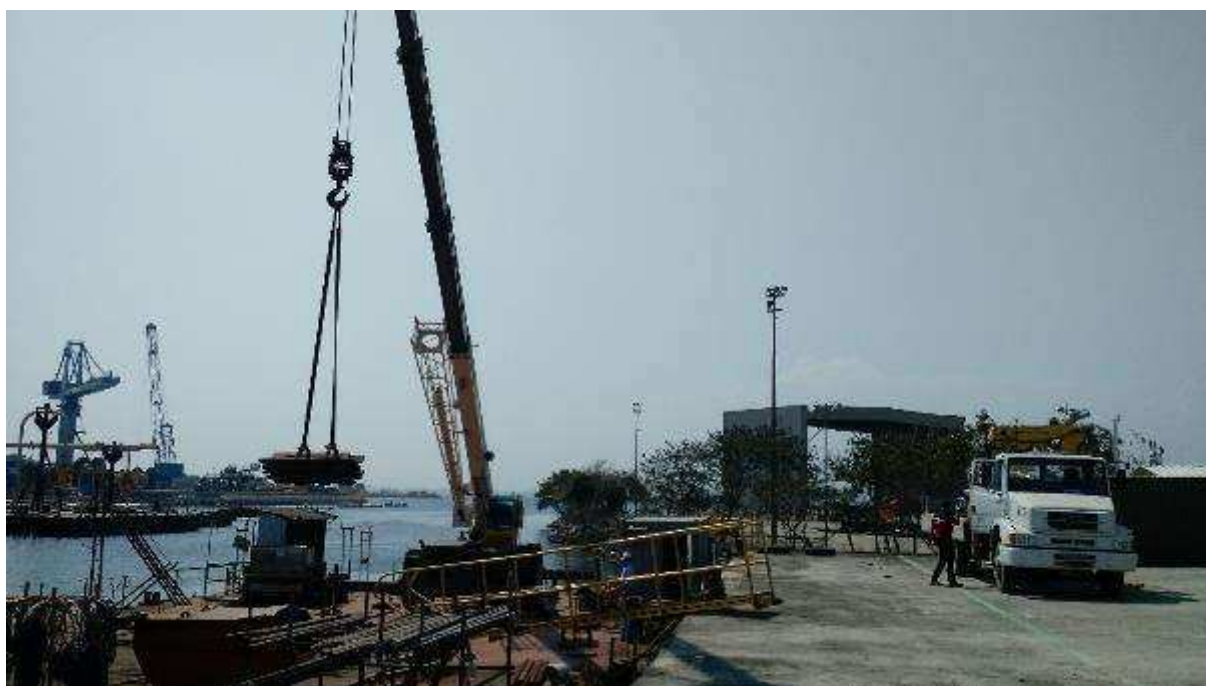
ÁREA 05 – VISTA PARCIAL DO IMÓVEL AVALIANDO - PIER
