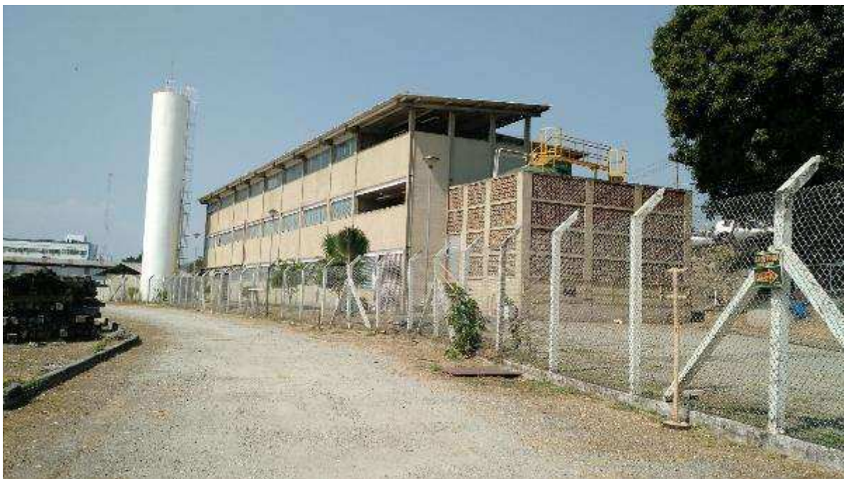
ÁREA 04 – VISTA PARCIAL DO IMÓVEL AVALIANDO – DETALHE PARA PRÉDIO DE VESTIÁRIOS E ESTAÇÃO DE TRATAMENTO DE ESGOTO
