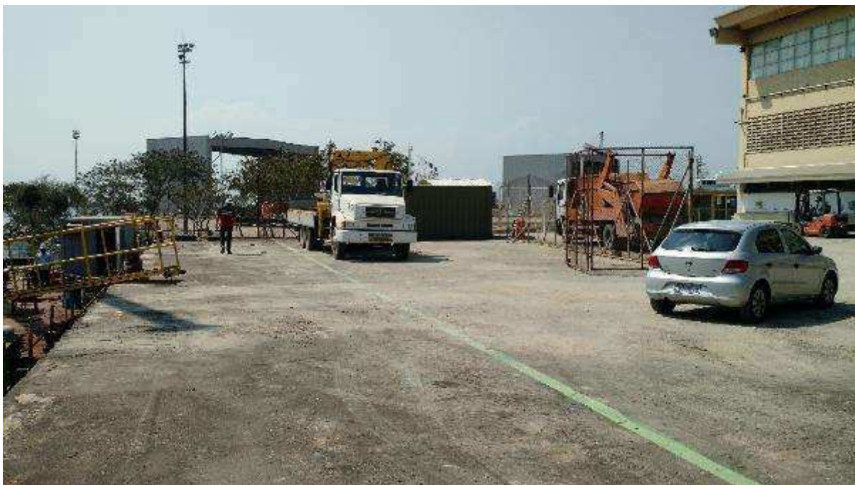
ÁREA 03 - VISTA PARCIAL DO IMÓVEL AVALIANDO - PIER
