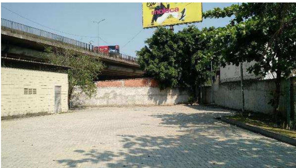
ÁREA 01 - VISTA PARCIAL DO IMÓVEL AVALIANDO - PATIO DE ESTACIONAMENTO
