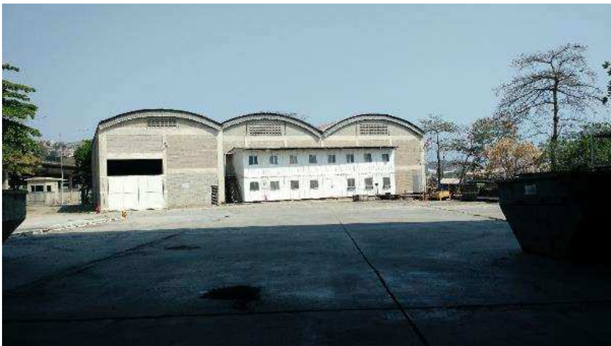
ÁREA 01 - VISTA PARCIAL DO IMÓVEL AVALIANDO – DETALHE PARA GALPÕES DE ALMOXERIFADO
