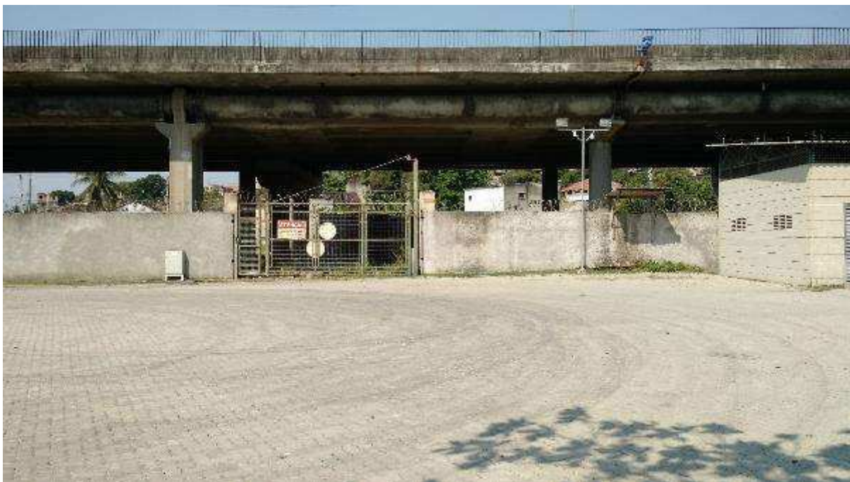
ÁREA 01 - VISTA PARCIAL DO IMÓVEL AVALIANDO – DETALHE PARA ACESSO A AREA SOB O VIADUTO DA BR - 101
