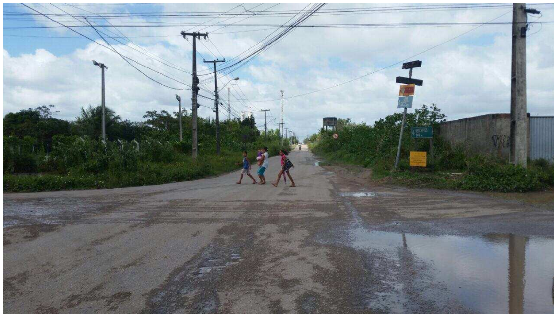
VISTA PARCIAL DA RUA B11 SENTIDO BAIRRO DAS INDUSTRIAS
