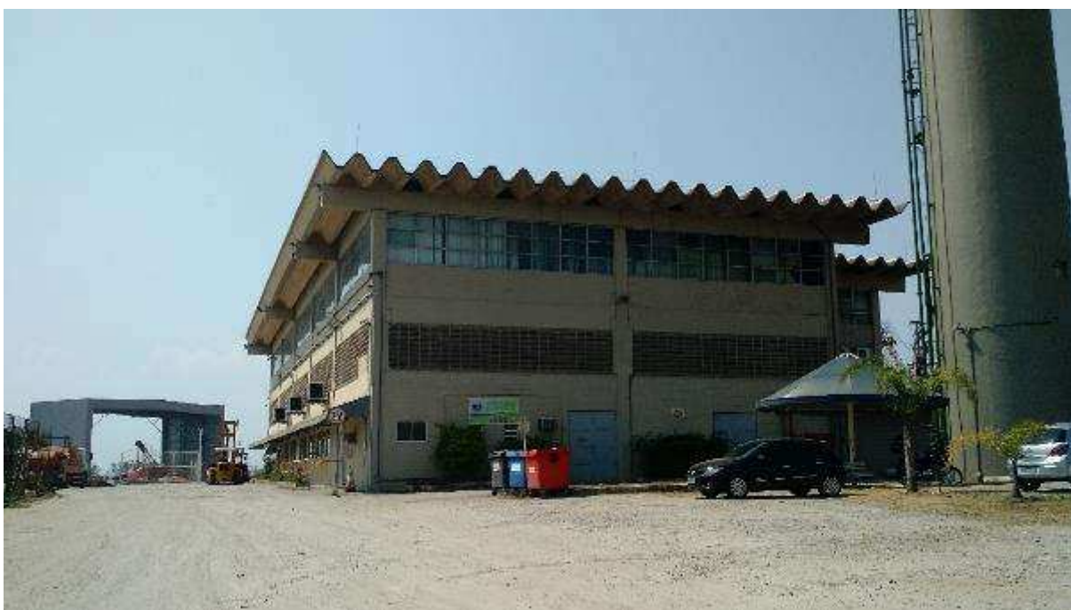
ÁREA 03 - VISTA PARCIAL DO IMÓVEL AVALIANDO – DETALHE PARA PREDIO ADMINISTRATIVO
