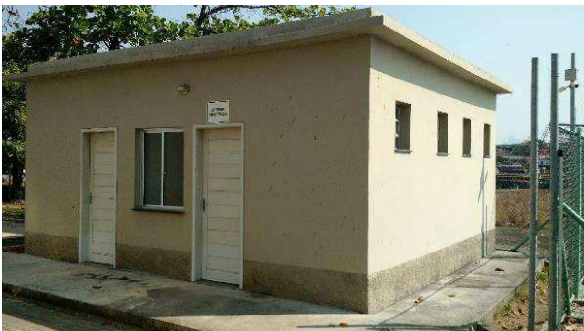
ÁREA 01 - VISTA PARCIAL DO IMÓVEL AVALIANDO – DETALHE PARA ESCRITÓRIO ADMINISTRAÇÃO
