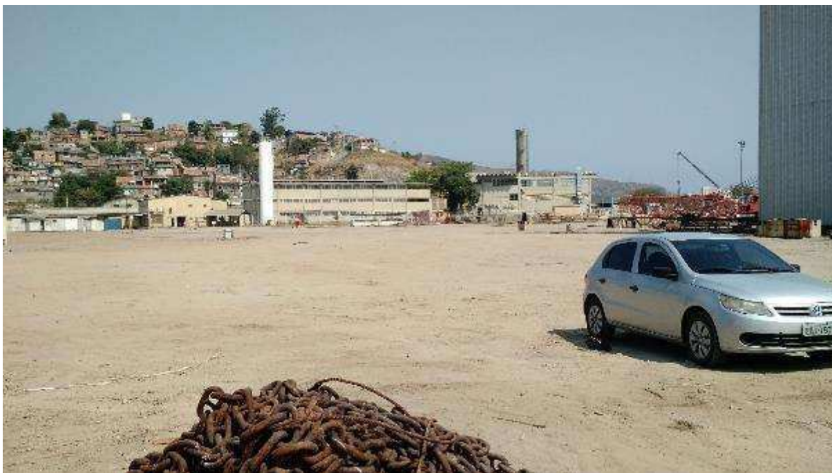
ÁREA 05 – VISTA PARCIAL DO IMÓVEL AVALIANDO – PATIO DE ARMAZENAMENTO
