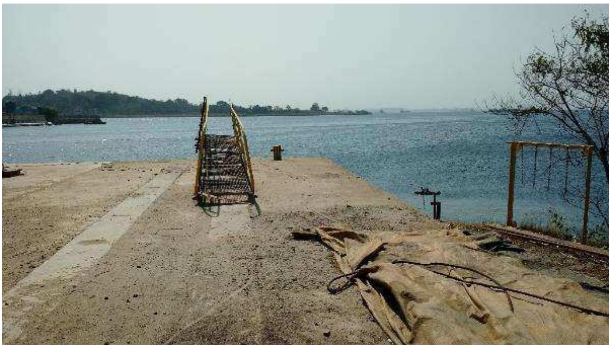
ÁREA 05 – VISTA PARCIAL DO IMÓVEL AVALIANDO - PIER
