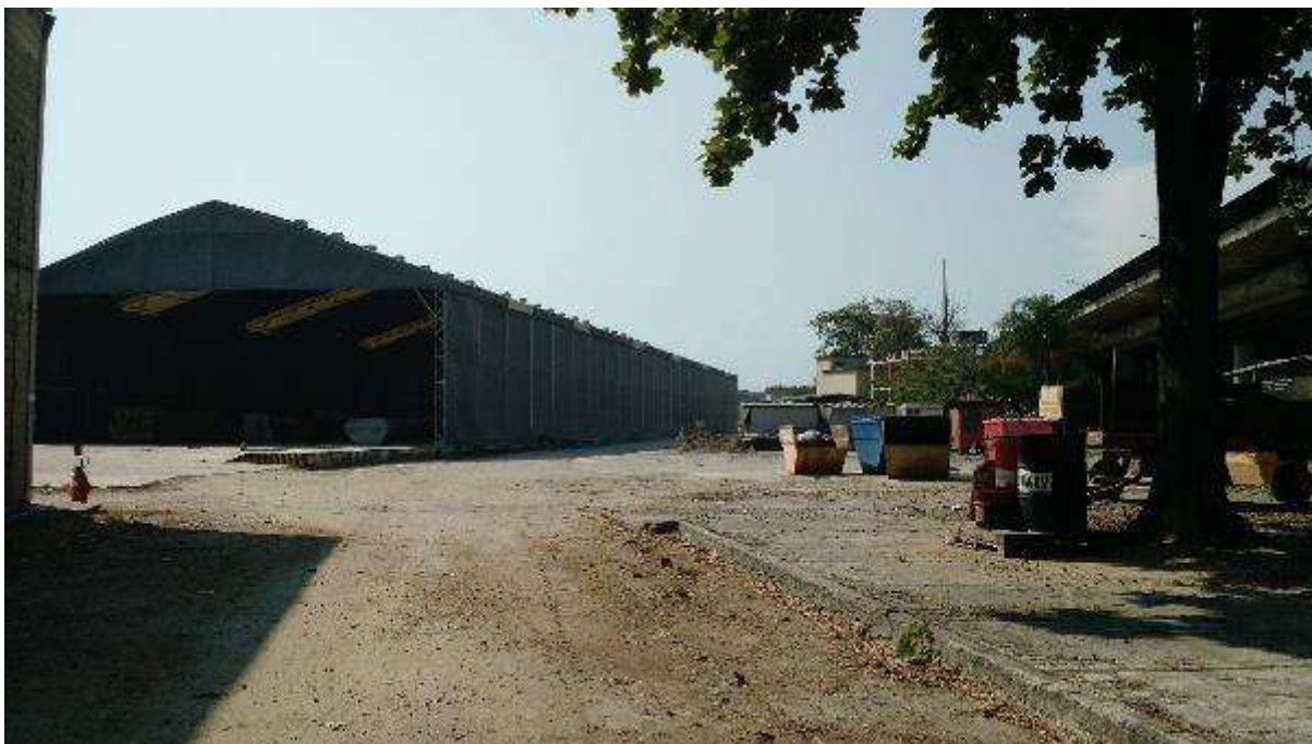
ÁREA 02 - VISTA PARCIAL DO IMÓVEL AVALIANDO – DETALHE GALPÃO DA FÁBRICA
