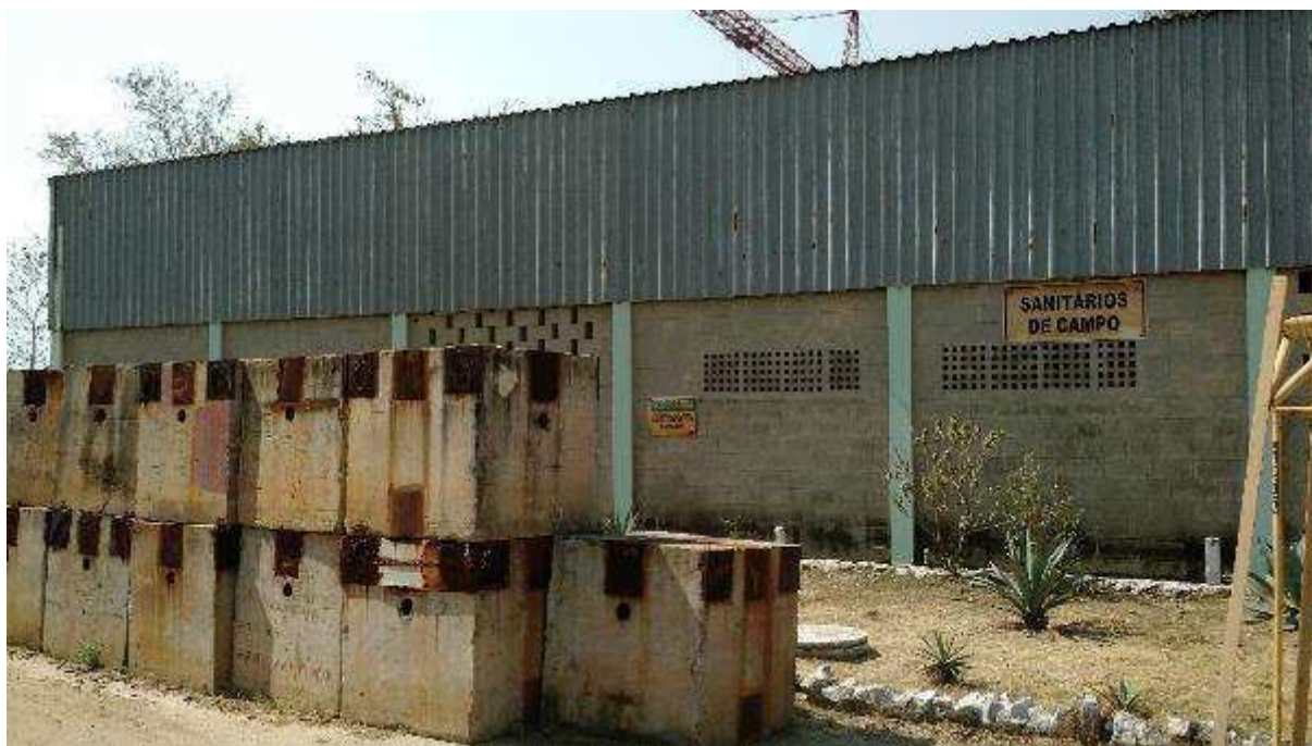
ÁREA 04 - VISTA PACIAL DO IMÓVEL AVALIANDO DETALHE PARA PRÉDIO DE VESTIÁRIO/SANITÁRIO EM CAMPO
