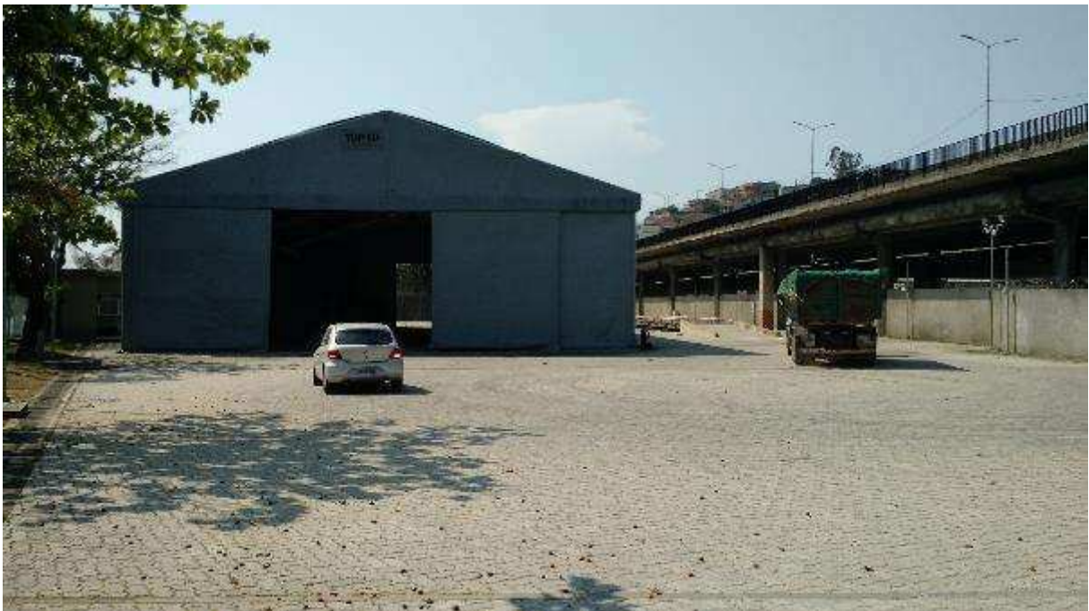
ÁREA 01 - VISTA PARCIAL DO IMÓVEL AVALIANDO – DETALHE PARA GALPÃO ALFANDEGADO
