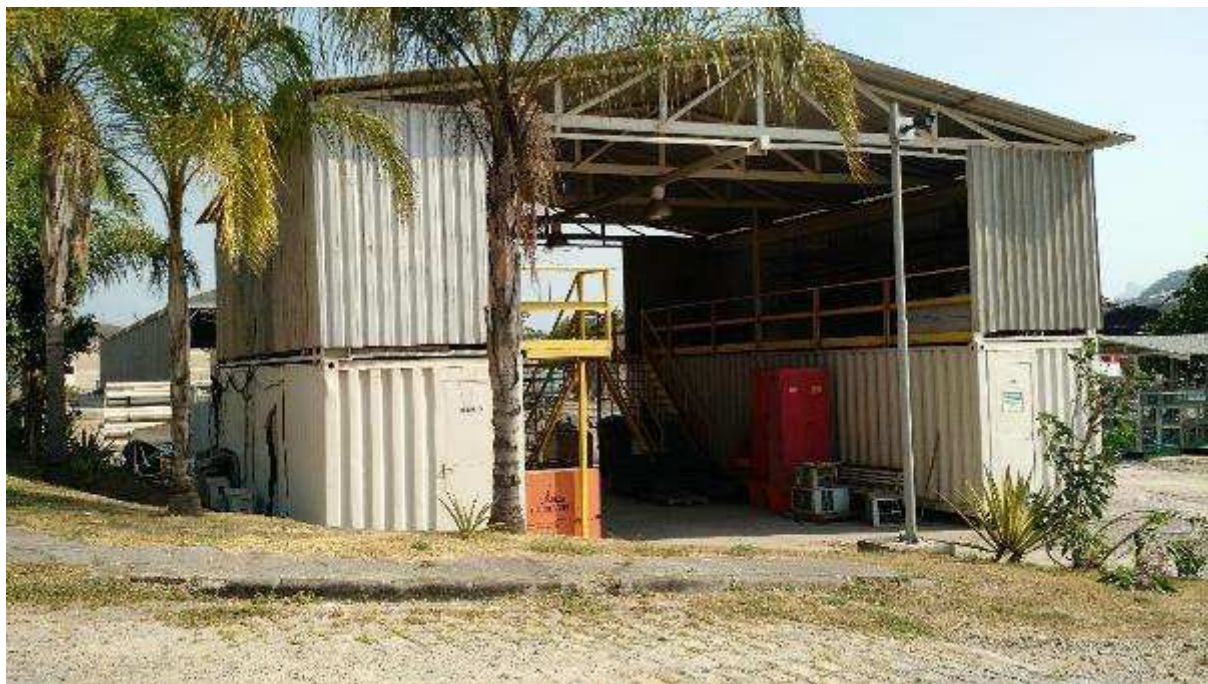
ÁREA 02 - VISTA PARCIAL DO IMÓVEL AVALIANDO – DETALHE PARA PAIOL DE TINTAS
