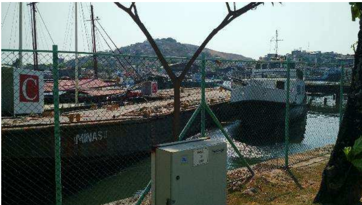
ÁREA 01 - VISTA PARCIAL DO IMÓVEL AVALIANDO - BAIÁ DA GUANABARA
