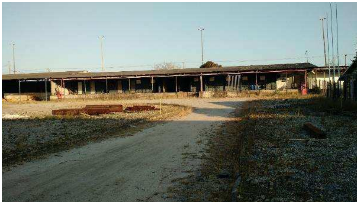
VISTA PARCIAL INTERNA DO IMÓVEL
