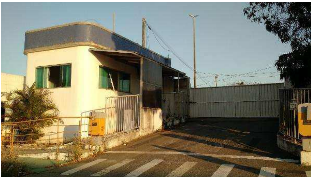
VIA PARCIAL INTERNA DO IMÓVEL – DETALHE GUARITA
