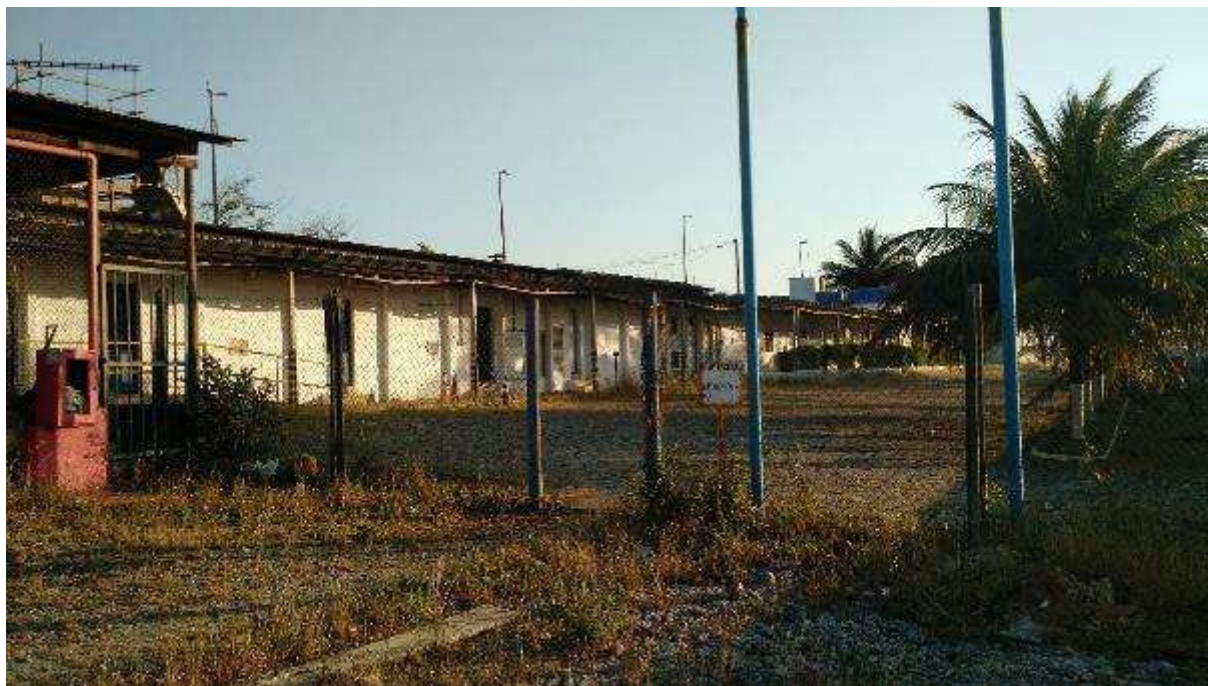
VISTA PARCIAL INTERNA DO IMÓVEL
