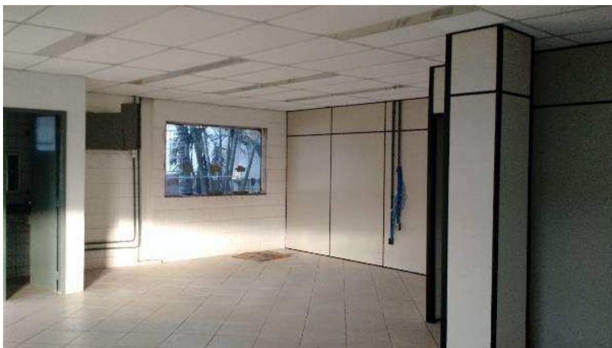
VISTA PARCIAL INTERNA DO IMÓVEL
