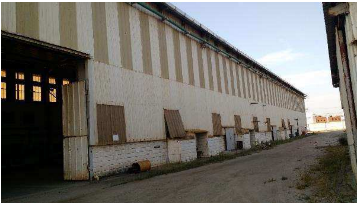
VISTA PARCIAL INTERNA DO IMÓVEL – DETALHE GALPÃO
