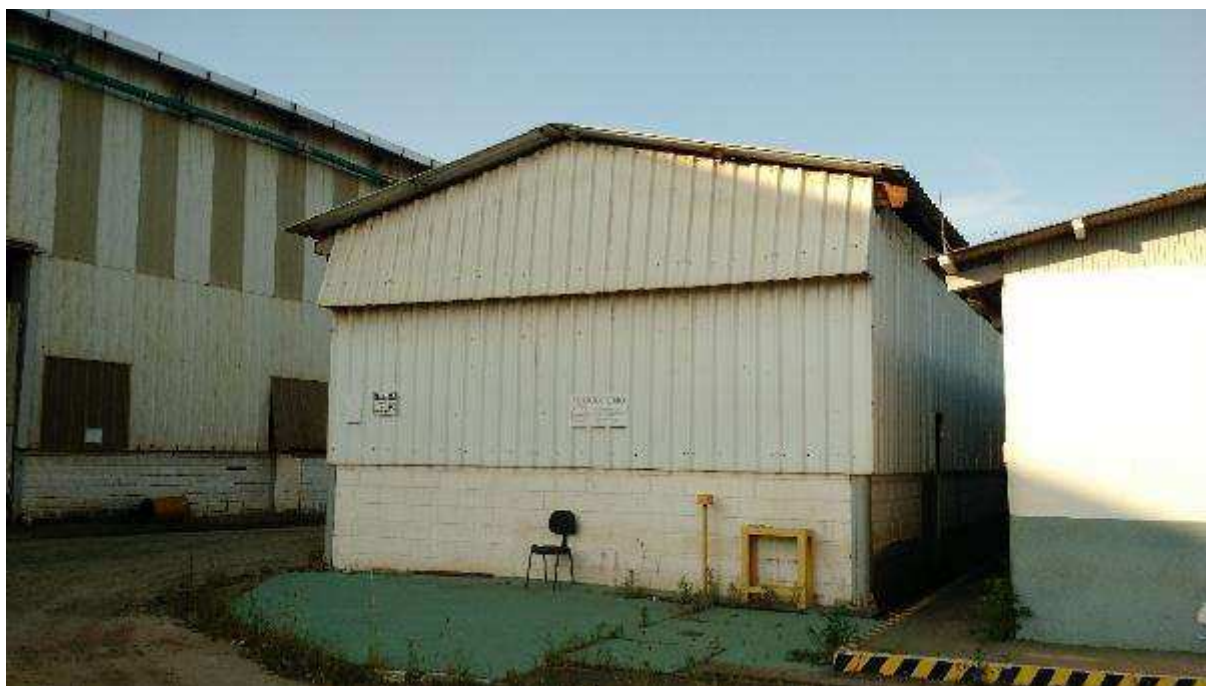
VISTA PARCIAL INTERNA DO IMÓVEL – DETALHE GALPÃO
