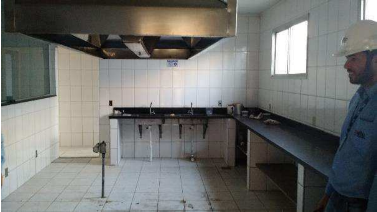
VISTA PARCIAL INTERNA DO REFEITORIO
