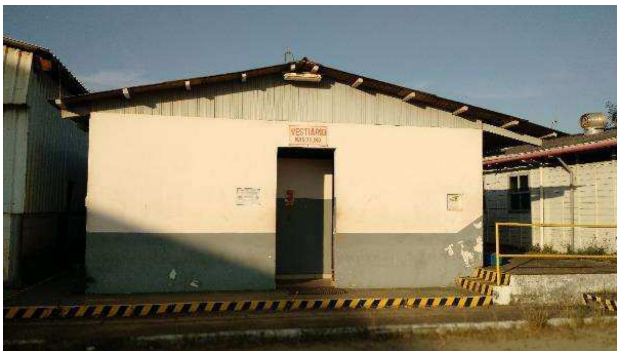
VISTA PARCIAL INTERNA DO IMÓVEL – DETALHE VESTIÁRIO
