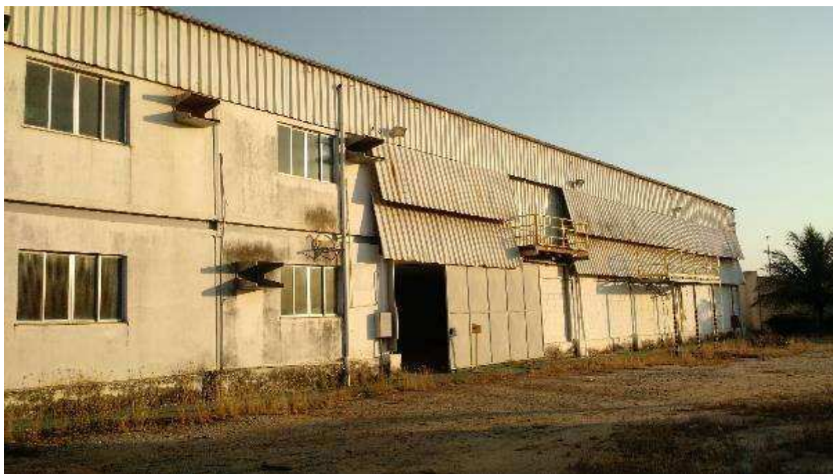
VISTA PARCIAL INTERNA DO IMÓVEL – DETALHE GALPÃO
