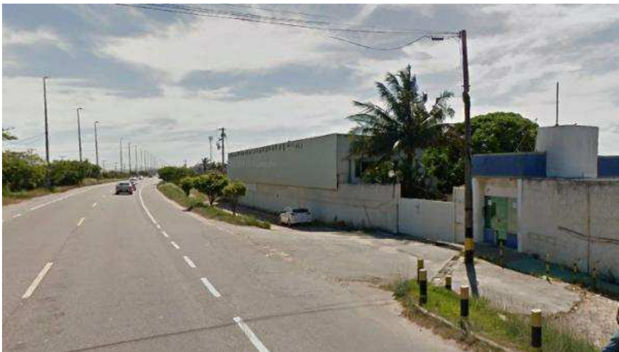
VISTA PARCIAL RODOVIA AMARAL PEIXOTO – SENTIDO RIO DAS OSTRAS
