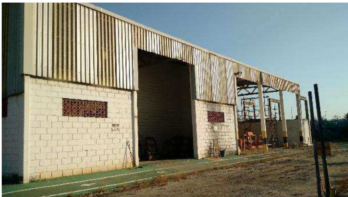
VISTA PARCIAL INTERNA DO IMÓVEL – DETALHE GALPÃO
