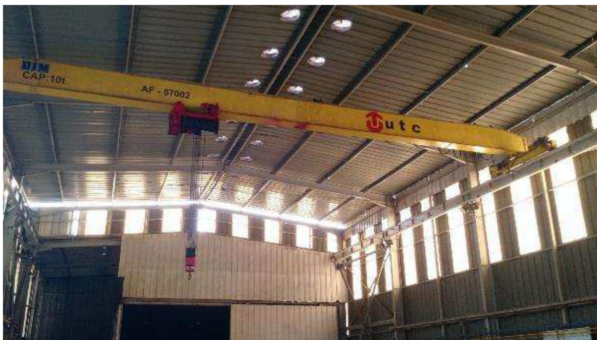
VISTA PARCIAL INTERNA DO IMÓVEL – PONTE ROLANTE 10 TON.
