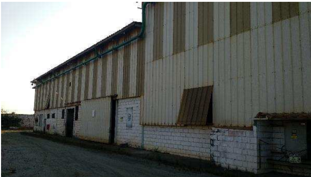
VISTA PARCIAL INTERNA DO IMÓVEL – DETALHE GALPÃO
