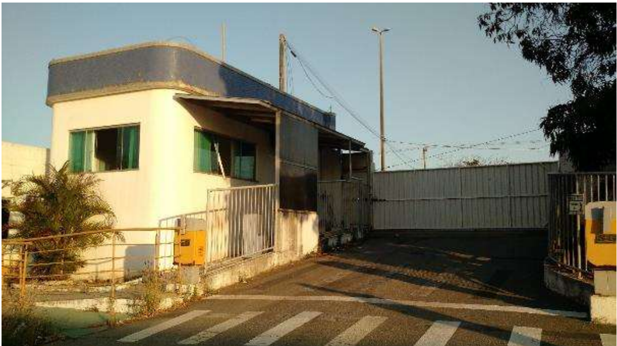
VIA PARCIAL INTERNA DO IMÓVEL – DETALHE GUARITA
