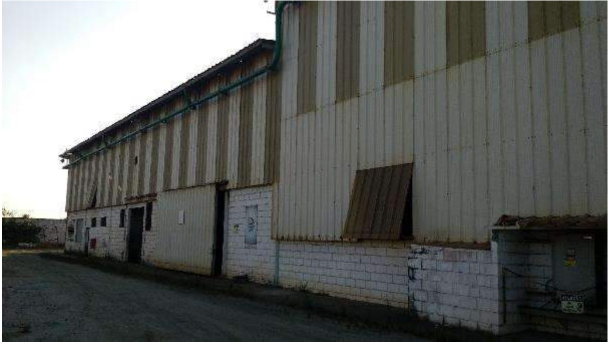
VISTA PARCIAL INTERNA DO IMÓVEL – DETALHE GALPÃO
