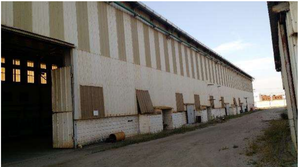
VISTA PARCIAL INTERNA DO IMÓVEL – DETALHE GALPÃO
