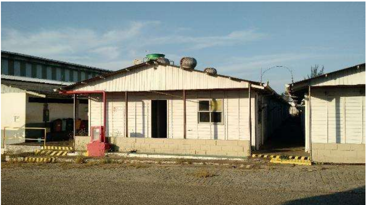
VISTA PARCIAL INTERNA DO IMÓVEL – DETALHE ESCRITÓRIOS
