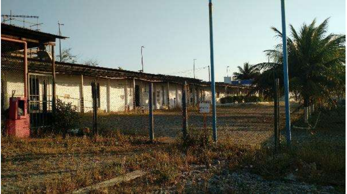
VISTA PARCIAL INTERNA DO IMÓVEL
