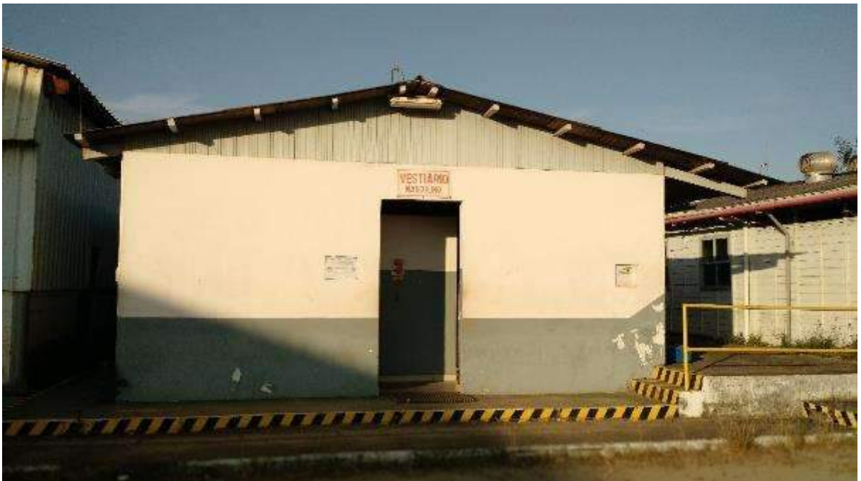
VISTA PARCIAL INTERNA DO IMÓVEL – DETALHE VESTIÁRIO
