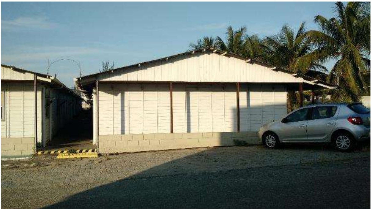
VISTA PARCIAL INTERNA DO IMÓVEL – DETALHE ESCRITÓRIOS
