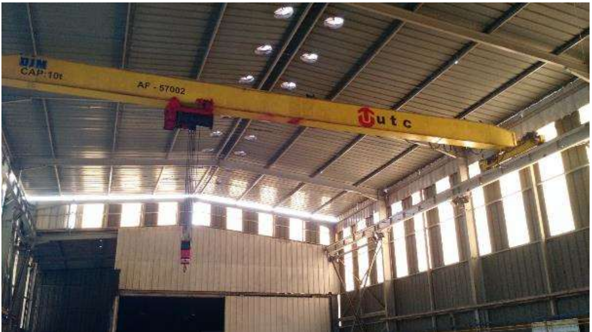
VISTA PARCIAL INTERNA DO IMÓVEL – PONTE ROLANTE 10 TON.
