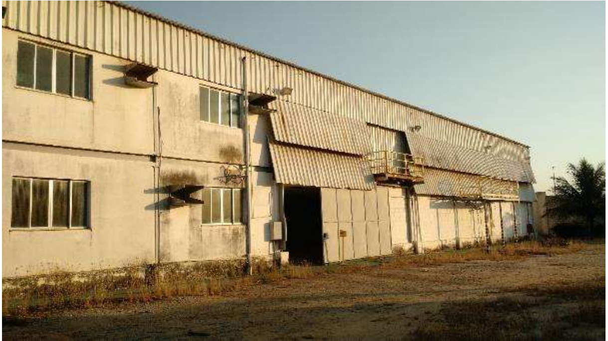
VISTA PARCIAL INTERNA DO IMÓVEL – DETALHE GALPÃO
