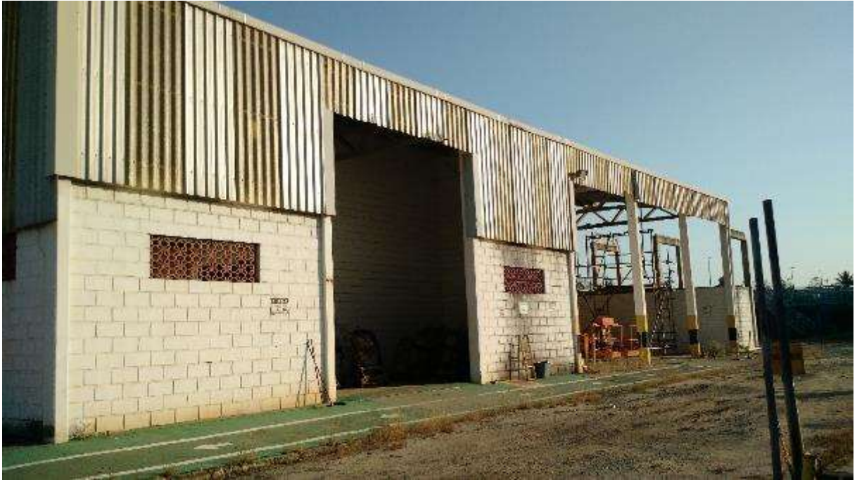
VISTA PARCIAL INTERNA DO IMÓVEL – DETALHE GALPÃO
