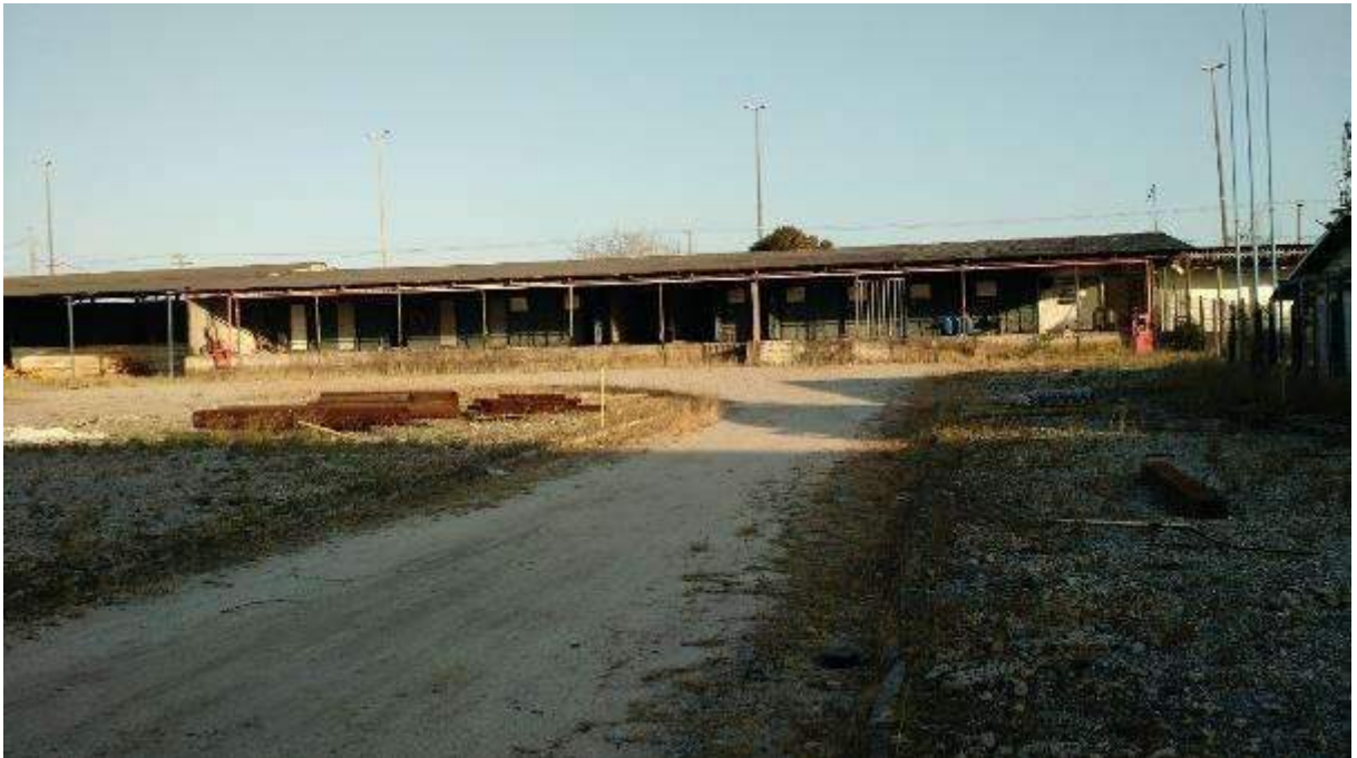
VISTA PARCIAL INTERNA DO IMÓVEL
