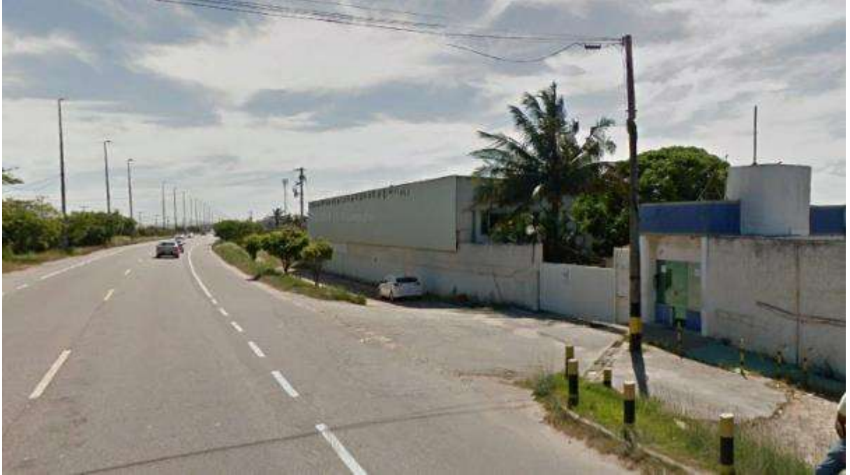
VISTA PARCIAL RODOVIA AMARAL PEIXOTO – SENTIDO RIO DAS OSTRAS
