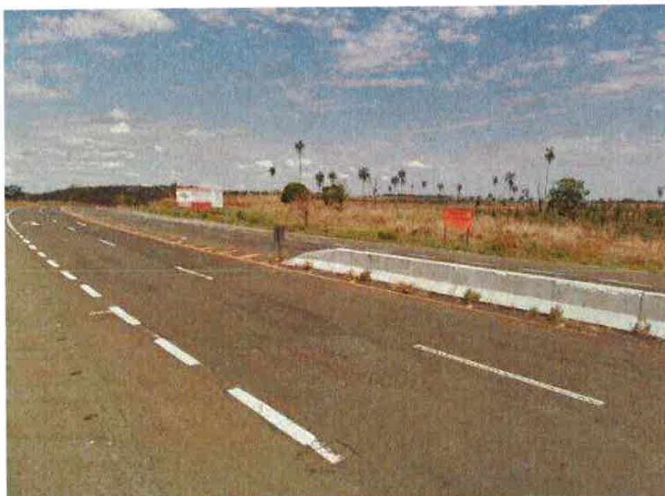
VISTA PARCIAL RODOVIA SP-320 SENTIDO TRÊS FRONTEIRAS/SP – DETALHE ACESSO AO TERRENO AVALIANDO
