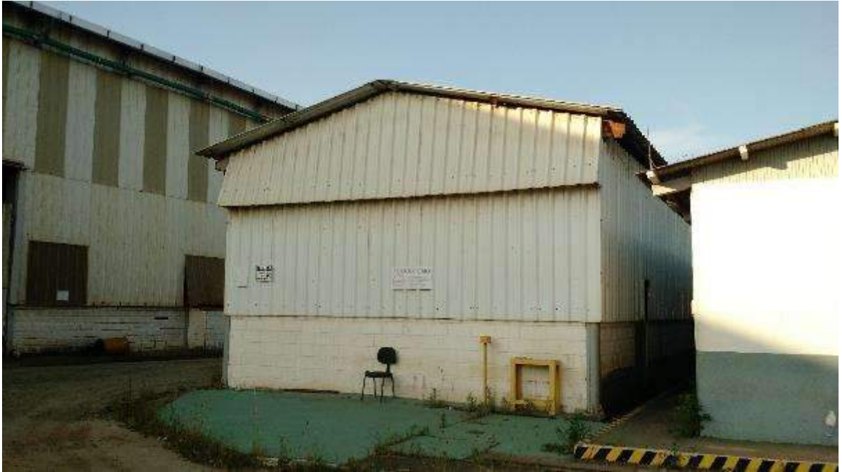
VISTA PARCIAL INTERNA DO IMÓVEL – DETALHE GALPÃO
