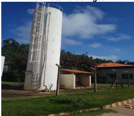
Reservatório de Água
