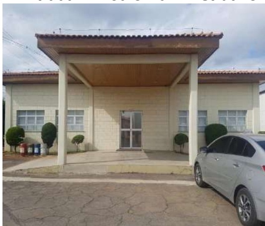
Entrada – Prédio Administrativo
