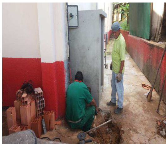
Obra na Caixa D'Água
