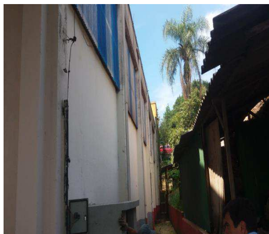
Lateral da Fábrica
