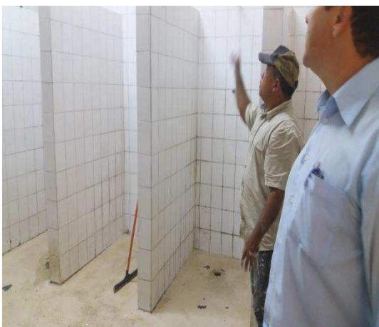
Obra No Vestiário
