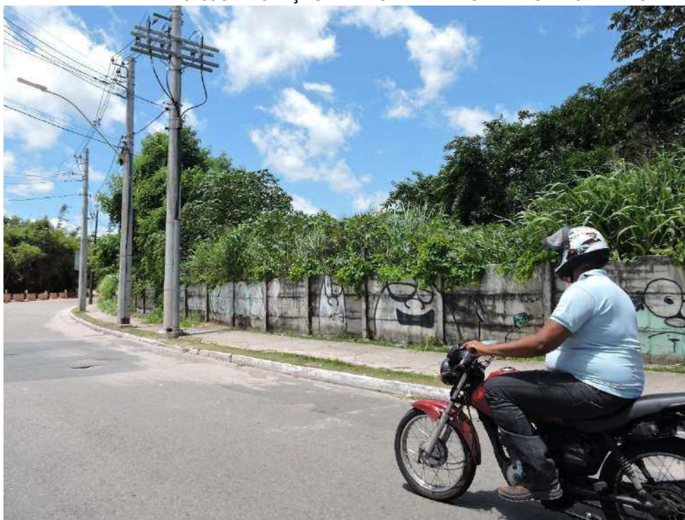
VISTA PARCIAL EXTERNA DA GLEBA AVALIANDO – MATRÍCULA 62.893 ÁREA 01-A – FRENTE PARA A AVENIDA LUIS VIANA DETALHE PARA ESQUINA COM A VIA MARGINAL DA AVENIDA 29 DE MARÇO
