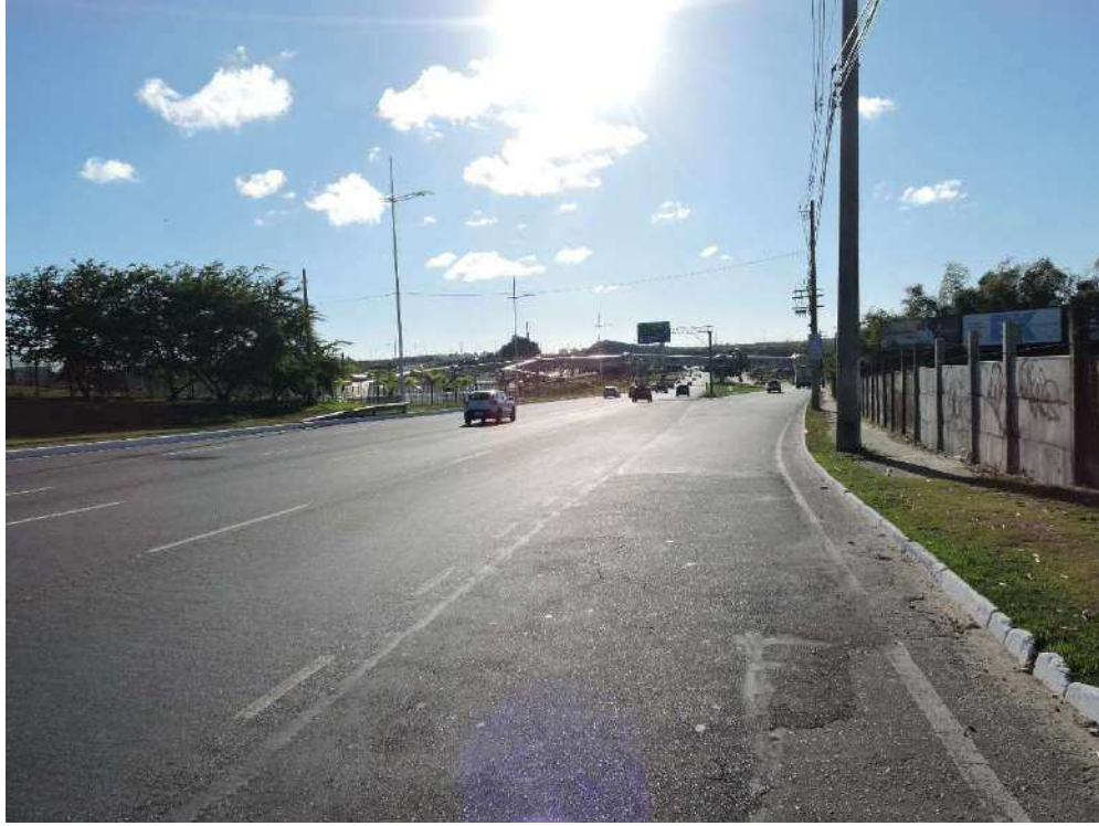
VISTA PARCIAL AV LUIS VIANA SENTIDO ALPHAVILLE I
