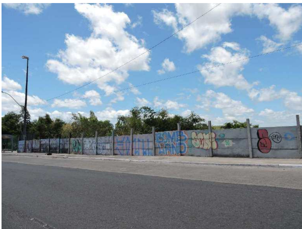
VISTA PARCIAL EXTERNA DA GLEBA AVALIANDO – MATRÍCULA 62.893 ÁREA 01-A – FRENTE PARA A AVENIDA LUIS VIANA
