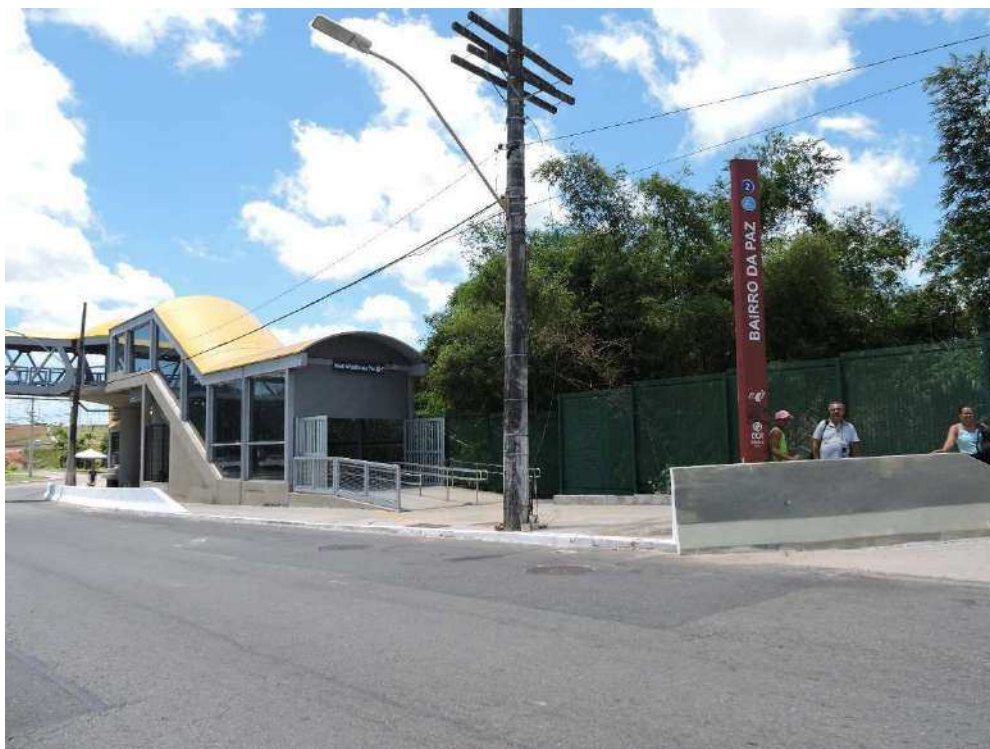
VISTA PARCIAL EXTERNA DA GLEBA AVALIANDO – MATRÍCULA 62.893 ÁREA 01-A – FRENTE PARA A AVENIDA LUIS VIANA DETALHE PARA ACESSO A ESTAÇÃO BAIRRO DA PAZ DO METRO DE SALVADOR
